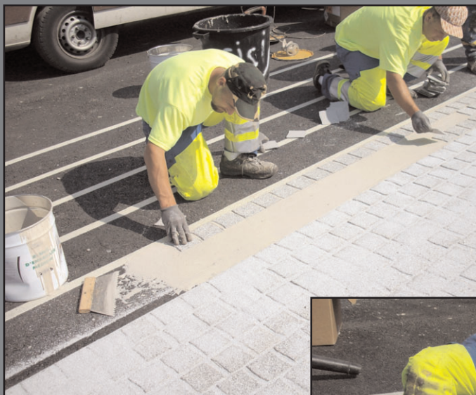
Mise en oeuvre des « pavés de résine »
