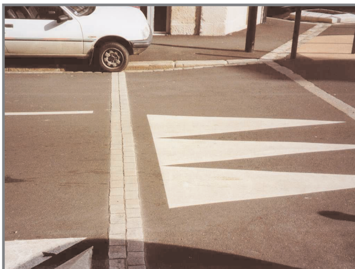
Bandes transversales en « pavés de résines » sous forte circulation
