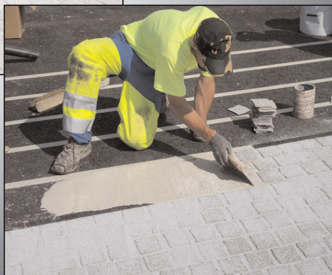
Mise en oeuvre des « pavés de résine »
