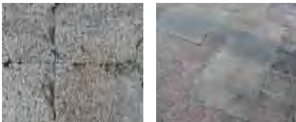
Figuras 17 y 18. Deterioro en los encuentros entre las piezas de solado y operaciones de mantenimiento.
