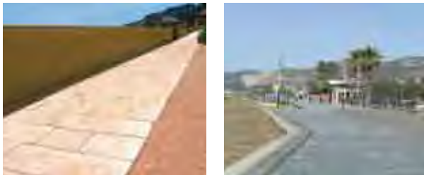
Figuras 26 y 27. Imágenes de pavimentos al mismo nivel con diferenciación de texturas y color.
