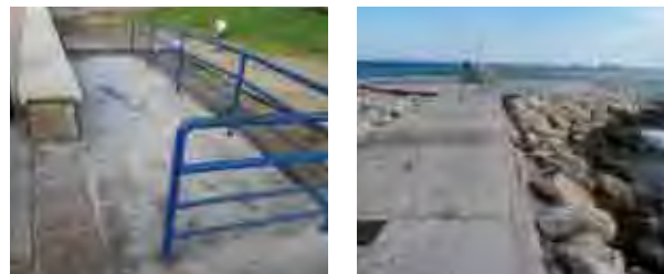
Figuras 19 y 20. Pavimento de hormigón in situ en rampas y espigones.
