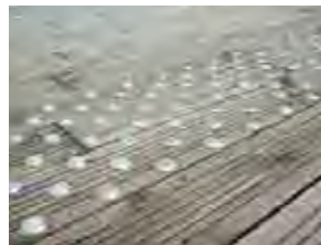
Rampa con pavimento antideslizante para acceso a la playa. Botones pododáctiles de señalización incorporados al pavimento de madera.
