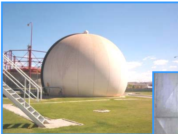
Depósito de gas
