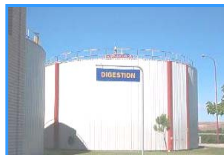
Digestor de fangos
