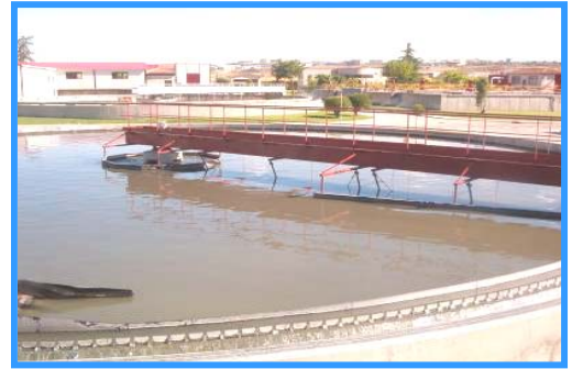
Decantador clarificador
