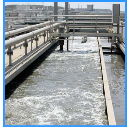
Canal de desarenado.
