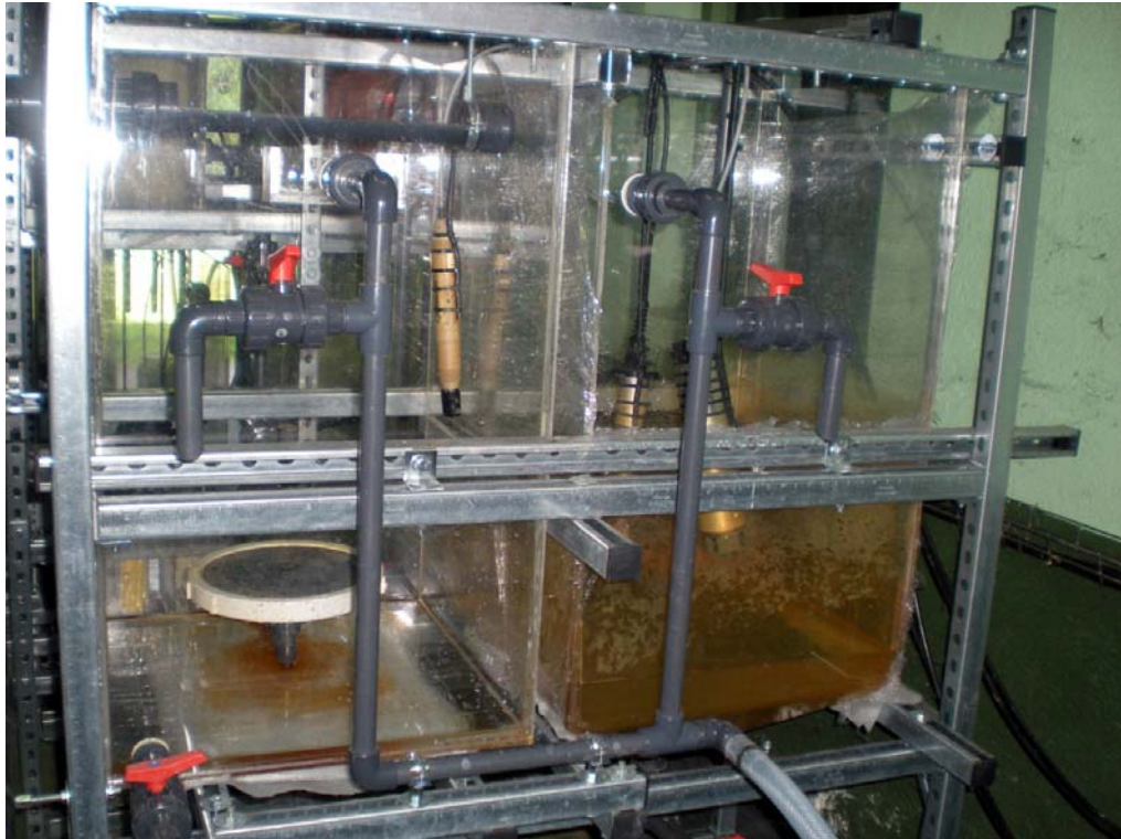
Figura 6.10. Vista del decantador y flotador
