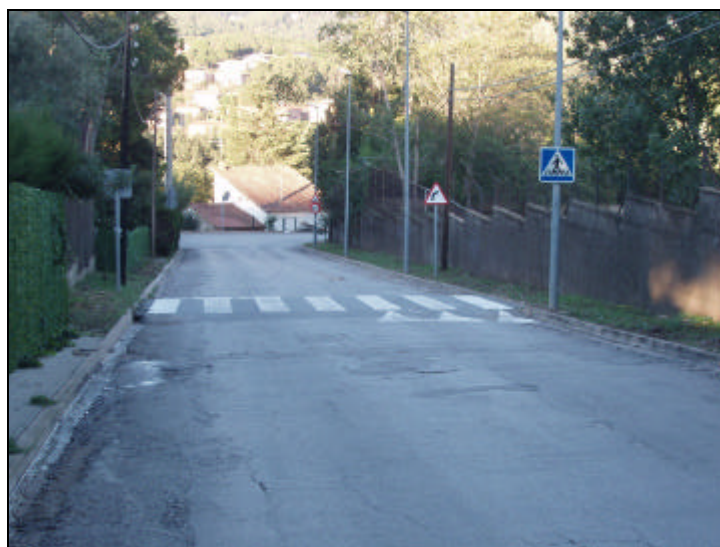
Figura 26: Paso de peatones a acera impracticable.
