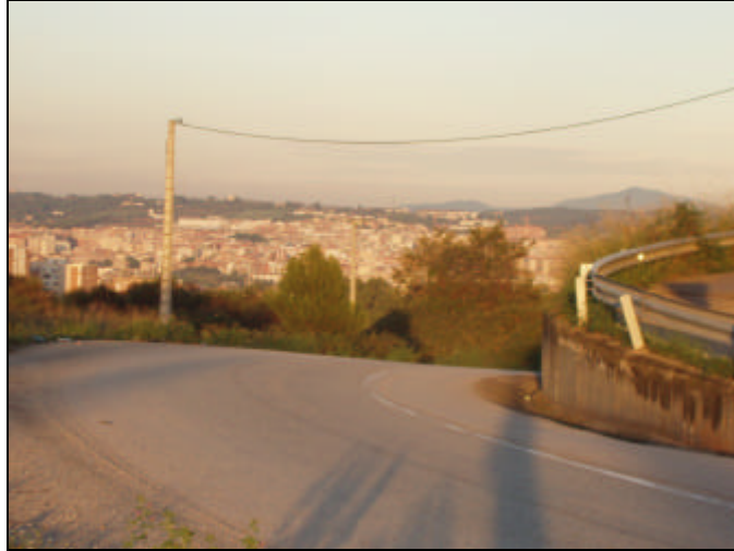
Figura 18: Ejemplo de falta de legibilidad en el trazado.
