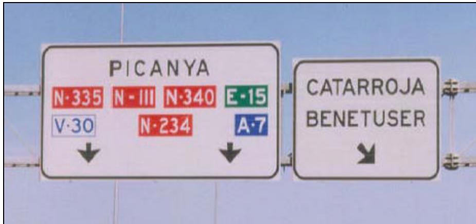
Figura 20: Ejemplo de información excesivamente técnica e incomprensible. Fuente: Exposición de Xavier Baulés en Curso de Auditorías de Seguridad Vial.
