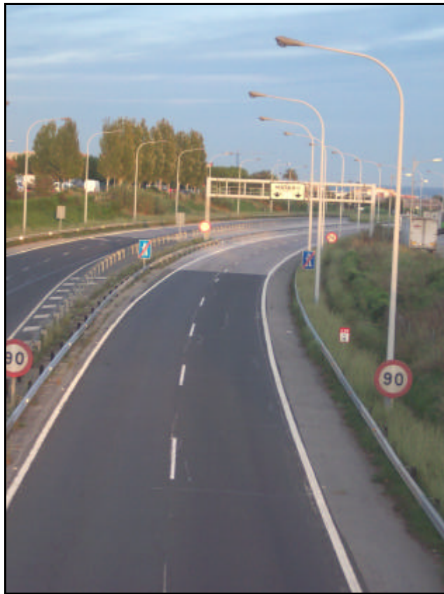
Figura 38: Tramo de estudio empírico.
