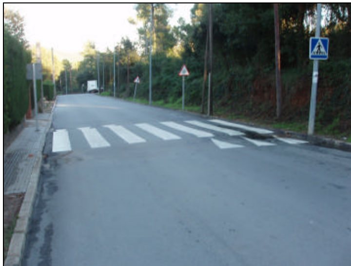
Figura 25: Paso de peatones a acera impracticable.
