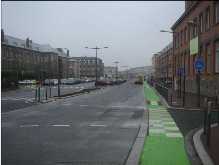
Photo 8: example road layout on Avenue du Maréchal Leclerc in Douai (source: CETE Nord-Picardie)
