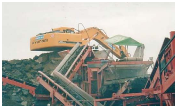
Obra de reciclado en el Aeropuerto de Barajas T4, Madrid.
