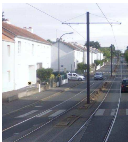
Foto 4.11 Refugio para cruce de peatones en plataforma compartida en Nantes. Práctica a evitar. (Fuente: Google Earth, 2009)
