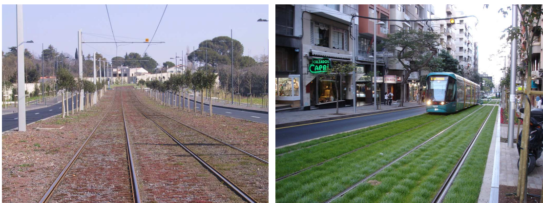
Fotos 4.5 a) Izquierda: posición central, Montpellier. b) Derecha: posición lateral, Tenerife. (Autor: F. Carrasco)
