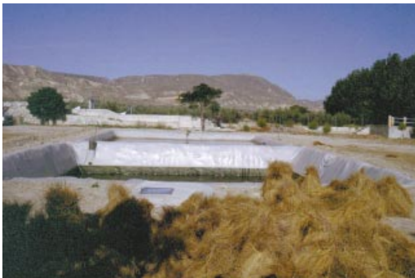
Foto 7.5 En primer plano la balsa de decantación, en segundo plano la balsa almacén.
