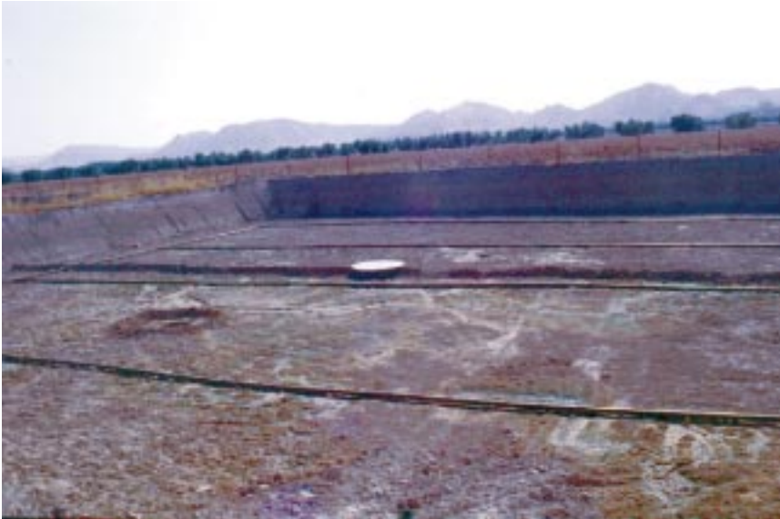
Foto 7.4 Vista general de una de las balsas de infiltración.
