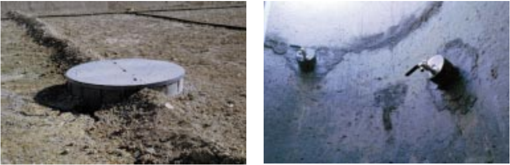
Foto 7.7 Vista de los pozos con drenes horizontales, pueden apreciarse en su interior los grifos de muestreo.
