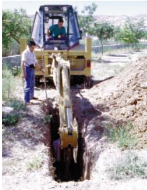
Foto 3.9 Mediante la excavación de catas es posible la medida de la capacidad de infiltración de los diferentes horizontes del suelo.
