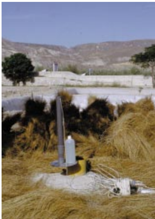
Foto 7.6 Piezometro de control de la calidad del agua subterránea. Es un sondeo totalmente penetrante en el acuífero entubado en toda su longitud.
