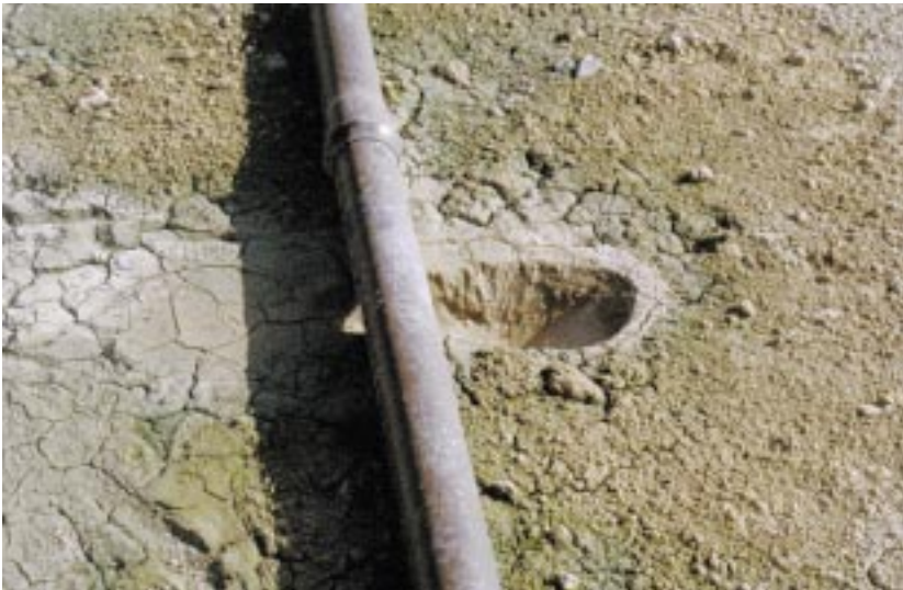
Foto 4.1 Es necesario evitar, en la medida de lo posible, la erosión producida por el impacto del agua en el lecho de la balsa de infiltración.
