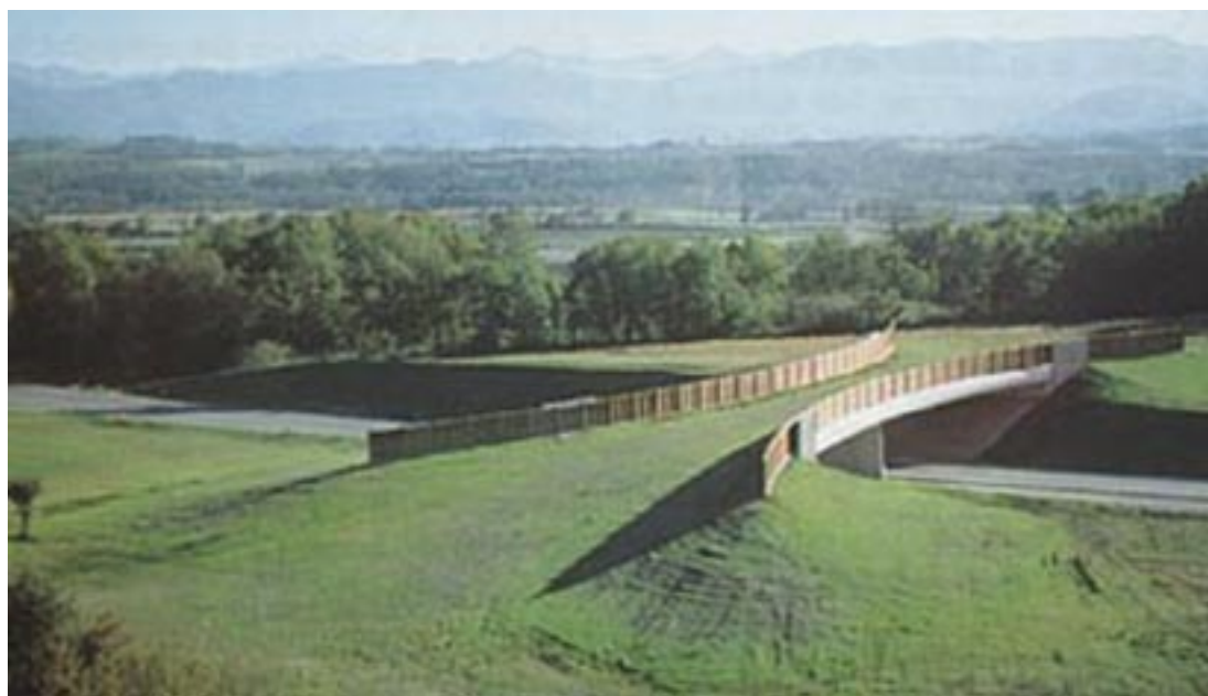
Figura 75. Realizzazione di un passaggio per la grande fauna lungo l'A89.
