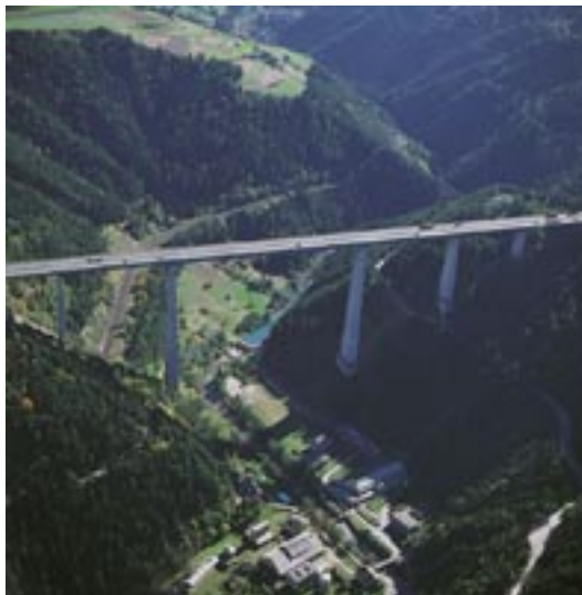
Figure 9-10. Vedute aeree dell'Europabrücke.
