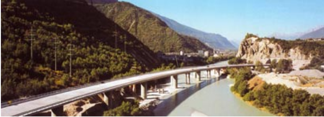
Figura 17. Viaduc de l'Ile Falcon composto da due carreggiate indipendenti presso Gèronde.
