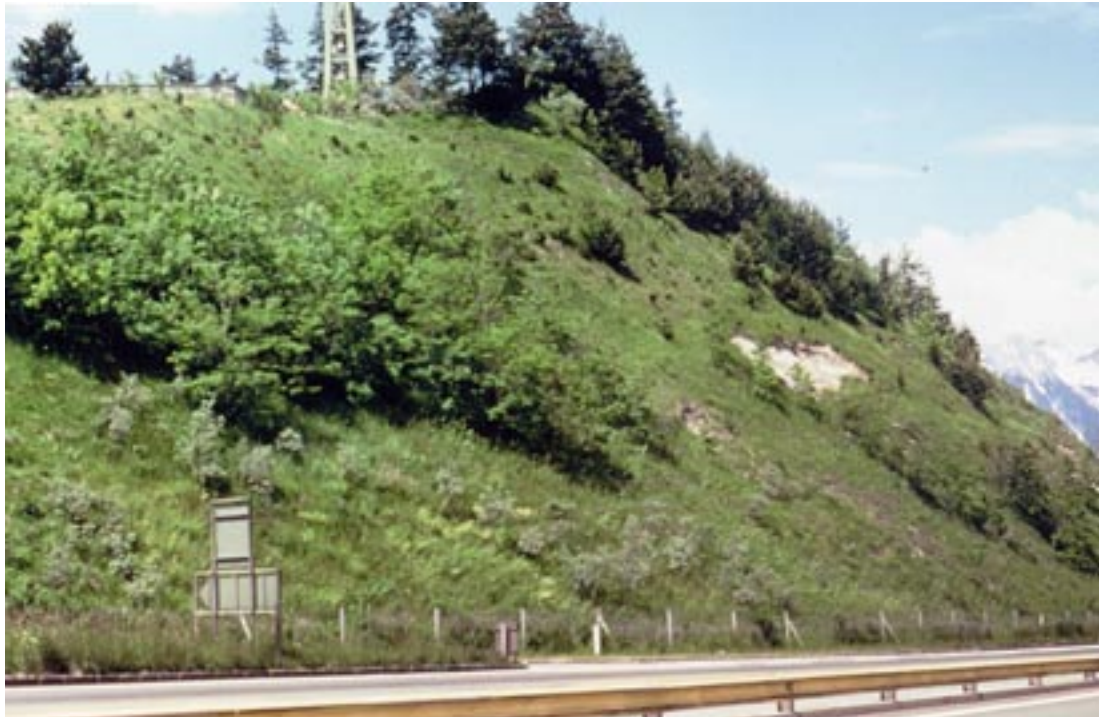
Figura 15. Schiechtl. Opere di ingegneria naturalistica lungo l'autostrada del Brennero: la grata viva dopo cinque anni dalla realizzazione (1972).
