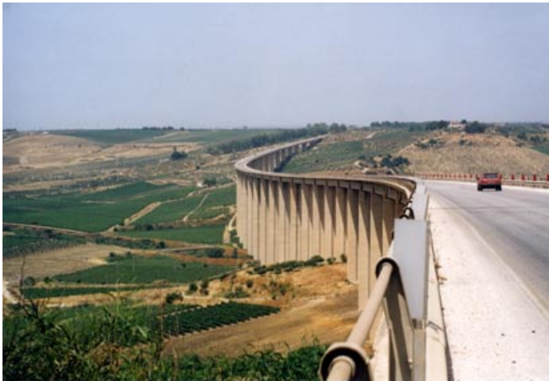
Figura 14. Un viadotto della strada statale n. 115 tra Castel Vetrano e Menfi (Sicilia) che attraversa con imponenza una valle agricola
