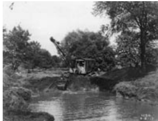
Figura 7. Operazione di dragaggio nel fiume (marzo 1921).
