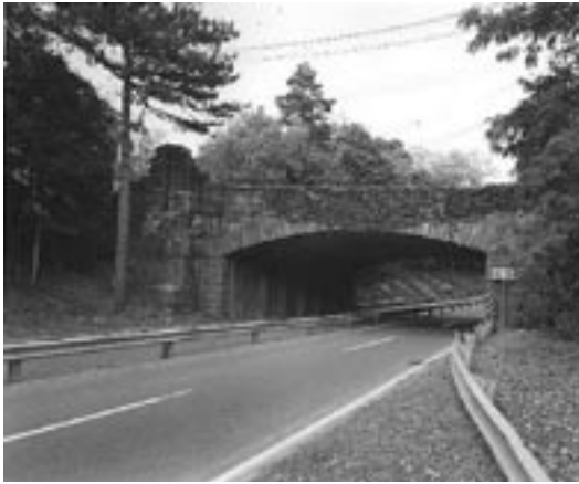
Figura 20. Pondfield Road bridge (ottobre 2001).
