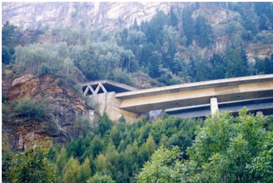
Figura 7. Spalla del viadotto di Monte.
