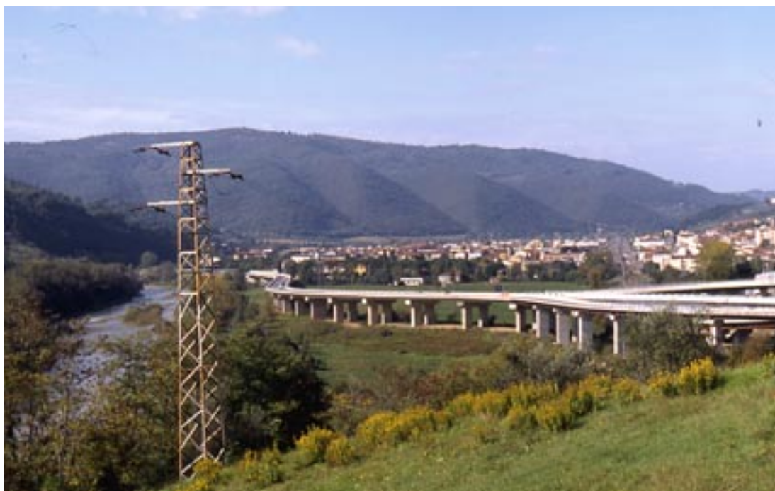
Figura 34. Strada Statale Tosco-Romagnola n. 67 in prossimità del centro urbano di Pontassieve (Firenze). Una particolare nota viene dedicata a quelle strade a servizio di un ambito più locale rispetto a quello delle autostrade e delle superstrade. Sono manufatti in genere realizzati dalle Amministrazioni locali per deviare il traffico veicolare al di fuori dei centri abitati, o per adeguare vecchi percorsi particolarmente transitati. Le caratteristiche con cui questi vengono concepiti sono del tutto simili a quelli della viabilità destinata allo scorrimento veloce e anche in questo caso il loro rapporto con il contesto, per lo più aree di frangia di centri urbani minori e aree agricole, è decisamente fuori scala e di completa estraneità. In questo caso la nuova strada è collocata tra l'area urbana e il fiume Arno, togliendo così ogni collegamento naturale, funzionale e diretto tra collina, centro abitato e fiume.
