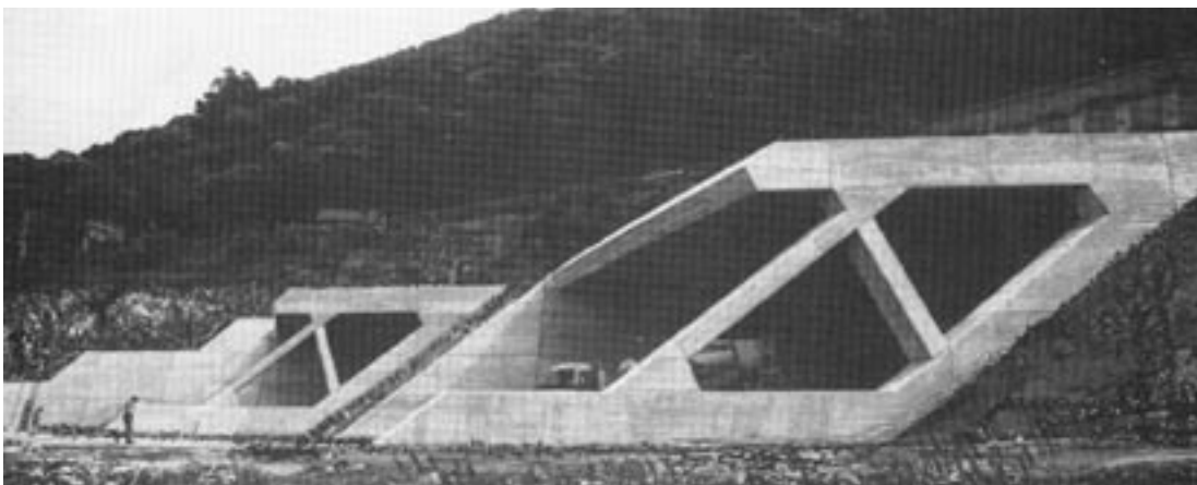
Figura 6. Portali a nord della galleria al Ceneri.
