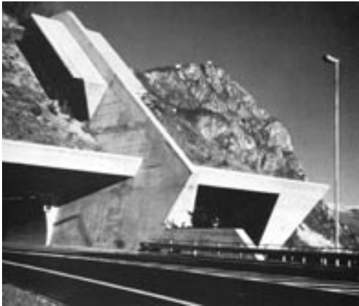
Figura 4. Portale sud della galleria Melide-Grancia.
