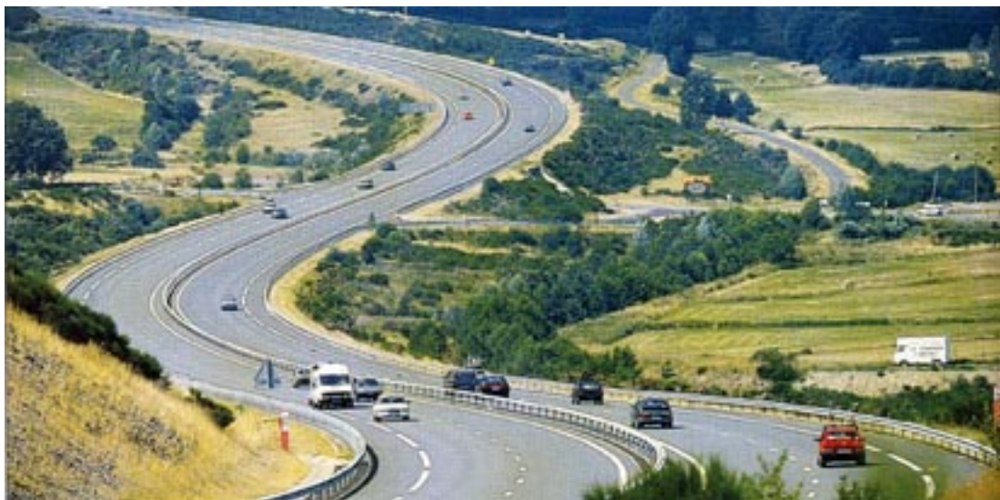
Figura 3. Autoroute A72. La fluidità del tracciato segue la morfologia dei Monti Furez offrendo ampie visuali che si spingono anche in lontananza (Foto: Direction des Routes, E. Bernard).
