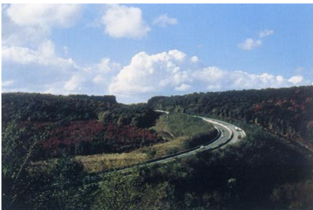
Figura 62. Immagine durante i lavori autostradali sull'A89.
