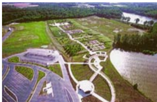
Figura 73. Veduta dall'alto dell'area di sosta.
