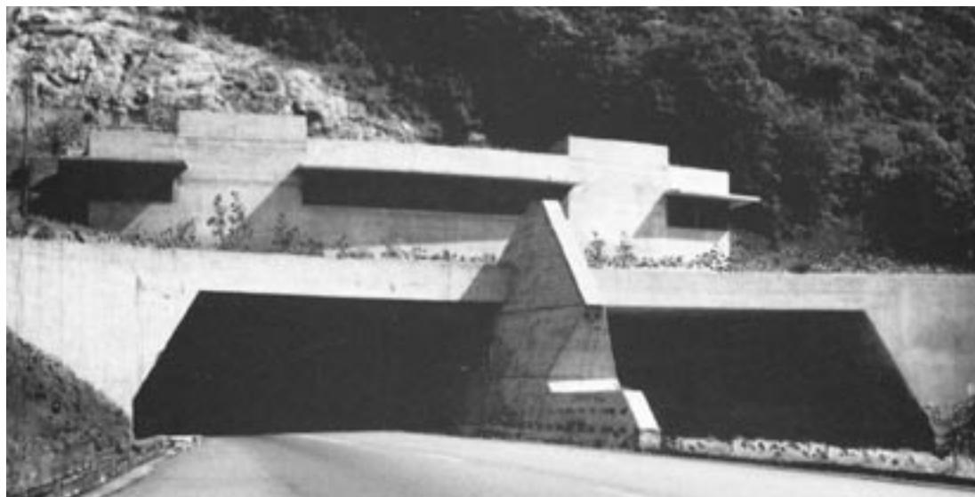
Figura 11. Portale nord della galleria Melide.
