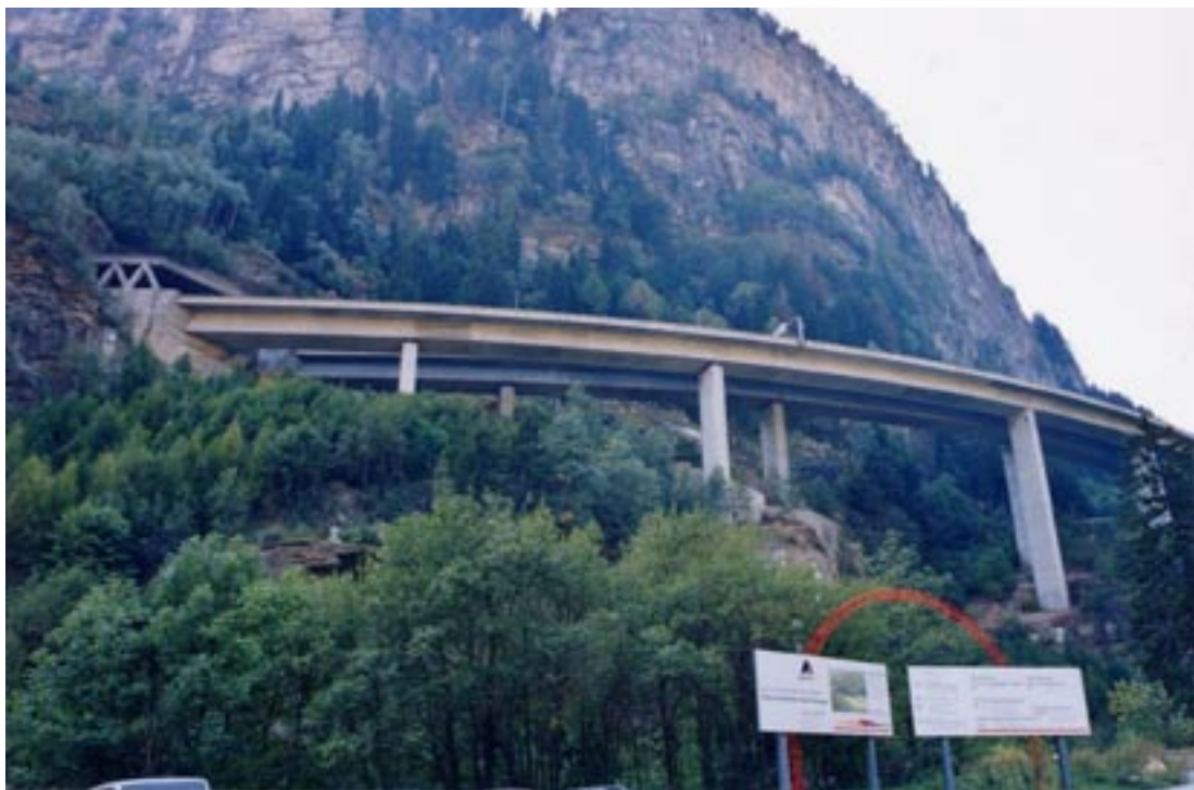
Figura 10. Il viadotto di Monte. Sotto i lavori per la nuova linea ferroviaria ad alta velocità Alptransit .
