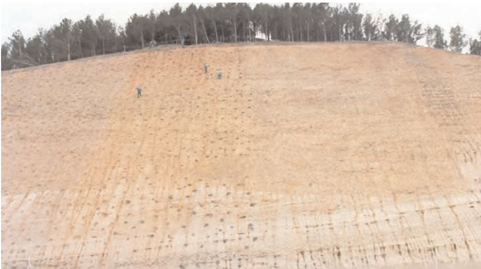
Tractament del gran desmunt amb tècniques de revegetació.
