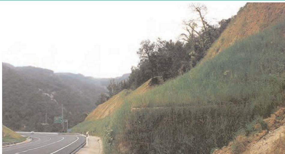
Tractament a peu de talús amb gabions verds durant l'execució i en la primera fase de creixement de la vegetació.
