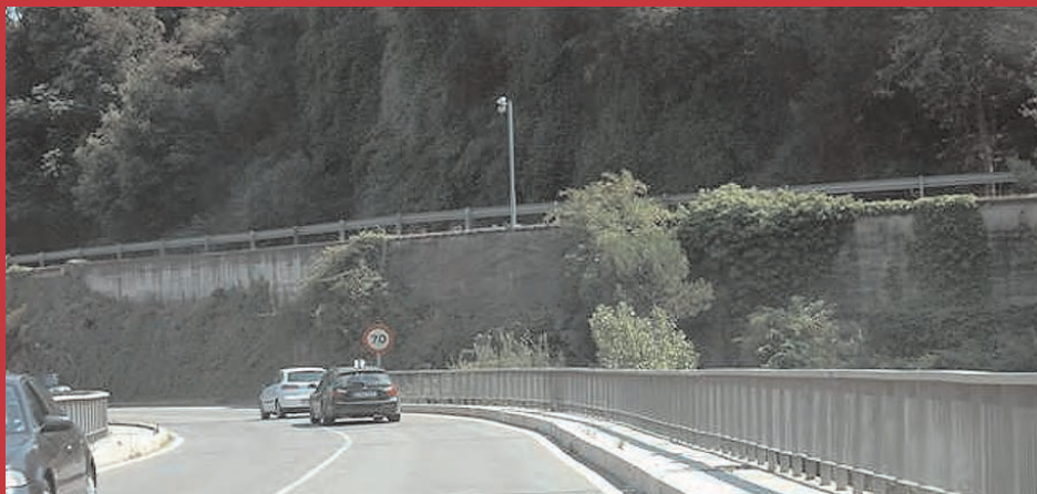
Mur de formigó amb tractament de vegetació que ajuda a millorar la percepció i integrar el mur en el medi.
