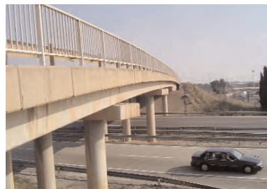
2. Pont amb circulació de vianants. Barrera de seguretat i barana metàl·lica.
