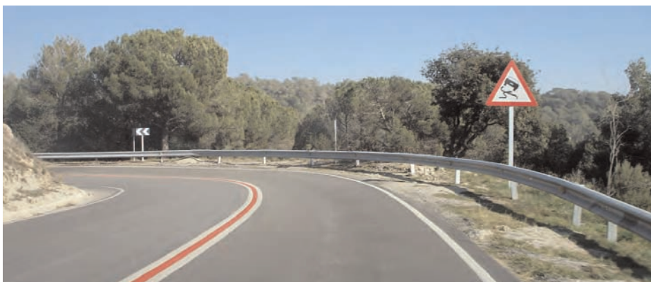
Exemple comparatiu de tractament d'un revolt perillós.
