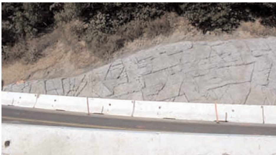
Tractament superficial en mur de formigó in situ .
