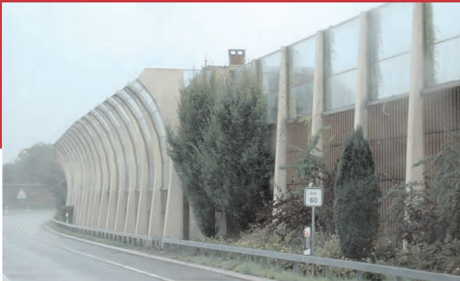
Les pantalles acústiques generen sovint un fort impacte visual, perquè trenquen la continuïtat de l'entorn i tanquen l'usuari a la carretera.
