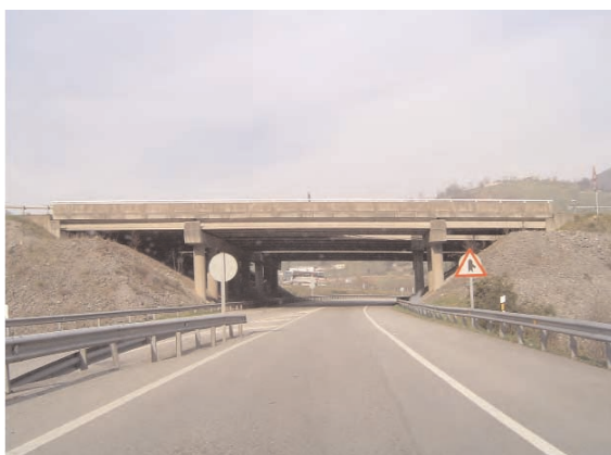
L'ampit de formigó recte perjudica molt l'impacte i la continuïtat visual.
