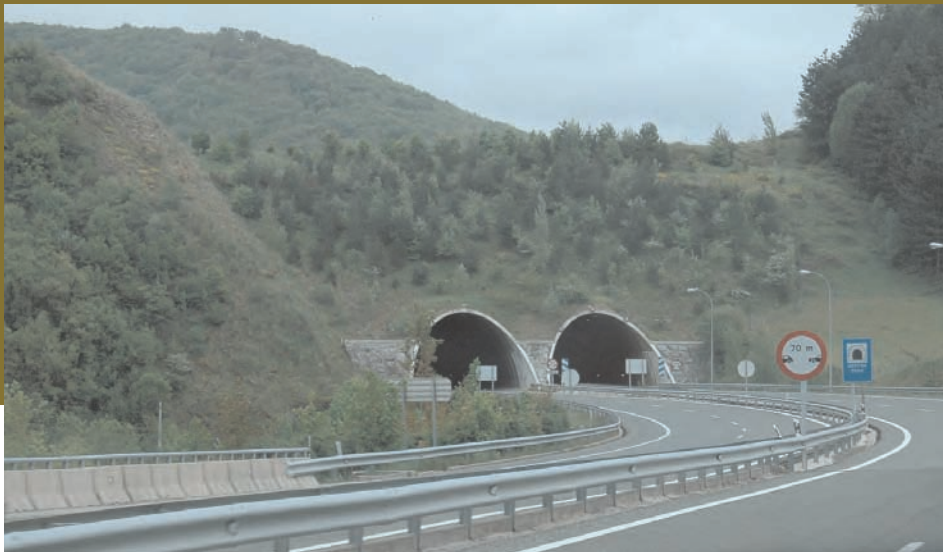
El perllongament artificial del túnel permet restituir la muntanya original.
