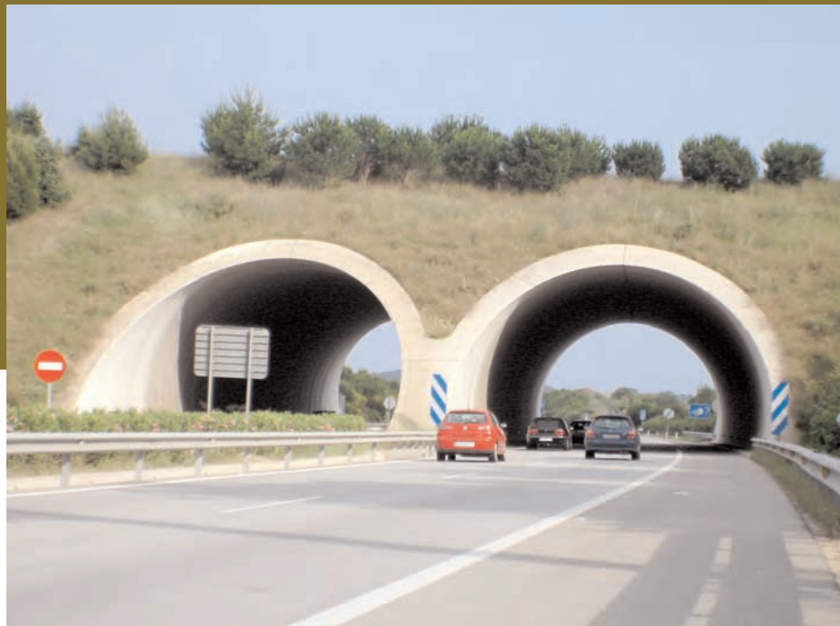
Exemple de boques de túnels.
