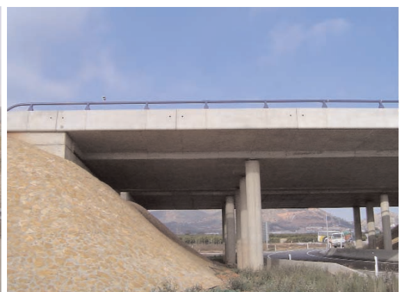
L'ampit de formigó recte perjudica molt l'impacte i la continuïtat visual.
