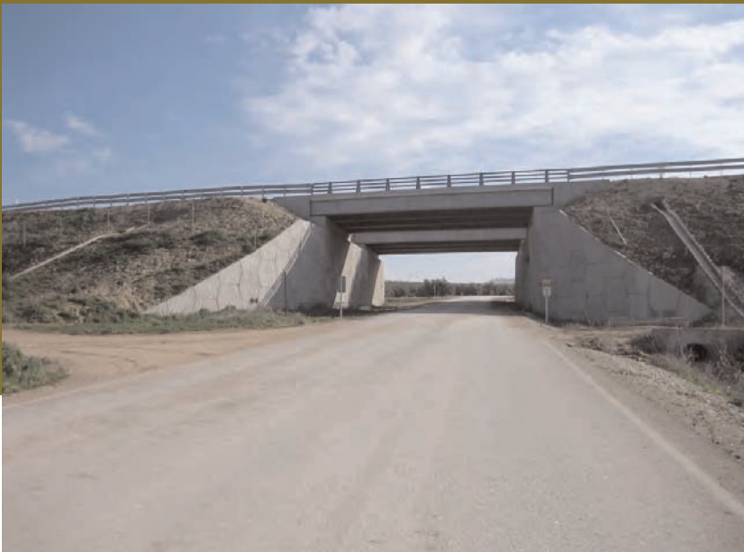
Pas inferior de llarg recorregut amb entrada de llum natural.
