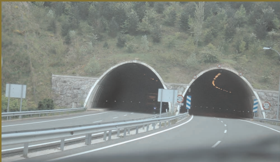
Un bon tractament amb pedra per a rebaixar el talús de la boca.
