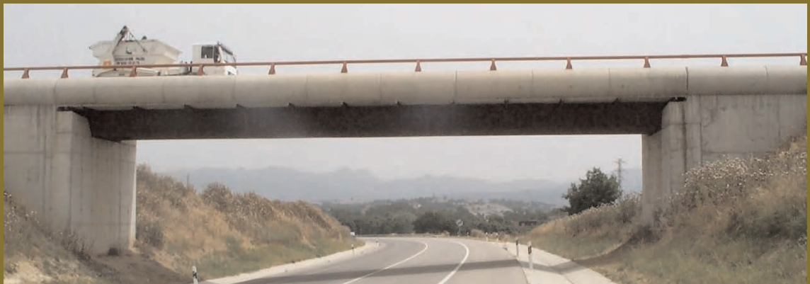
En aquesta fotografia es pot observar com l'ampit de formigó amb panxa dóna una forma poc harmoniosa amb el pont.
