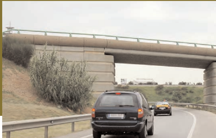
Exemples de diferents acabats de formigó, que ajuden a integrar l'estrep.
