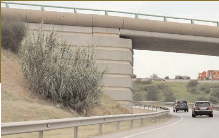
En aquest exemple es pot veure com les aletes en angle recte minimitzen l'impacte.
