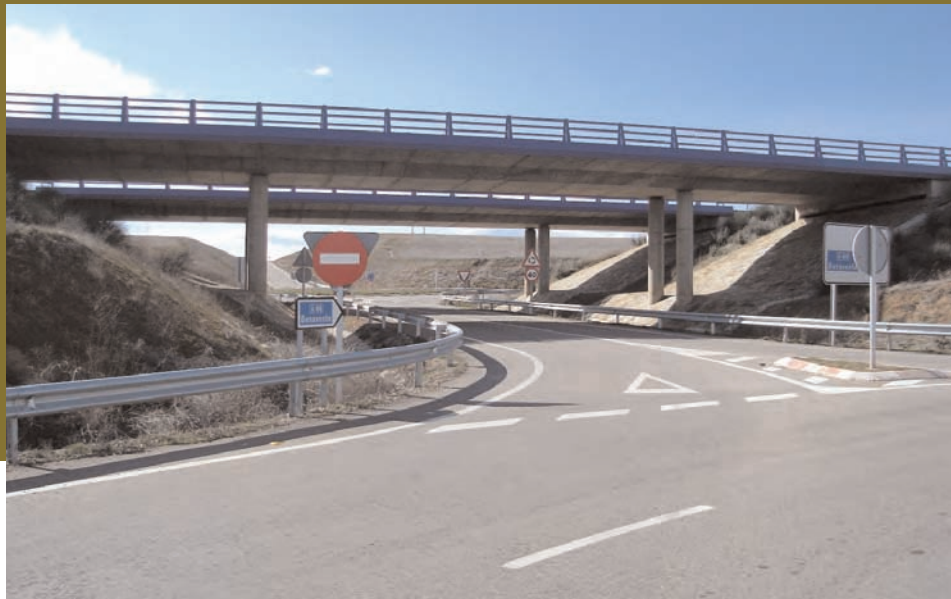
Exemple de bon resultat en l'obtenció de més diafanitat amb l'ús de biga contínua.
