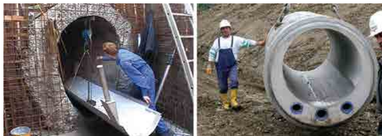
Figura 13. Ejecución de las obras de instalación de intercambiadores: instalado en un colector ovoide existente, e integrado en el hormigón un conducto de sección circular en una nueva construcción. Fuente: ENERES/KASAG.
