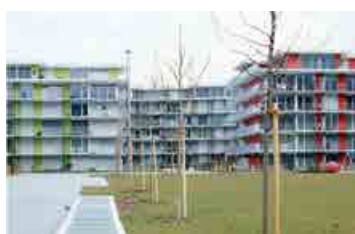
Figura 29. En el distrito de Wässerwiesen en Winterthur, 400 apartamentos están calefactados con energía de intercambio con aguas residuales. Fuente: ENERES/KASAG.
