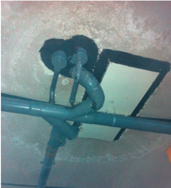
Imagen 1. Imagen visible de una bajante.
