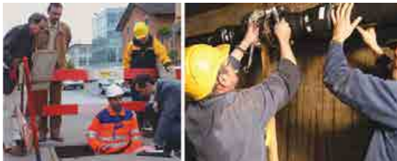
Figura 23. Renovación de un colector cerca de un edificio una instalación de intercambio de energía con las aguas residuales. Fuente: ENERES/KASAG.
