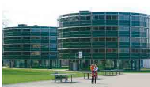
Figura 27. La calefacción de los dos edificios, cada uno con 96 habitaciones individuales, se resuelve con la recuperación del calor de las aguas residuales.
