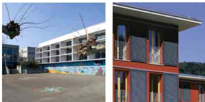
Figura 24. Escuela Spiegelfeld en Binningen climatizada con energía de las aguas residuales. Fuente: ENERES/KASAG.
