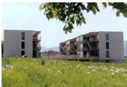
Figura 17. Zurich-Wollishofen, un conjunto de 200 apartamentos se benefician de la recuperación de calor de la red general de aguas residuales. Fuente: ENERES/KASAG.
