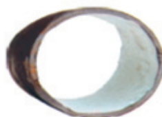
3.- Aplicación de la capa de Epoxi
