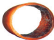
2.- Limpieza realizada con una mezcla de aire y Corindón
