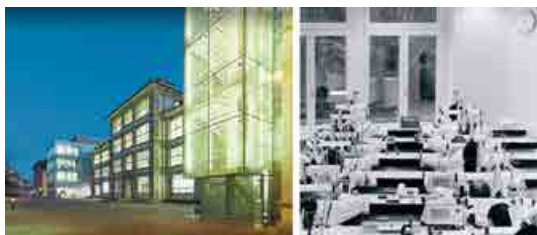
Figura 31. Sede central de la relojera IWC. Schaffhausen. Puestos de trabajo climatizados con la energía recuperada de las aguas residuales. Fuente: ENERES/KASAG.
