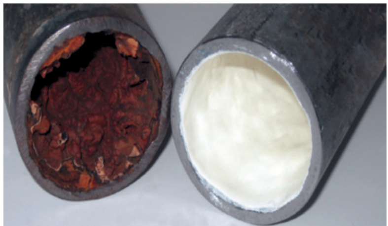
Foto 1. Sección de tubería antes y después del proceso de restauración.
