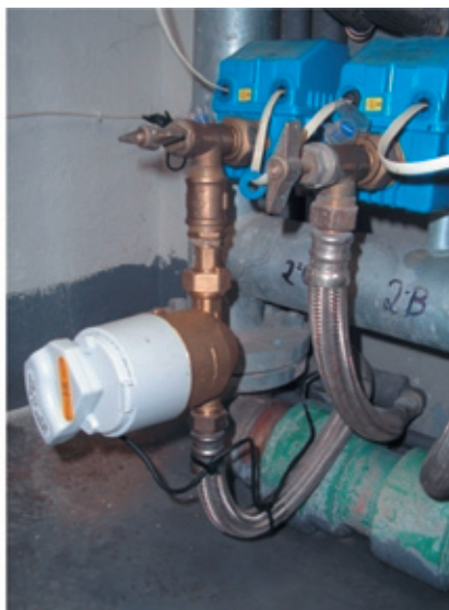
Figura 5. Contador volumétrico con emisor de pulsos.
