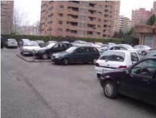
Ausencia de marcas viales.
