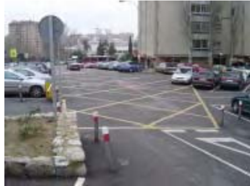
Buen estado de la señalización horizontal.
