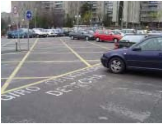
Marca vial reforzando señal vertical.
