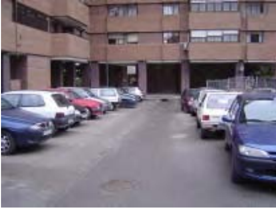
Ausencia de marcas viales.
