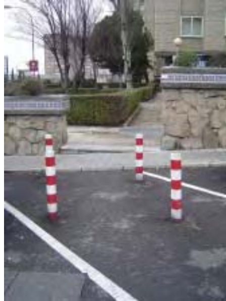
Bolardos impidiendo el aparcamiento de vehículos en las entradas a la urbanización.
