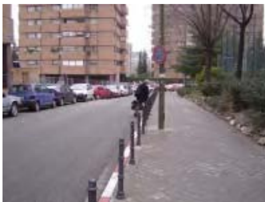
Bolardos instalados en las aceras para evitar el aparcamiento.
