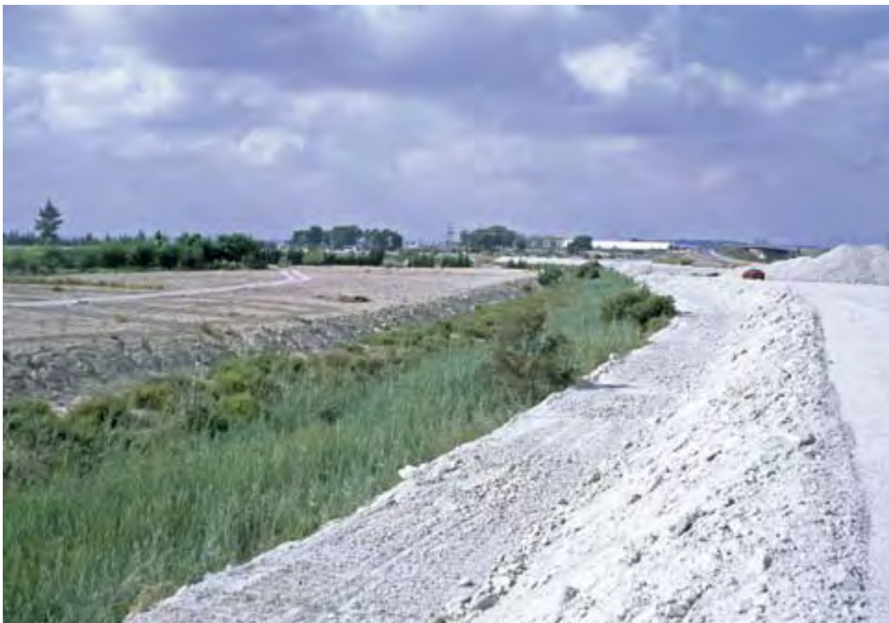
Encauzamiento de una rambla como consecuencia de obras en los cauces.
