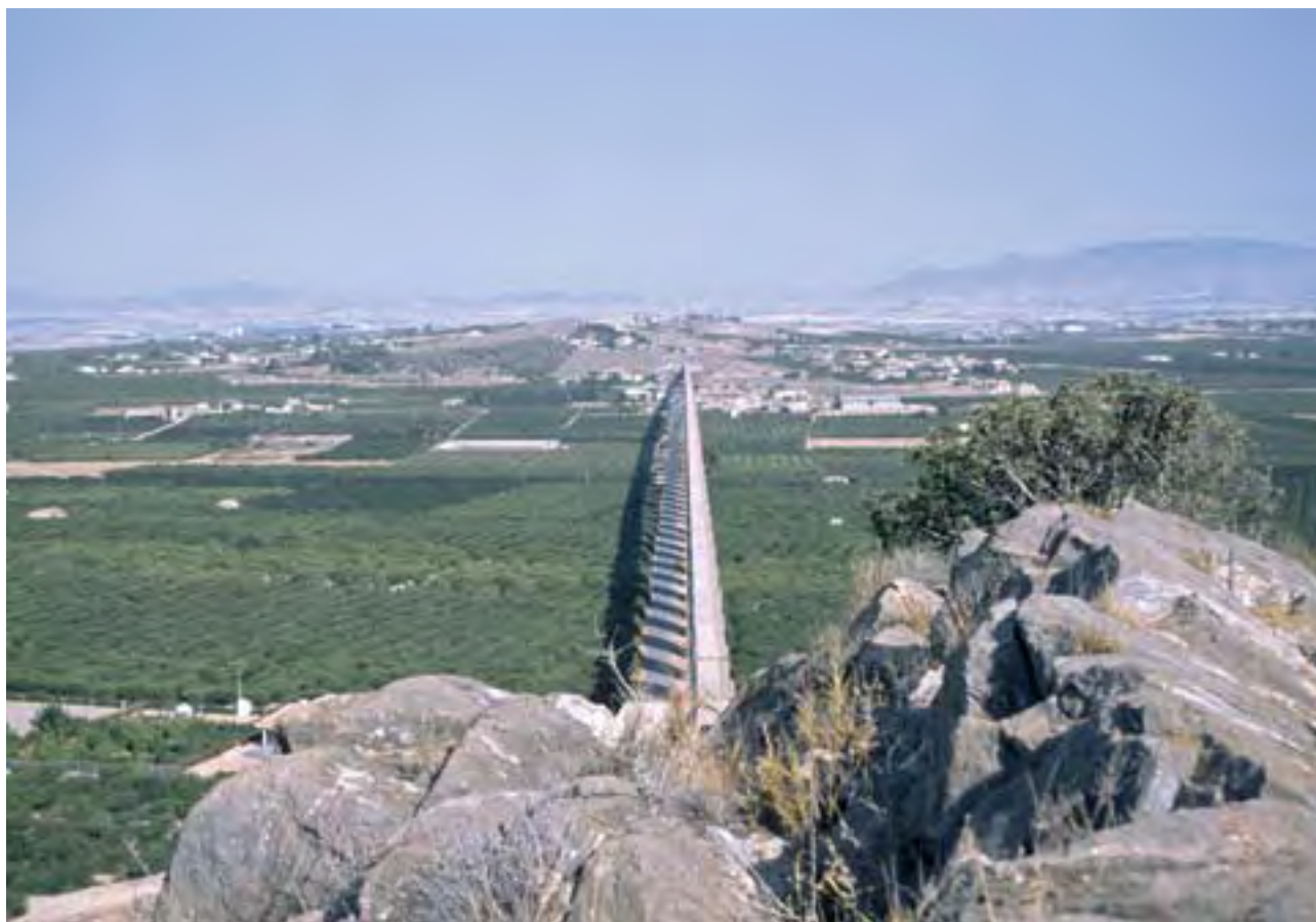
Canal del post-trasvase Tajo-Segura.
