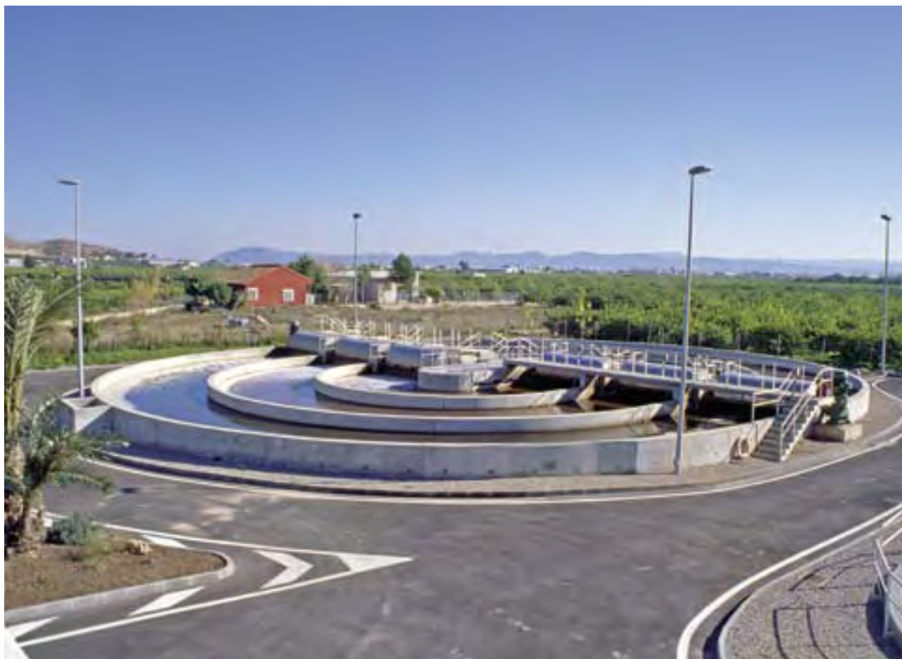
Balsa aerobia de la EDAR de Santomera.
