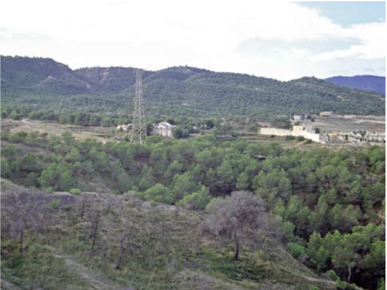
Línea eléctrica de alta tensión.
