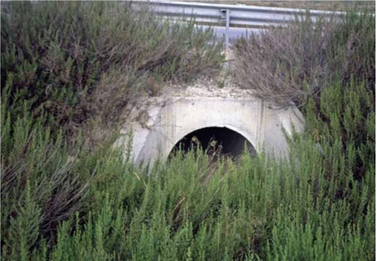
Estructura de evacuación pluvial bajo una carretera que puede ser utilizado como paso de fauna.
