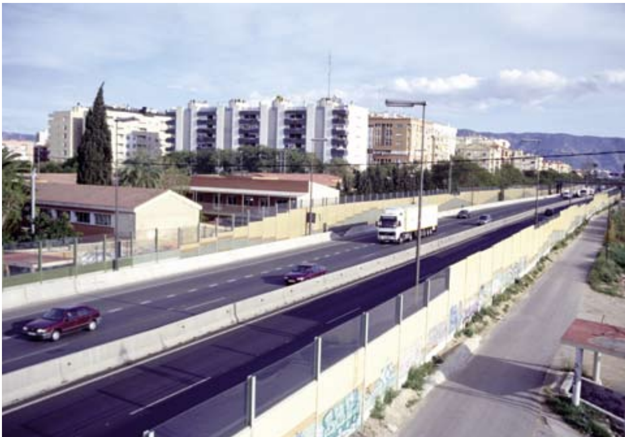
Pantallas de protección acústica a ambos lados de un vial. Autovía Murcia-Cartagena.
