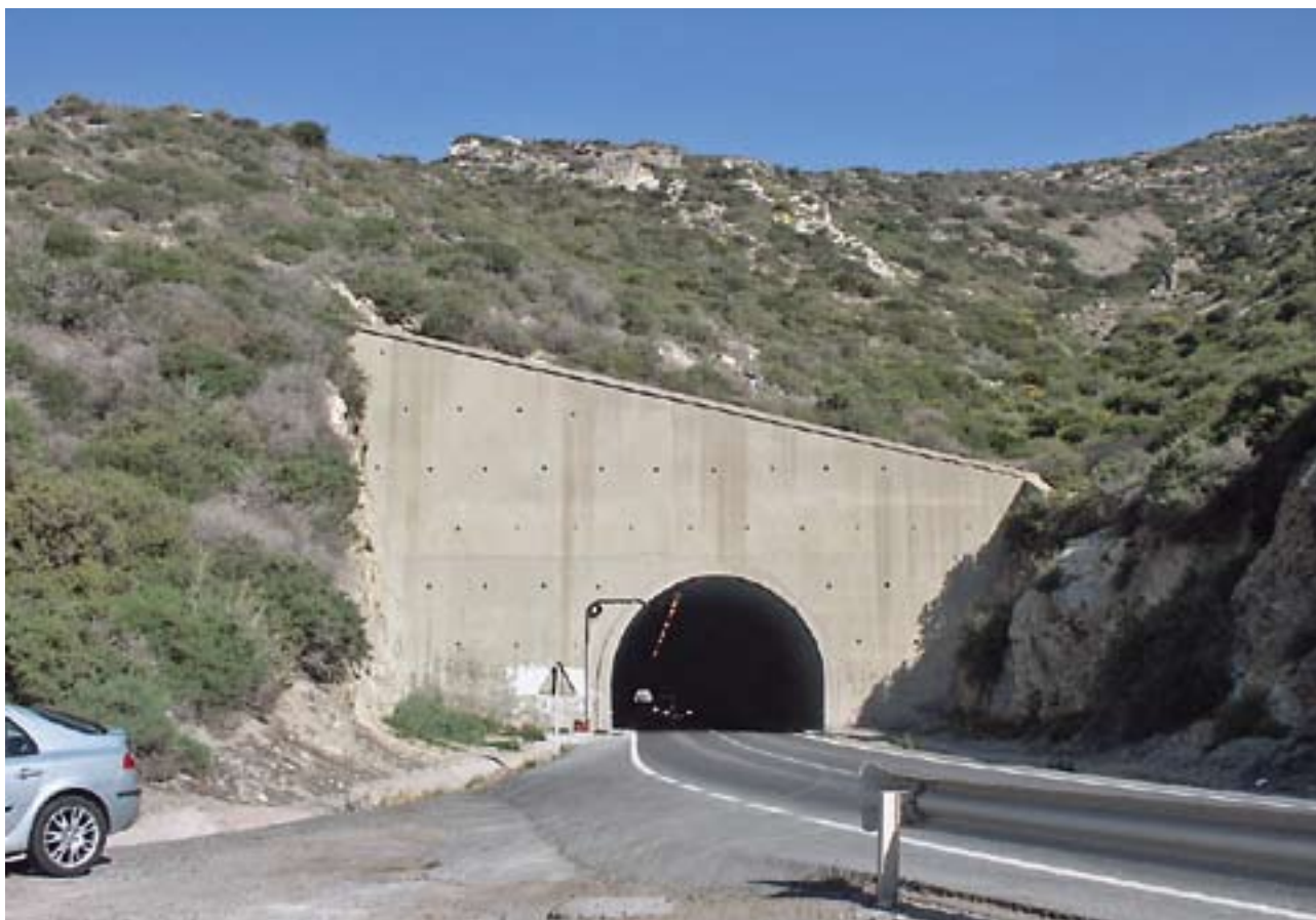
La ejecución de un túnel evita la realización de grandes desmontes.
