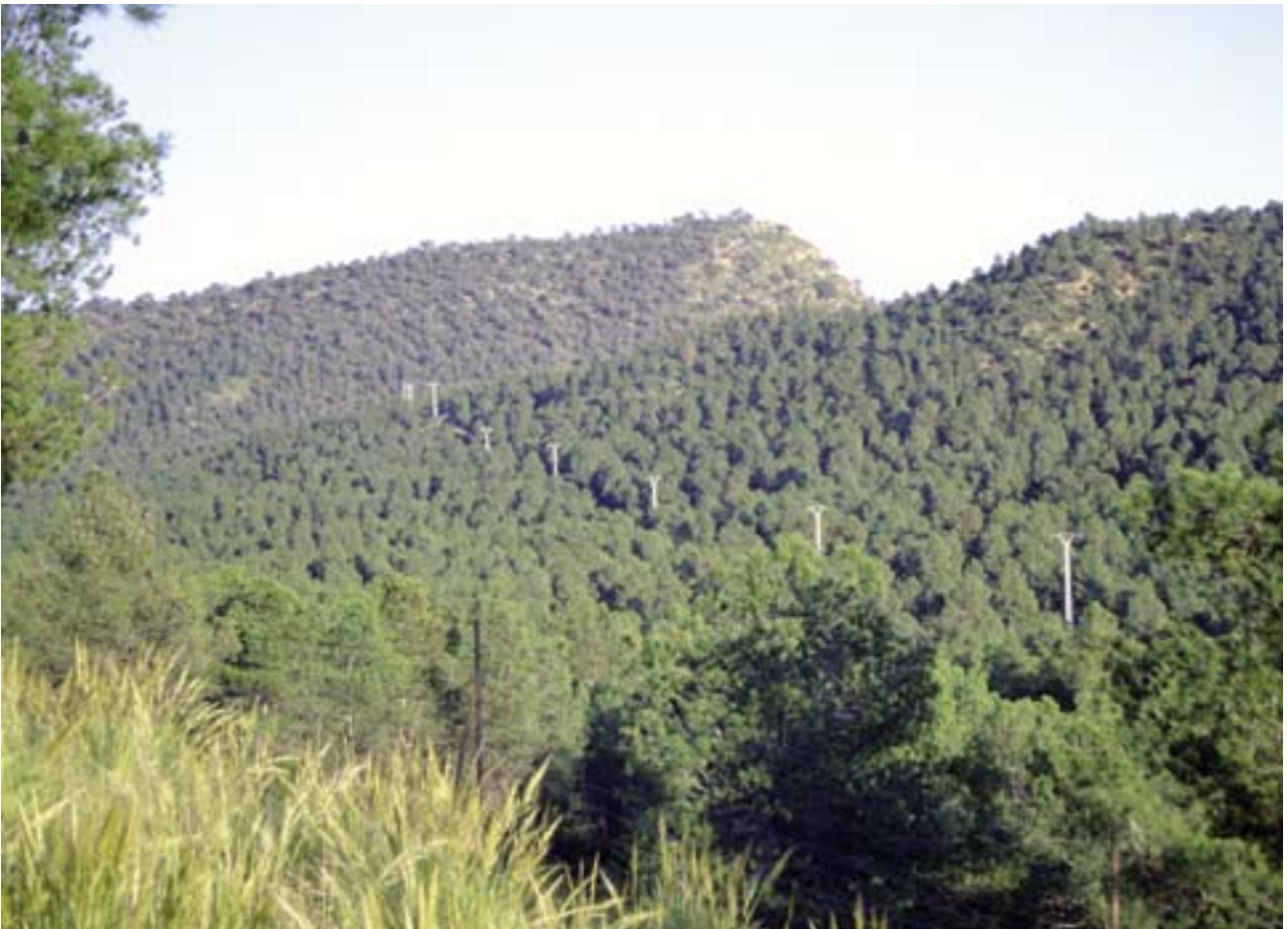
Línea eléctrica atravesando un denso pinar. Un impacto indirecto derivado de estas líneas son los posibles incendios forestales.
