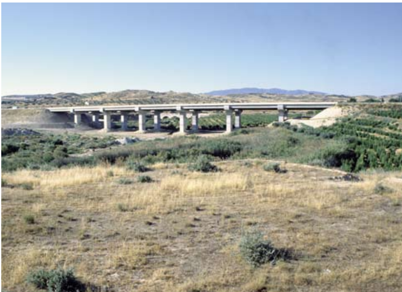
Una de las posibles alternativas de ubicación es el diseño de un trazado elevado por disminuir la fragmentación.
