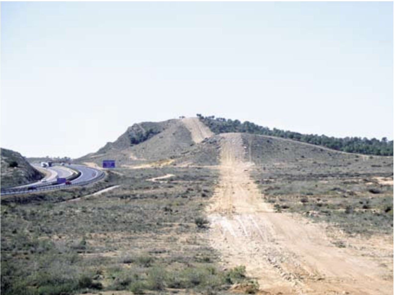
Desbroce del terreno con motivo del trazado de un gasoducto.
