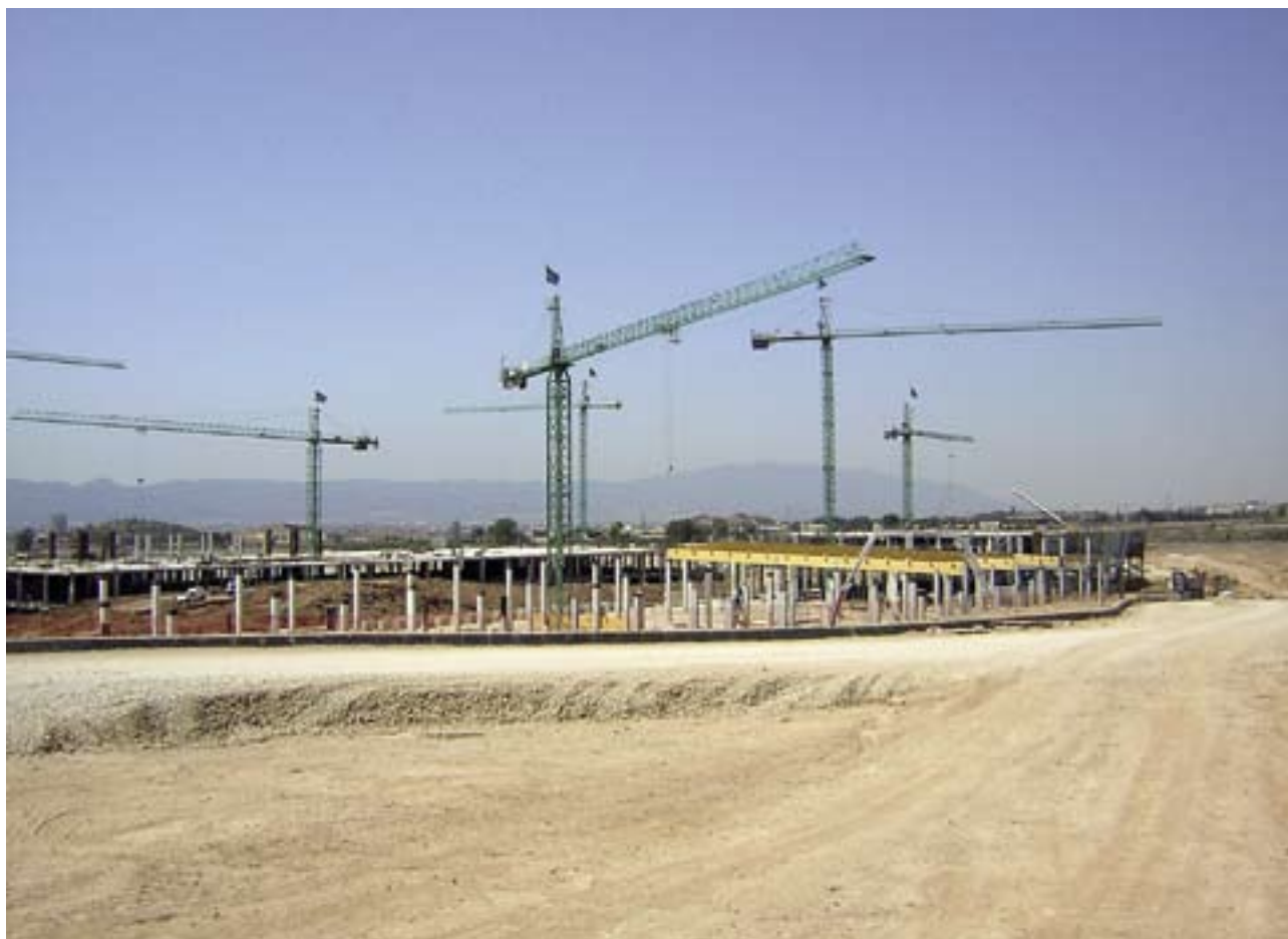
Fase de construcción en un desarrollo urbanístico.
