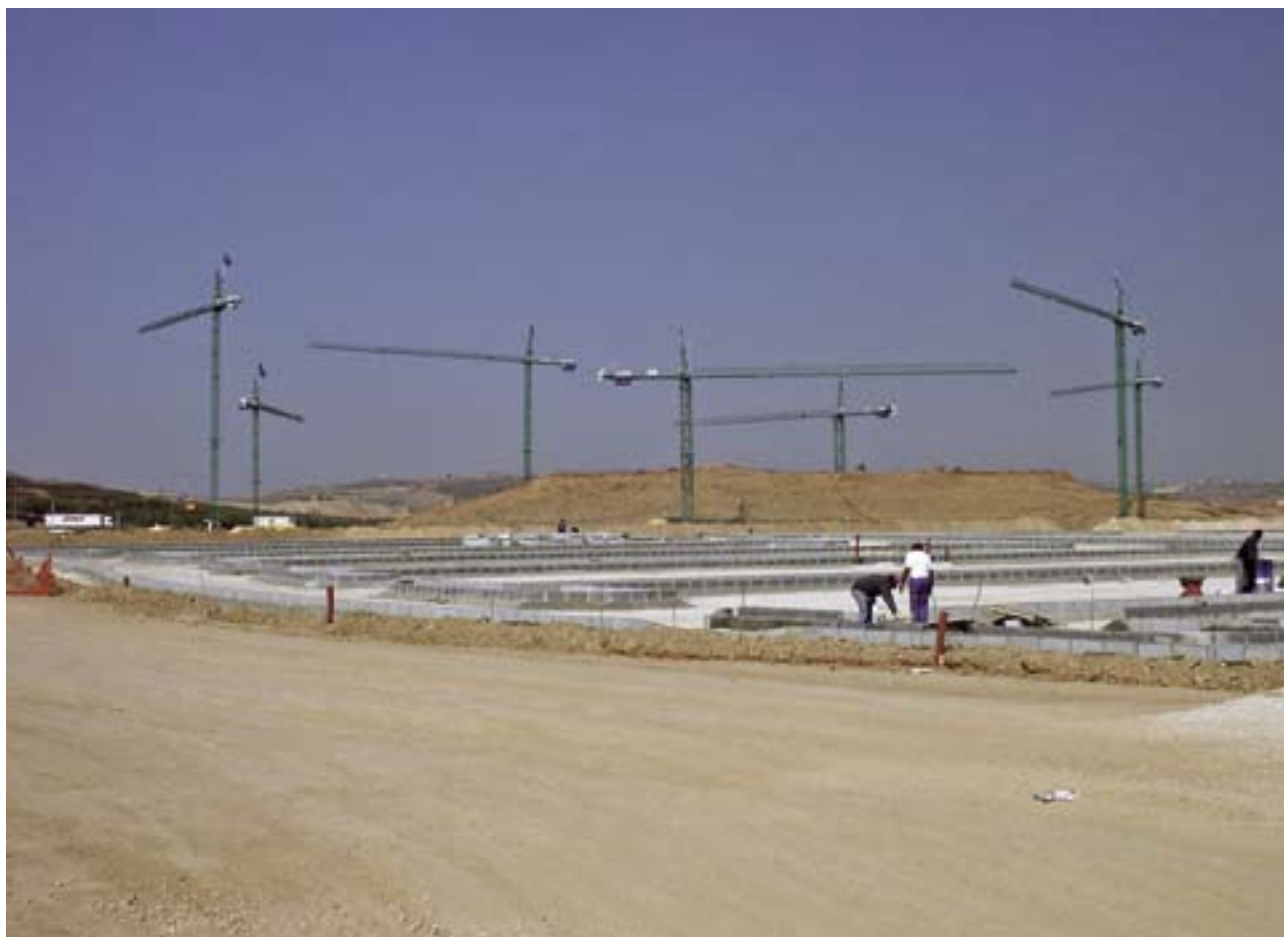
Los proyectos de urbanización consumen recursos, energía y mano de obra.
