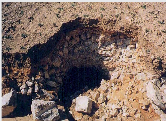
▲ Figura 7.4.2.2. Vista del extremo de la tubificación desde el talud exterior.
