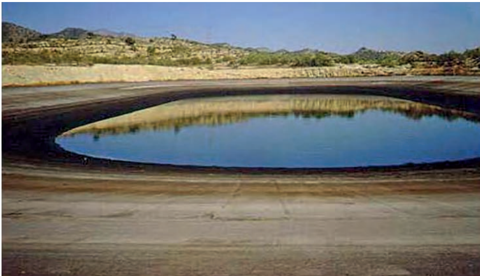
▲Figura 7.4.7.1. Vista general
