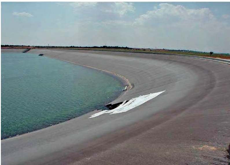
▲ Figura 7.4.8.1. Vista por el talud interior
