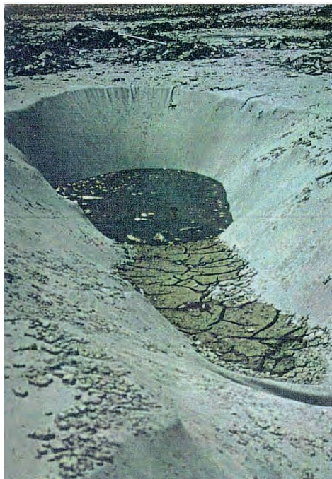
◀ Figura 7.4.9.1. Deformación de la lámina de PVC en el fondo del embalse sin llegar a la rotura.
