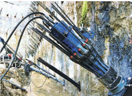
Gato de tesado multifilar.
