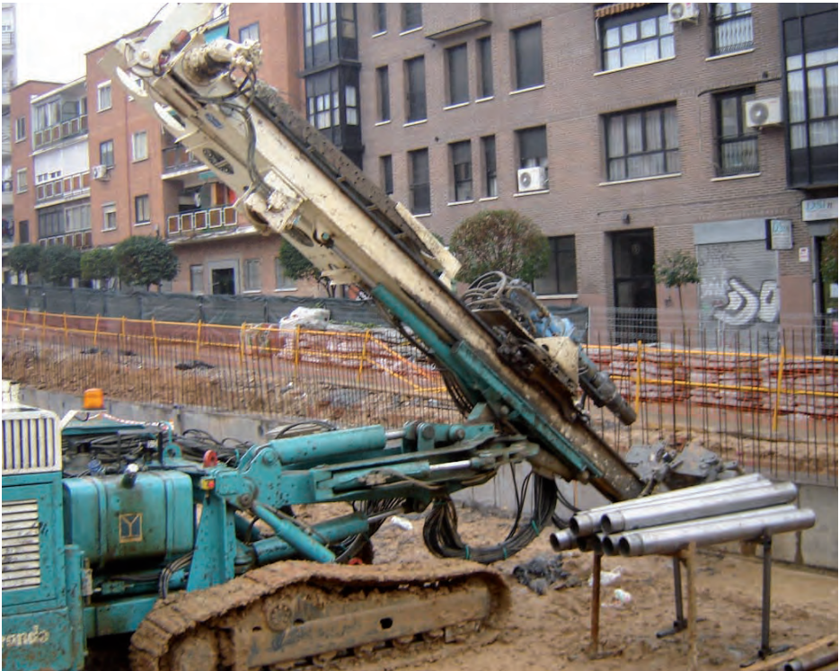
Equipo de perforación y utillaje en borriquetas.
