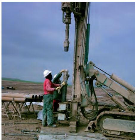
Introducción de la armadura.
