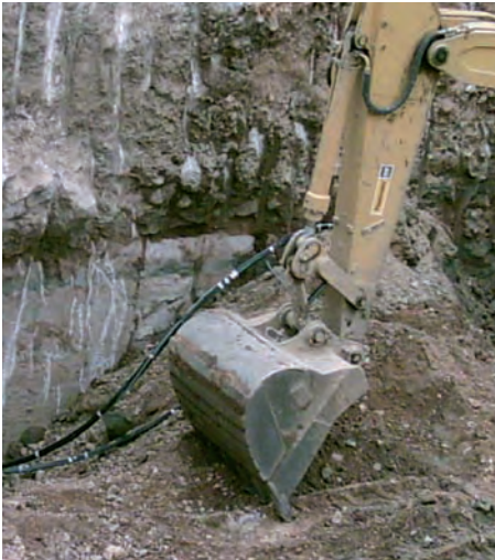
Preparación de la plataforma.
