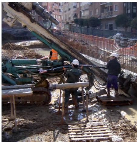
Perforación de anclajes.
