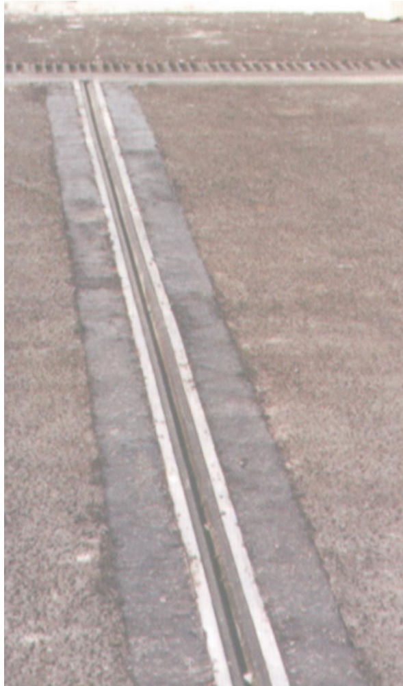
Fig. 1.3. Junta de banda de caucho plegada con bordes metálicos.
