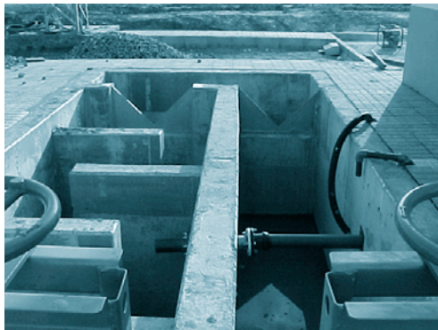
FOTOGRAFÍA 12. Medición de caudal en vertedero triangular.
