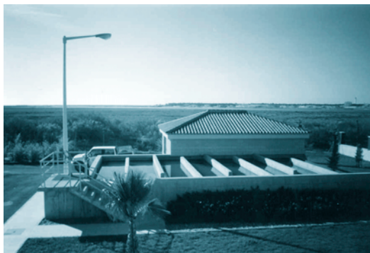
FOTOGRAFÍA 18. Laberinto de cloración.
