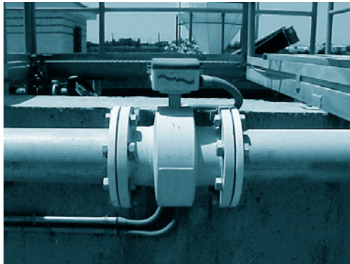
FOTOGRAFÍA 11. Caudalímetro electromagnético.
