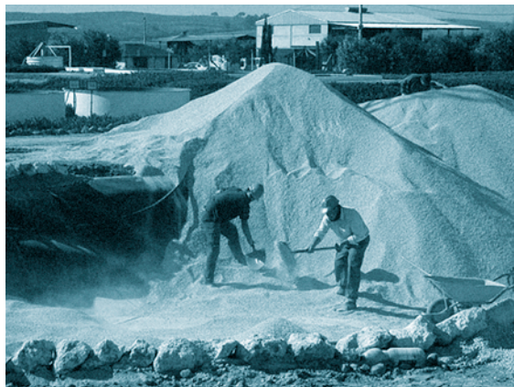
FOTOGRAFÍA 14. Distribución manual de áridos en un humedal artificial (PECC)
