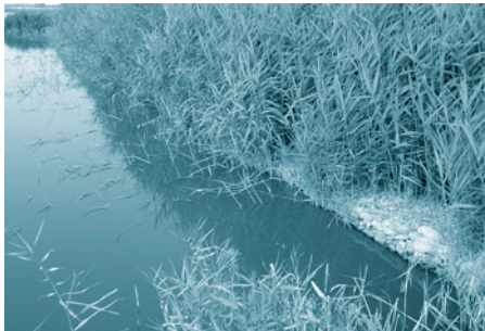
FOTOGRAFÍA 45. Filtro de piedra a la salida de un lagunaje. En este caso el filtro se ha plantado con carrizo.
