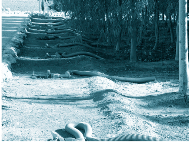
FOTOGRAFÍA 3. Tuberías de reparto a las distintas subparcelas de un filtro verde.
