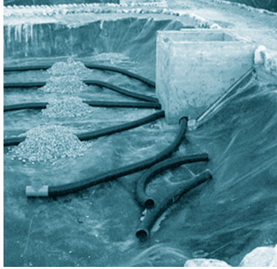
FOTOGRAFÍA 11. Conexión de las tuberías de drenaje con la arqueta de salida.
