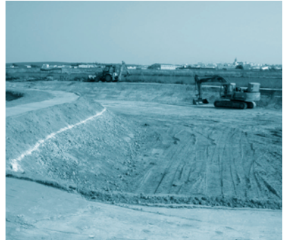
FOTOGRAFÍA 32. Excavación del vaso de una laguna facultativa.
