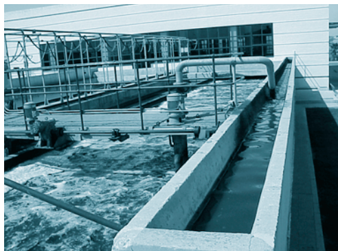
FOTOGRAFÍA 9. Desarenador-desengasador aireado.
