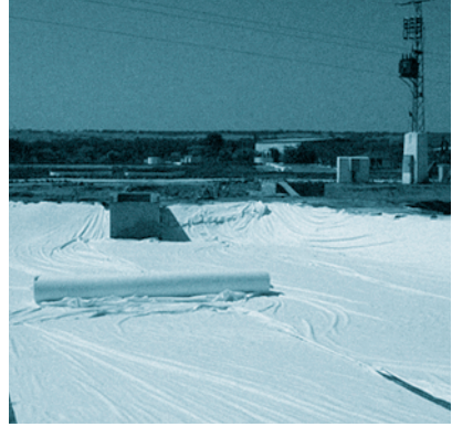
FOTOGRAFÍA 5. Colocación de la lámina de geotextil.
