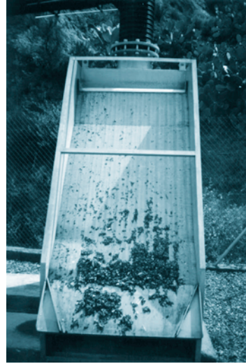
FOTOGRAFÍA 5. Tamiz estático autolimpiante.
