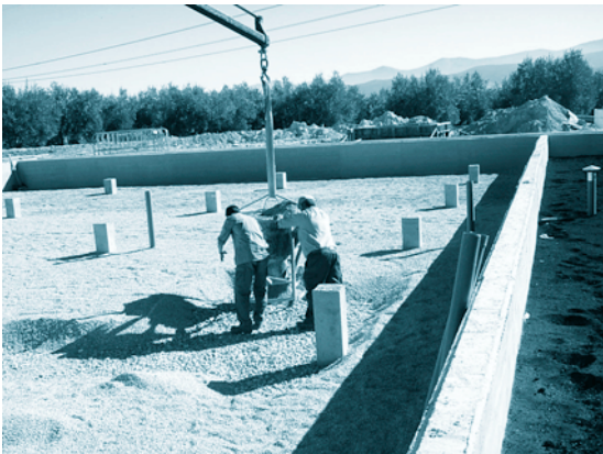
FOTOGRAFÍA 8. Colocación de la última capa de áridos, sobre la que se dispone la capa de turba.
