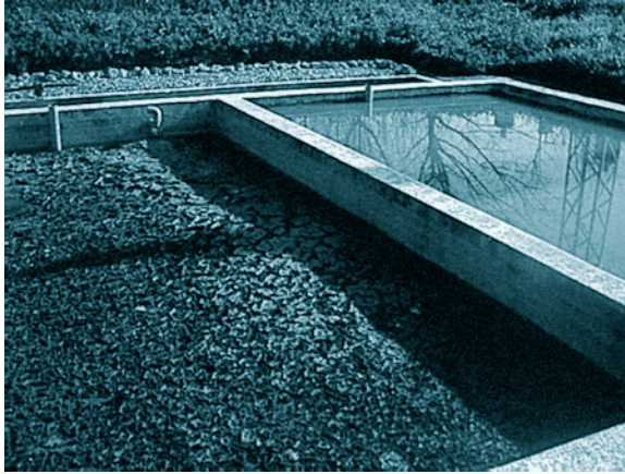
FOTOGRAFÍA 2. Filtro de turba en operación (derecha) y en fase de secado (izquierda)
