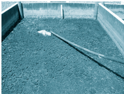
FOTOGRAFÍA 16. Filtro de turba empleado como era de secado de lodos.
