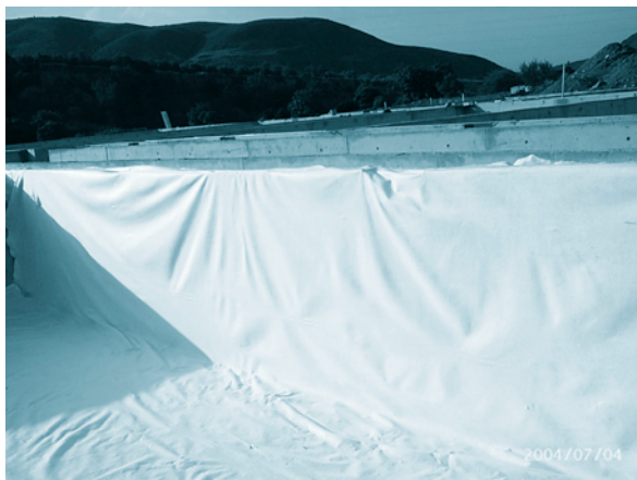
FOTOGRAFÍA 4. Colocación de una lámina de geotextil como paso previo a la impermeabilización del vaso de los filtros de turba con lámina plástica.
