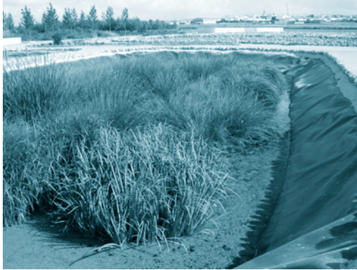
FOTOGRAFÍA 18. Aspecto de un humedal de flujo libre al año de su plantación (PECC)
