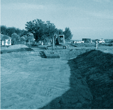
FOTOGRAFÍA 4. Excavación del vaso de los humedales.
