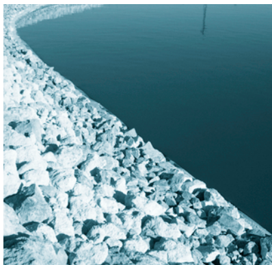
FOTOGRAFIA 38. Llenado de una laguna de maduración.
