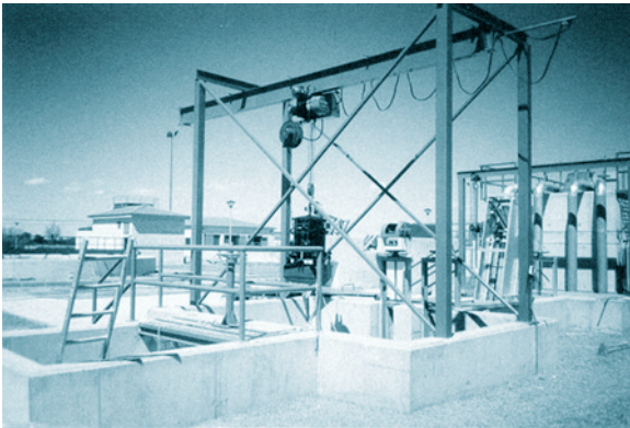
FOTOGRAFÍA 2. Pozo de gruesos y cuchara bivalva.
