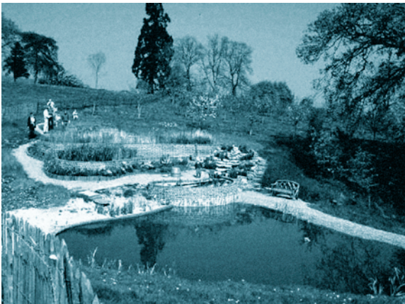
FOTOGRAFÍA 1. Lagunaje en cola de una instalación de humedales artificiales. (Oaklands Park, Reino Unido).
