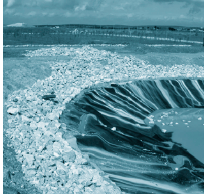
FOTOGRAFÍA 36. Encachado de los taludes.
