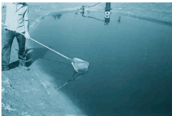
FOTOGRAFÍA 40. Retirada de flotantes en una laguna de maduración.
