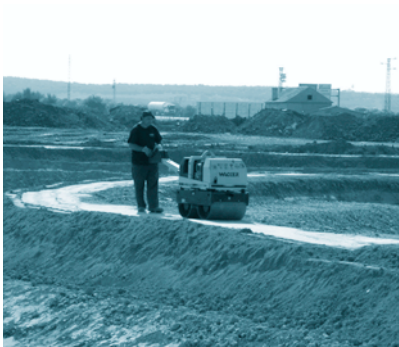
FOTOGRAFÍA 33. Compactación de la coronación de las lagunas.
