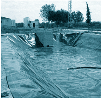
FOTOGRAFÍA 6. Humedal tras finalizar la etapa de impermeabilización.
