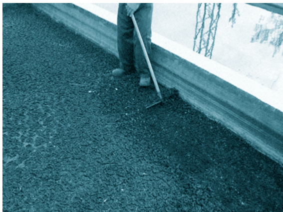
FOTOGRAFÍA 13. Retirada de la costra mediante rastrillado.
