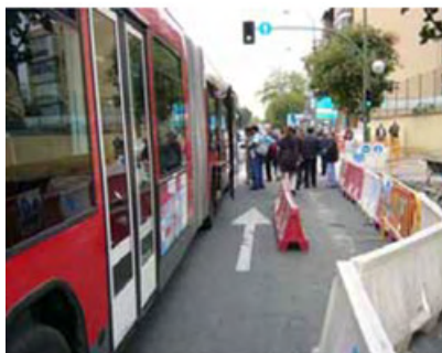
Ilustración 15 Balizamiento parada de autobús. Fuente: Manual de buenas prácticas preventivas en obras de infraestructuras urbanas del Ayuntamiento de Madrid
