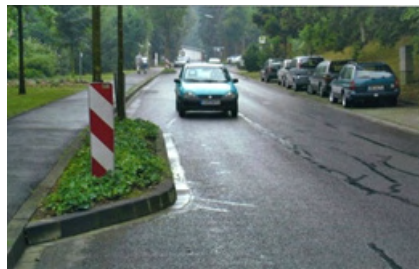
Ilustración 25 Estrechamiento de la calzada en Alemania. Fuente: Fuente: Calmado de Tráfico, Ministerio de Fomento.
