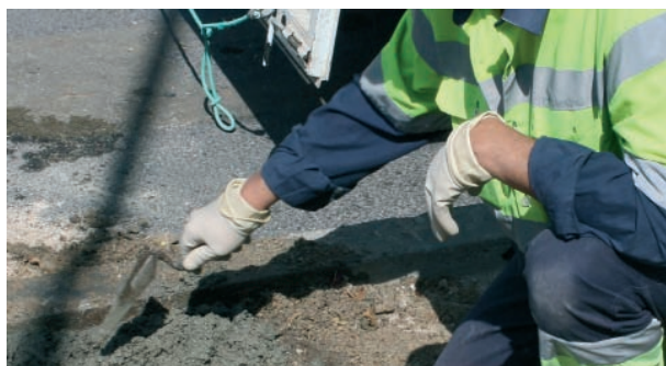
Figura 73. Manipulación de cemento.
