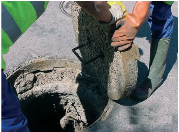
Figura 79. Trabajo en colectores.
