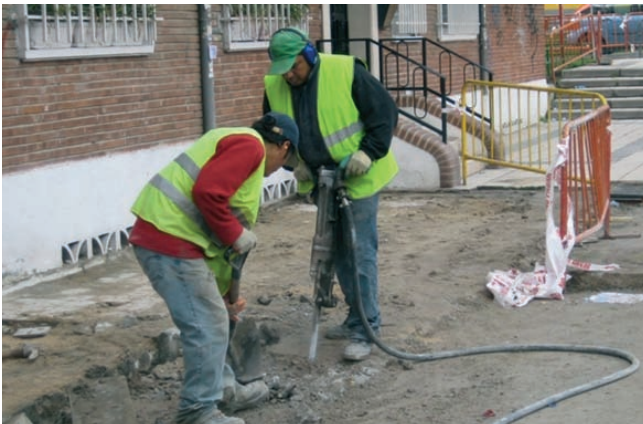
Figura 20. Trabajando con martillo rompedor. El operador lleva protección auditiva, no así el segundo trabajador
