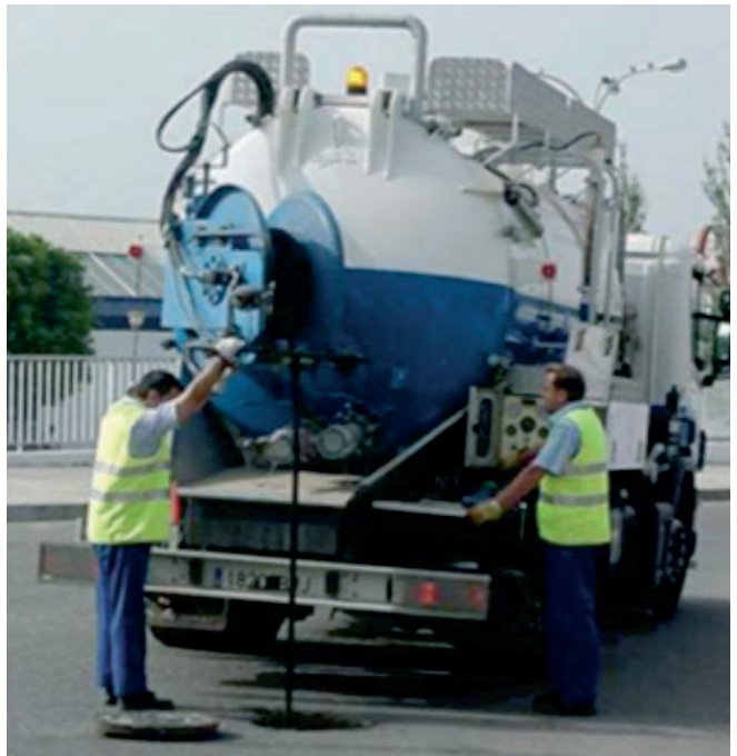
Figura 63. Trabajos en el centro de la calle con circulación de vehículos.
