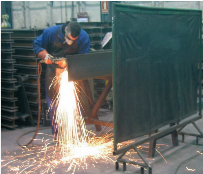
Figura 53. Producción de gases de soldadura en la preparación de estructuras metálicas.
