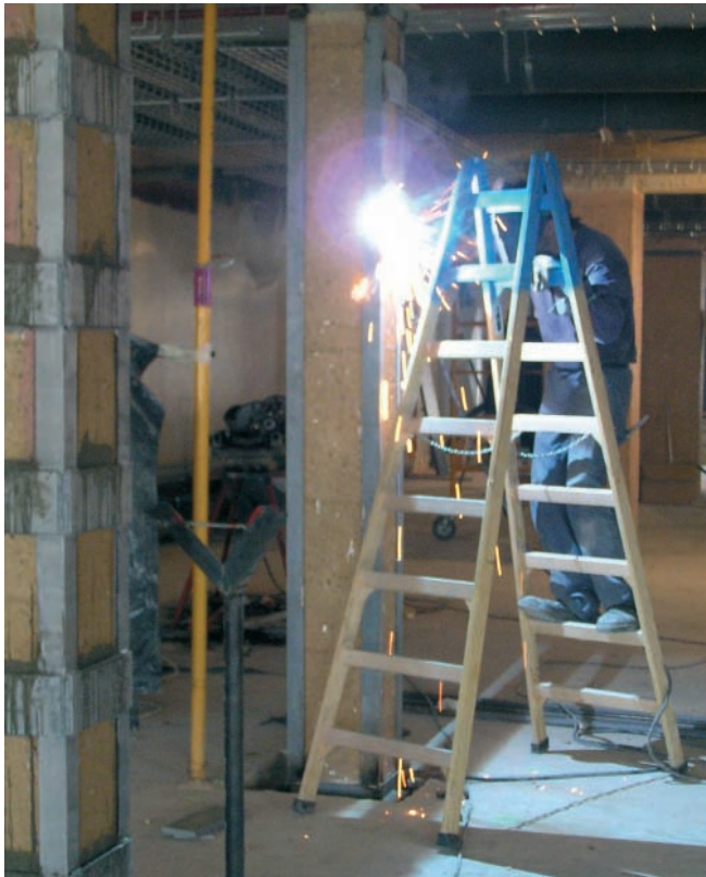
Figura 38. Soldadura eléctrica.
