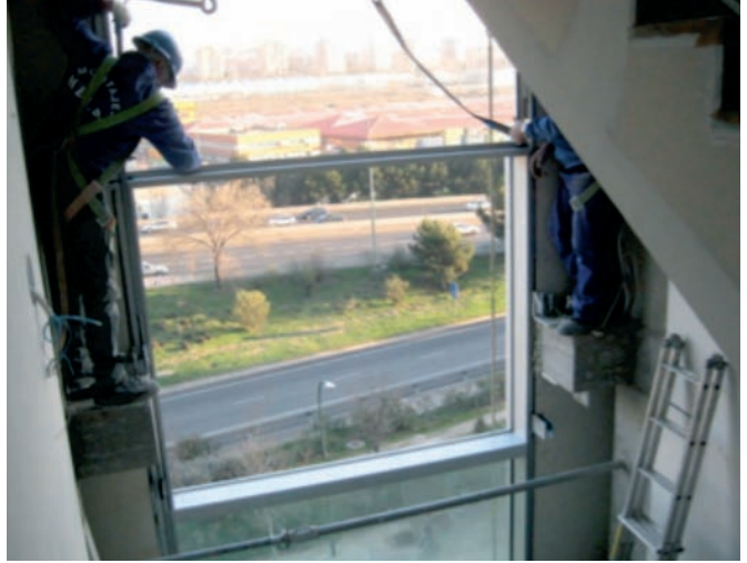
Figura 84. Instalación de ventanas.
