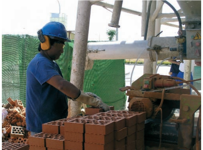
Figura 21. Trabajo con sierra de corte cerámico.
