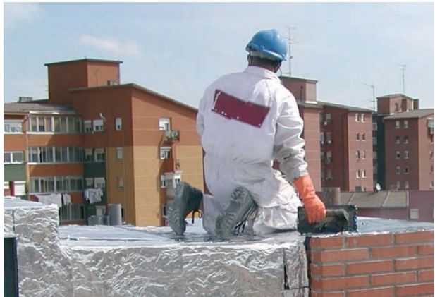
Figura 76. Impermeabilización con betún en caliente.
