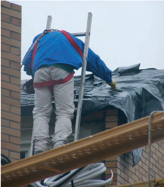
Figura 83. Trabajos en cubierta.
