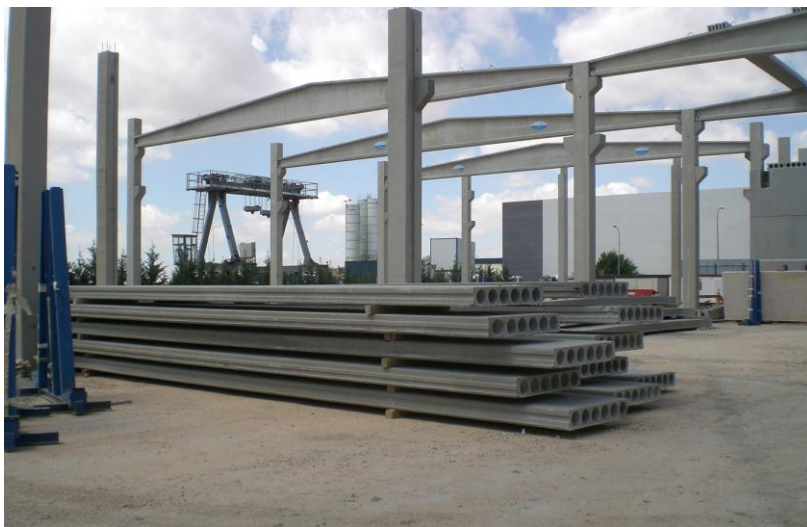
Fotografía – Acopio en obra de placas alveolares antes de su montaje
