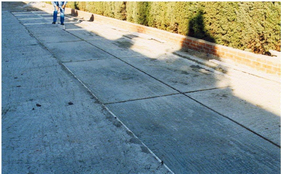
**Figura 4.25** Colocación de las planchas de porexpán para delimitación de módulos.
