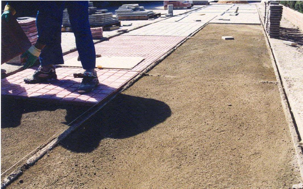
**Figura 4.33 Fase de ejecución del enlosado.**
