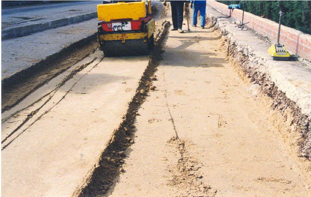
**Figura 4.10** Proceso de compactación en zona con 4 cm de espesor de firme.
