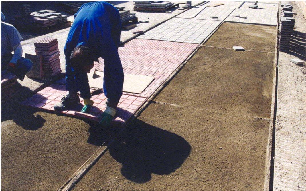
**Figura 4.34** Fase de ejecución del enlosado.
