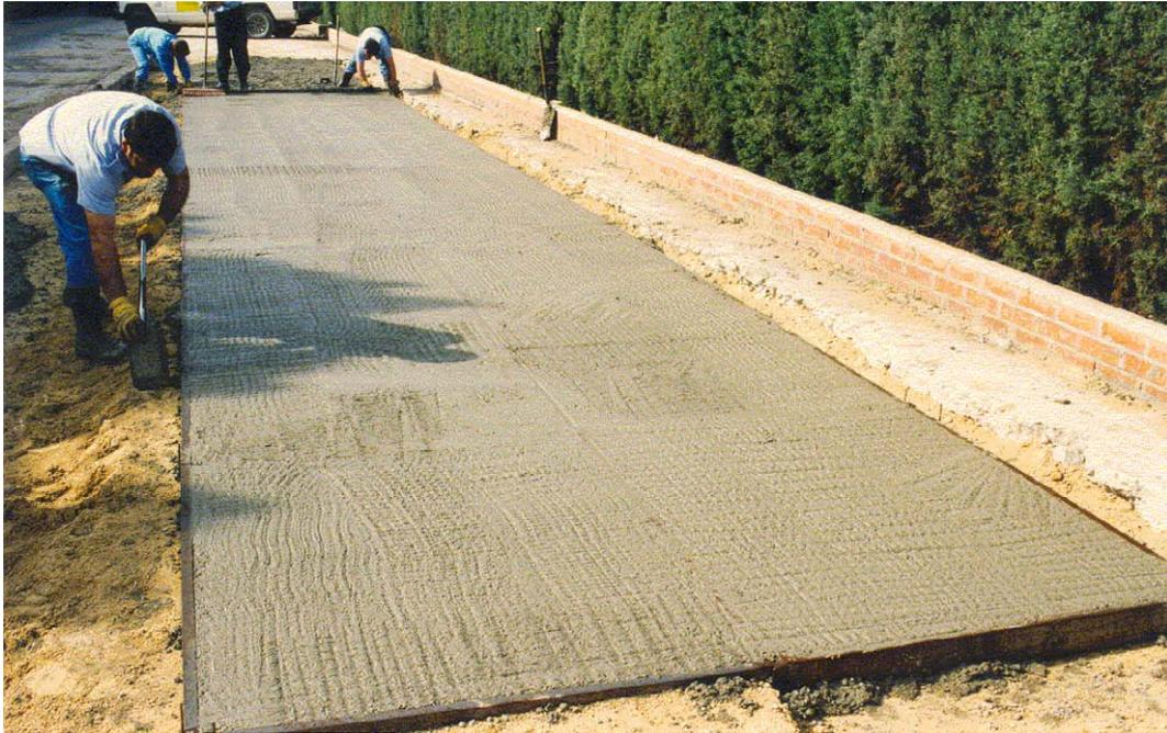
**Figura 4.23 Detalle de rugosidad superficial del pavimento.**
