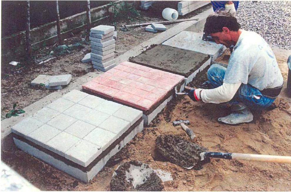
**Figura 3.5 Solado de los módulos de prueba.**
