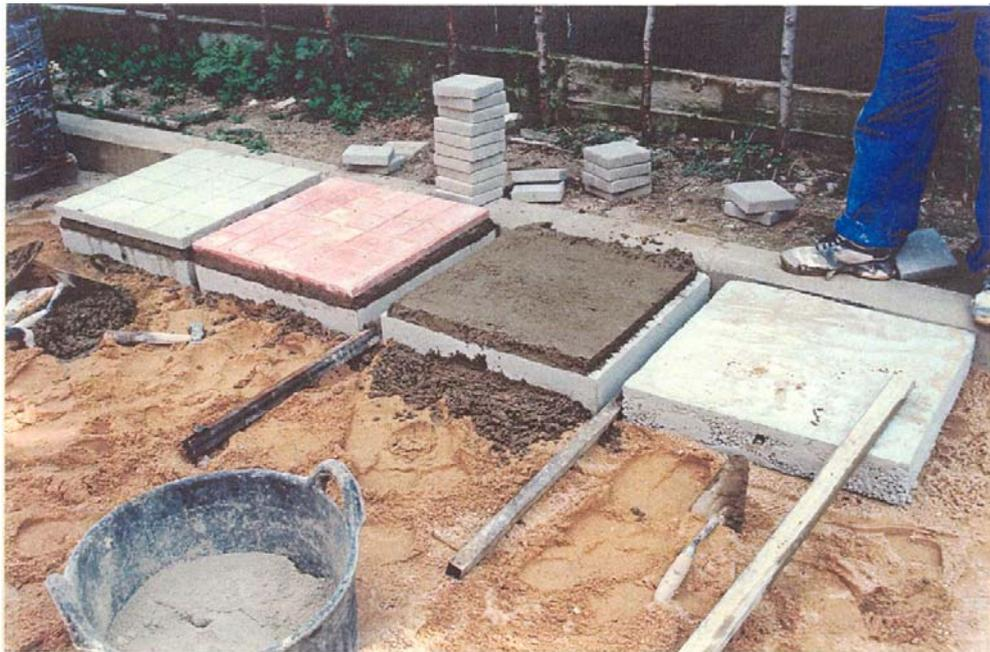
**Figura 3.6 Solado de los módulos de prueba.**
