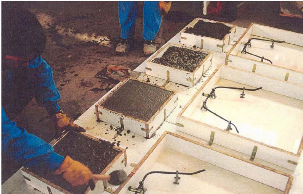
**Figura 3.3** Vertido y compactación del hormigón en los módulos.
