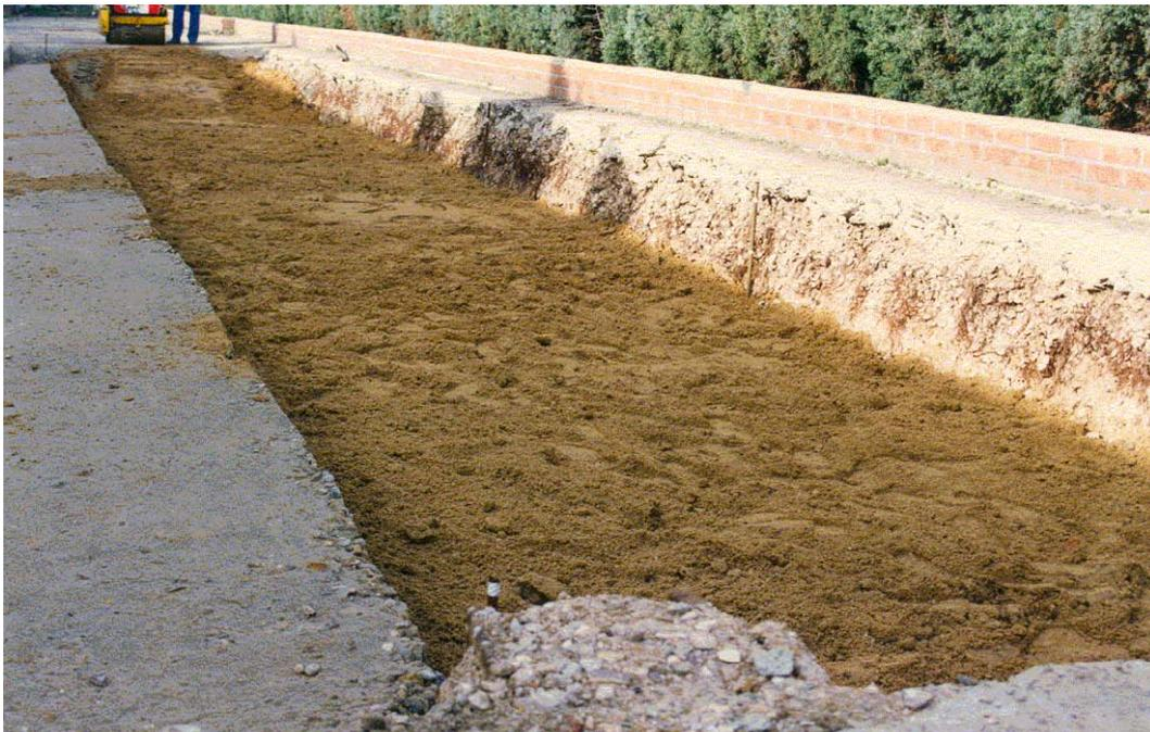
**Figura 4.5** Aspecto del extendido del suelo en la primera capa correspondiente a la zona "compactación correcta".
