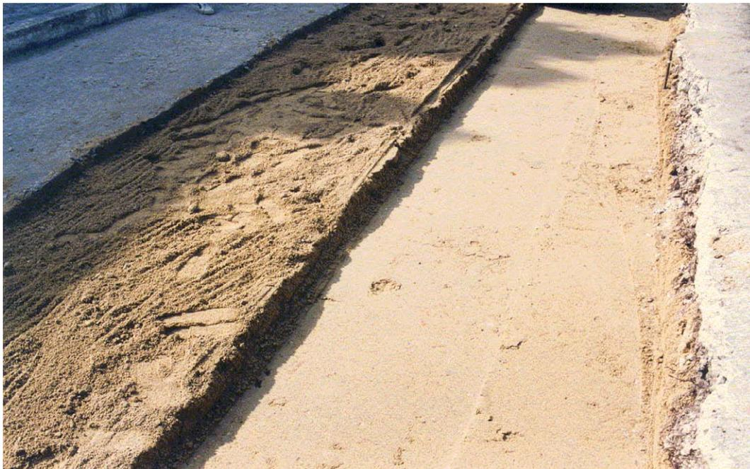
**Figura 4.9** Capa 1ª compactada en zona con espesor del firme de 10 cm y zona no compactada con espesor del firme de 4 cm.
