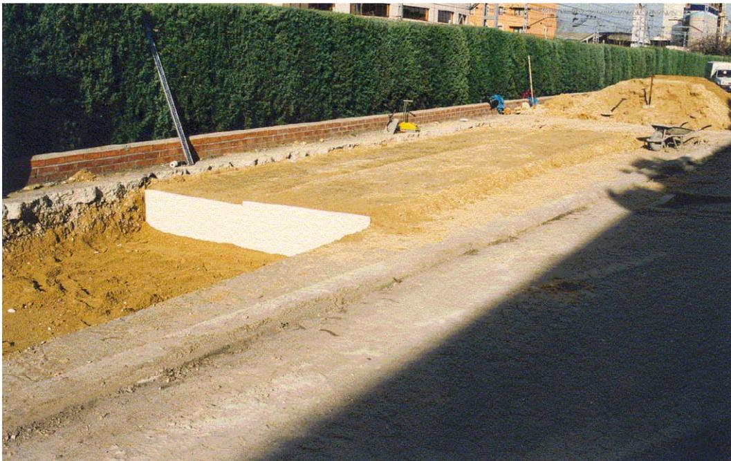
**Figura 4.13** Aspecto general de la zona de compactación correcta. Materialización de la separación física con la zona de compactación deficiente
