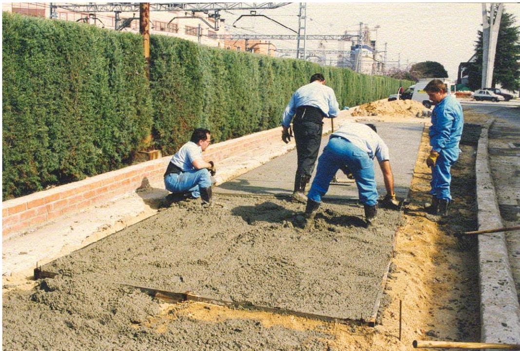
**Figura 4.21** Enrasado posterior del tramo de ensayo.
