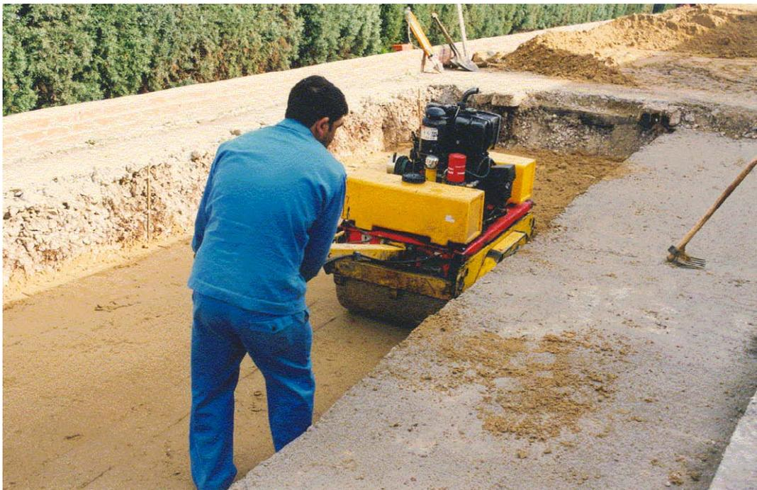
**Figura 4.7** Compactado mediante rodillo metálico (Primera capa: compactación correcta).
