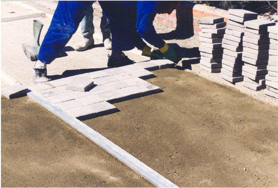
**Figura 4.30** Colocación de la baldosa hidráulica "MONOCAPA 15x15".
