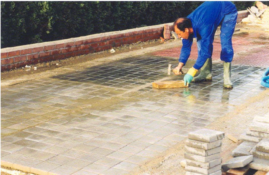
**Figura 4.35** Nivelación de los módulos una vez finalizada su colocación.
