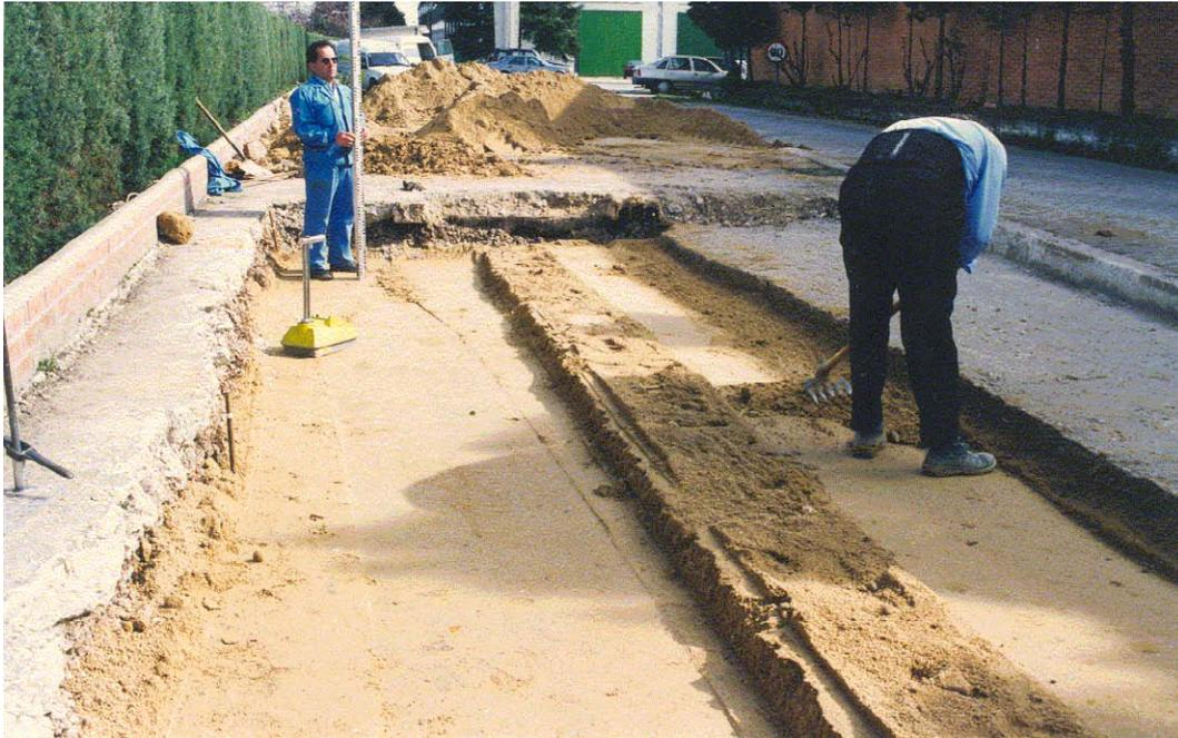
**Figura 4.8** Toma de datos de la nivelación de la capa compactada y regulación de la zona defectuosa.
