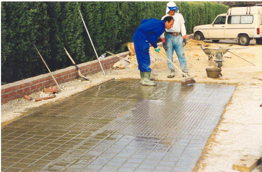
**Figura 4.37** Aplicación de la lechada de unión.
