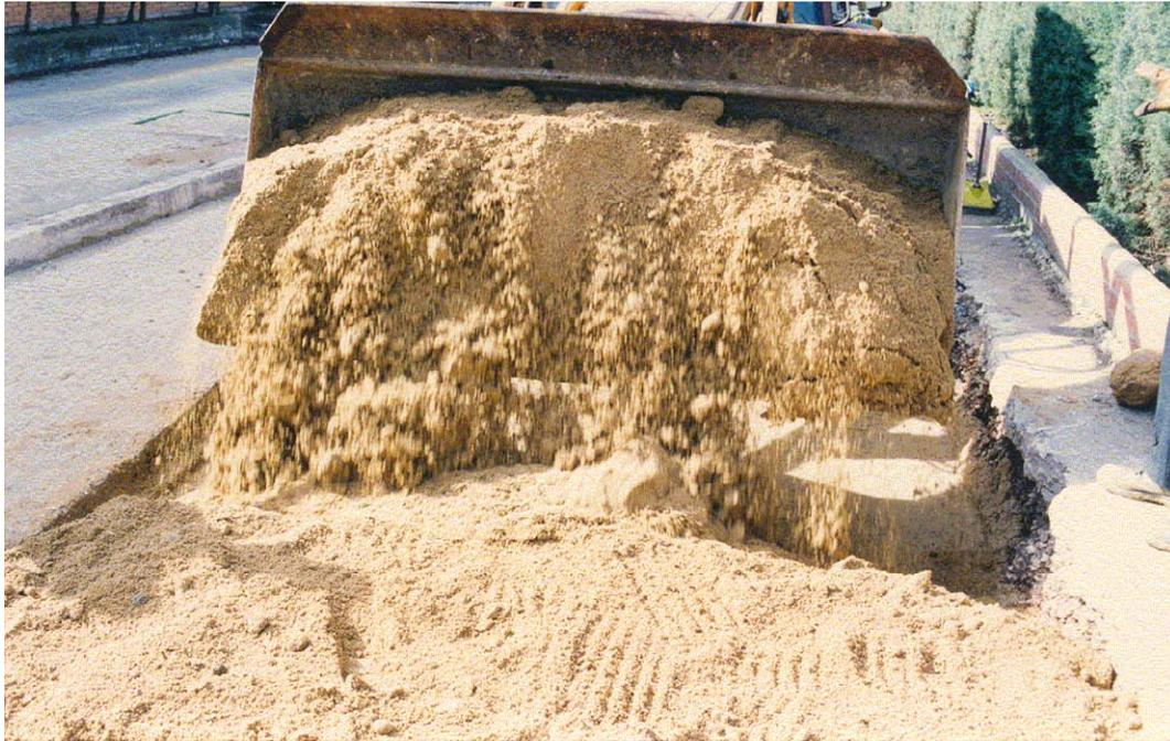
**Figura 4.4** Vertido del suelo de relleno a la excavación.
