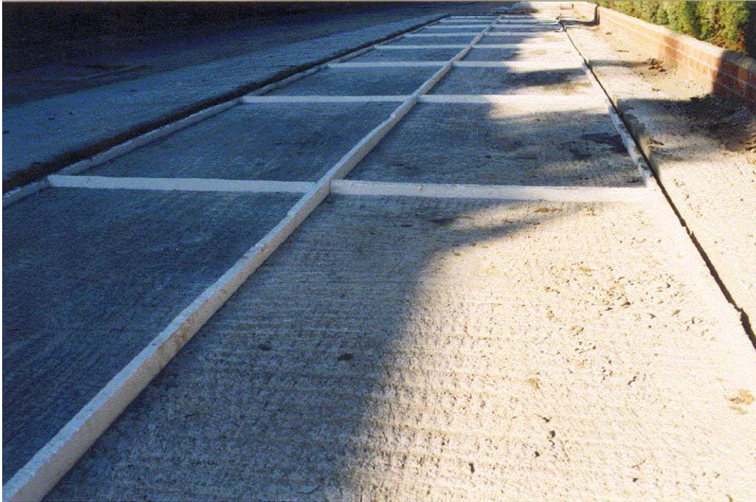
**Figura 4.26 Disposición de juntas de porexpán entre módulos.**
