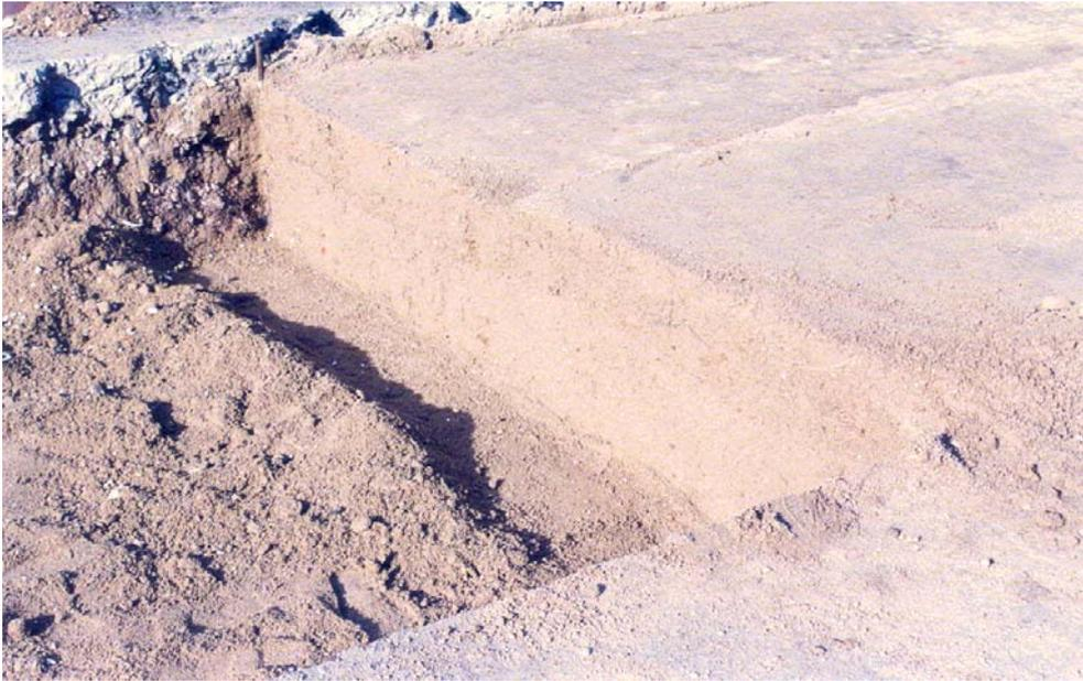
**Figura 4.12** Detalle del corte vertical realizado para delimitación de las dos zonas de compactación definidas.
