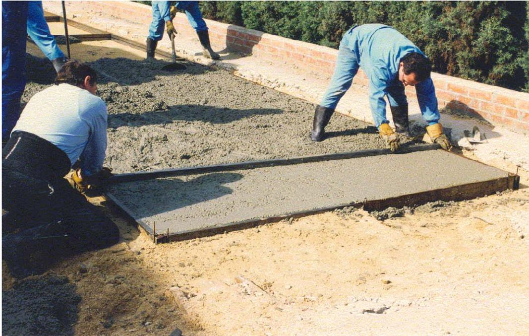
**Figura 4.20** Extendido del hormigón y enrasado del mismo.
