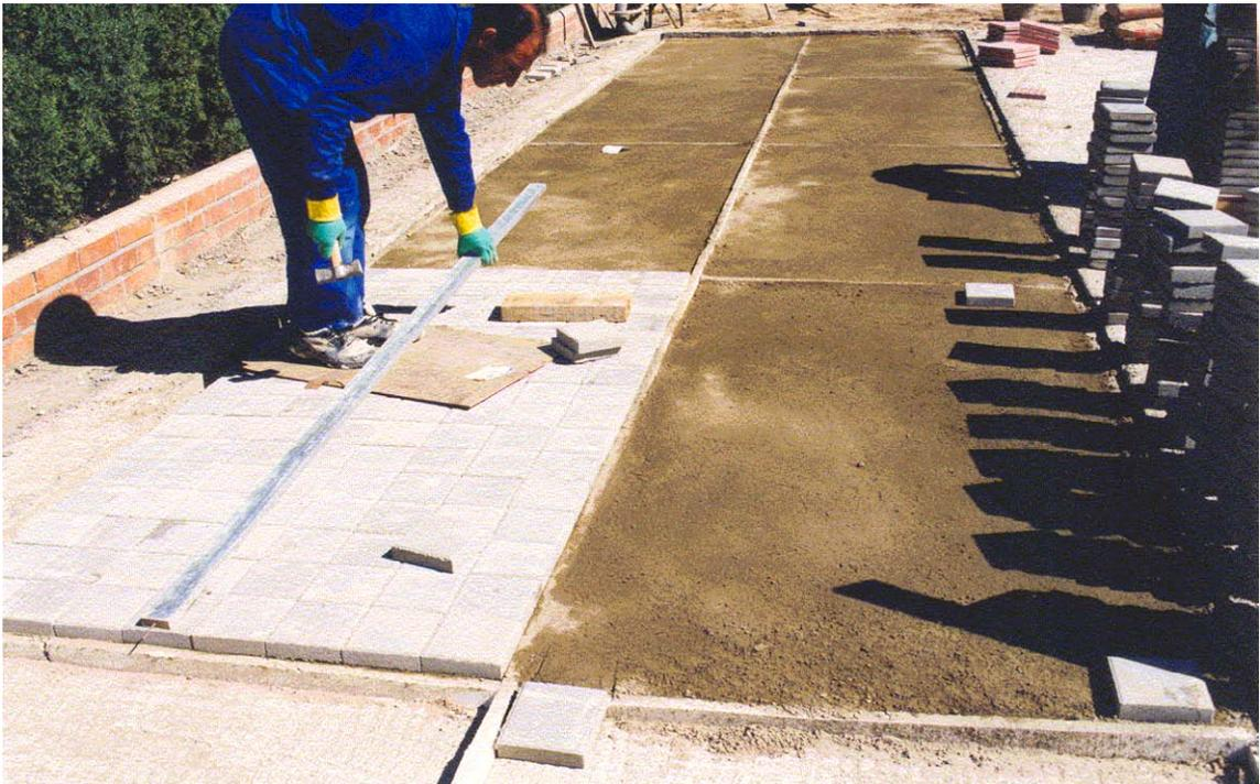
**Figura 4.31:** Colocación de la baldosa hidráulica "MONOCAPA 15x15".
