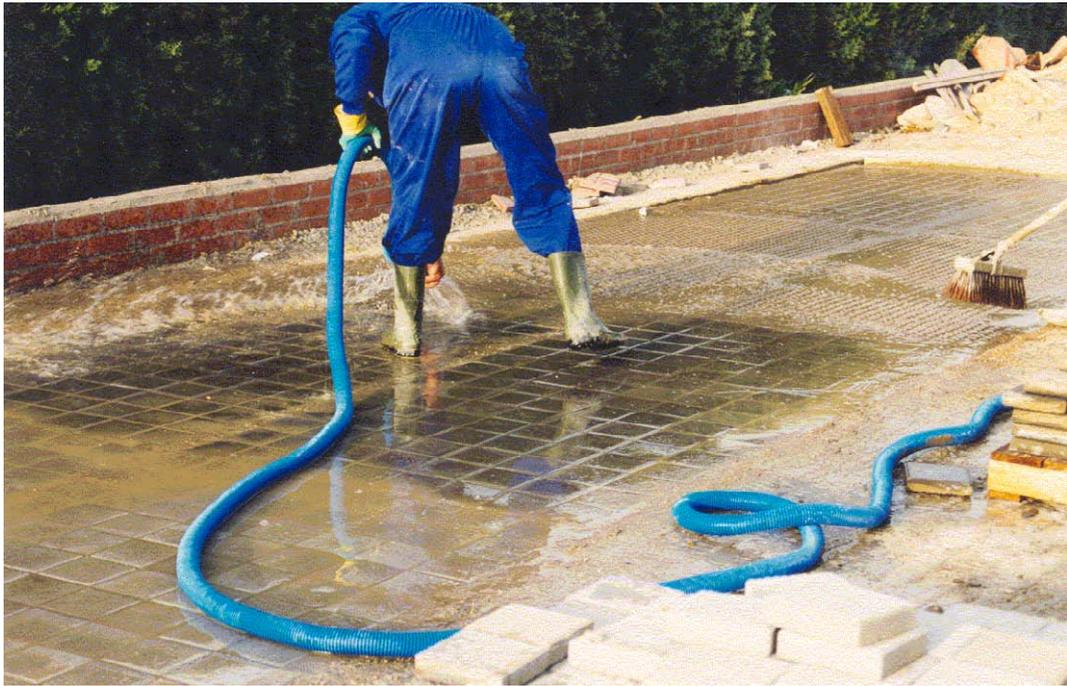
**Figura 4.38 Limpieza de la superficie del pavimento finalizada la colocación.**
