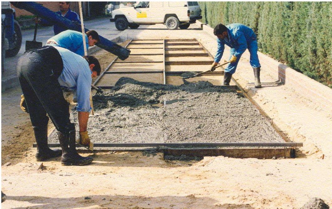
**Figura 4.19 Extendido y compactación del hormigón.**
