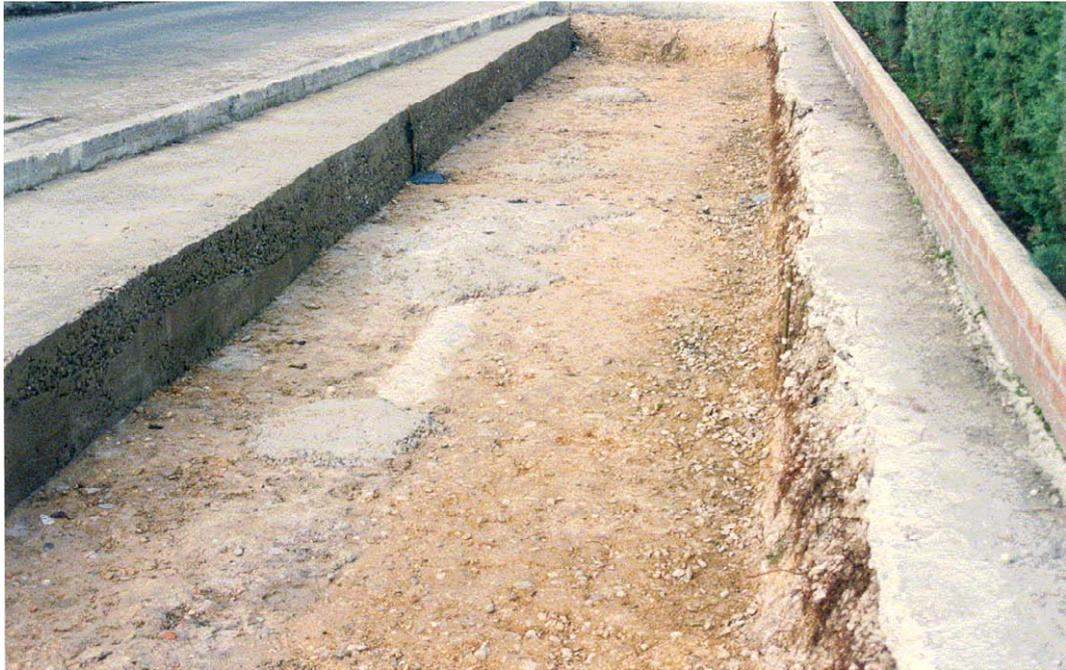
**Figura 4.3** Cajeadado de la excavación delimitado por un relleno de hormigón.
