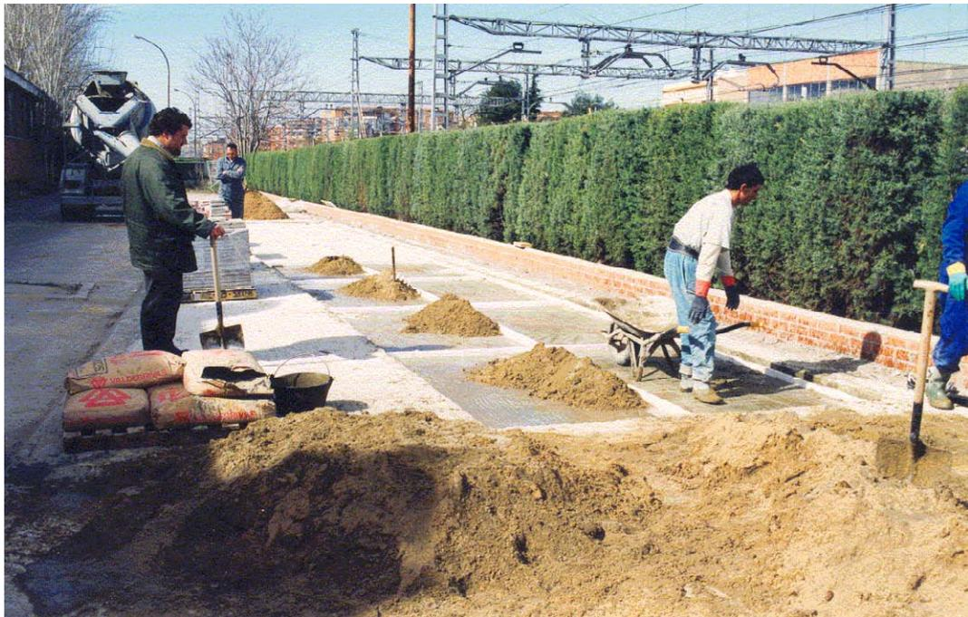
**Figura 4.27** Colocación del enlosado. Aportación del material de agarre.
