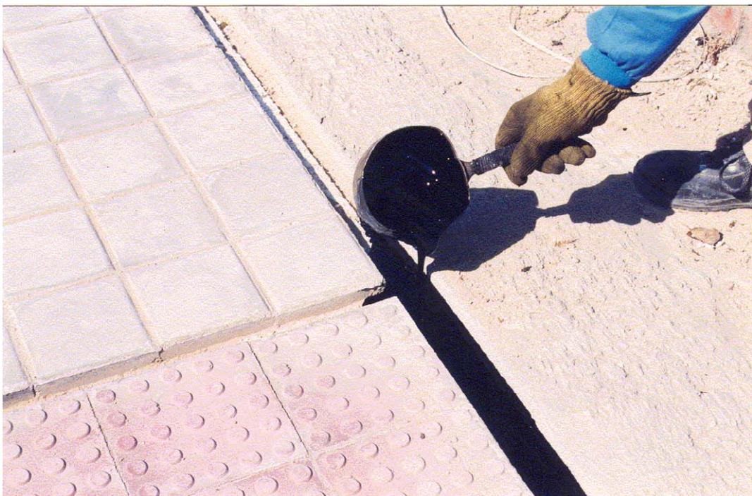
**Figura 4.39 Sellado de las juntas mediante betún asfáltico.**
