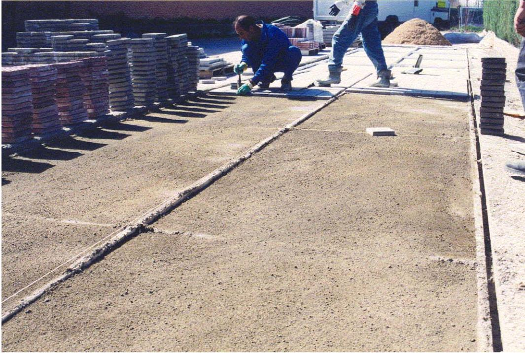
**Figura 4.32 Fase de ejecución del enlosado.**
