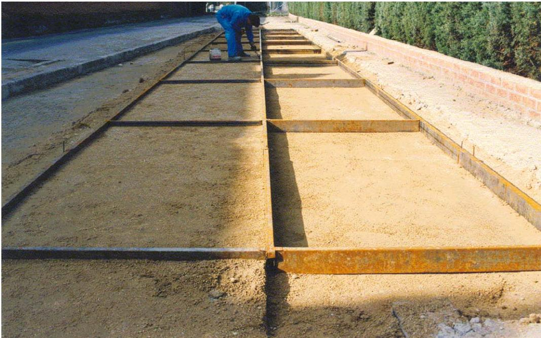
**Figura 4.17** Aplicación del desencofrante en las paredes del encofrado.
