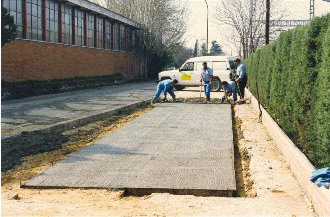
**Figura 4.22 Enrasado posterior del tramo de ensayo.**
