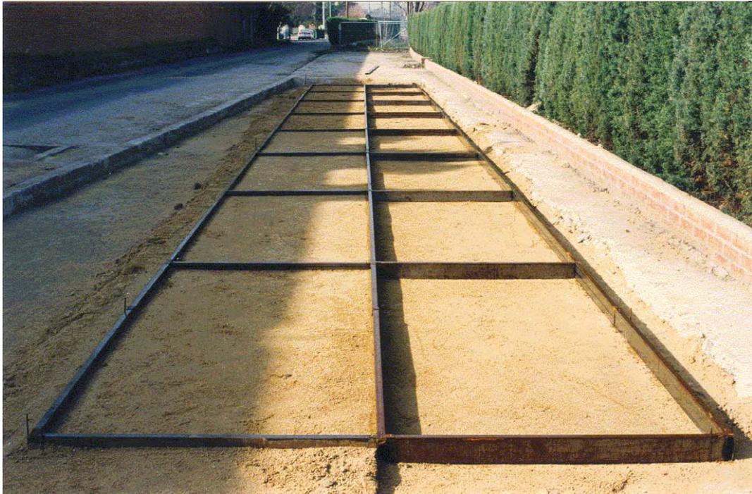
**Figura 4.16** Aspecto general del entramado metálico colocado como encofrado de los diferentes módulos.
