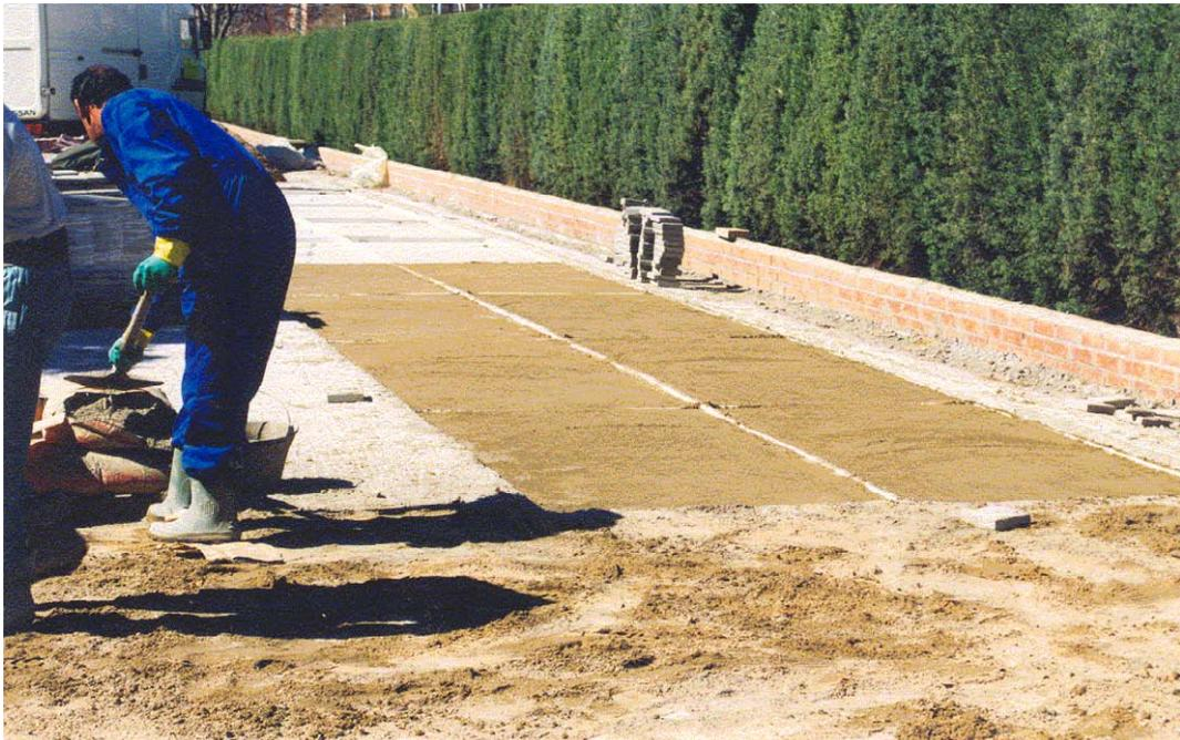
**Figura 4.29** Aspecto del extendido final en la zona de compactación correcta.
