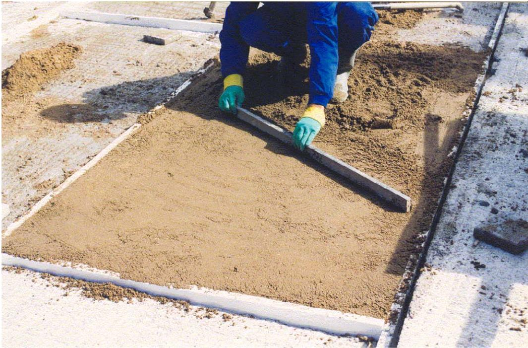
**Figura 4.28** Extendido y enrasado del material de agarre.
