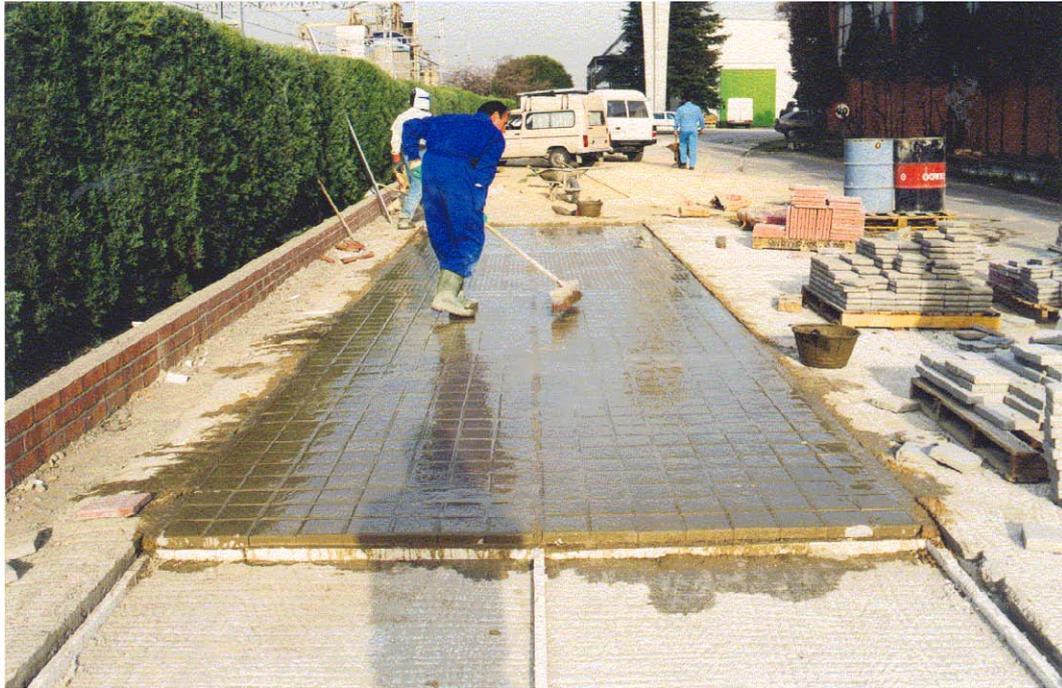
**Figura 4.36** Aplicación de la lechada de unión.
