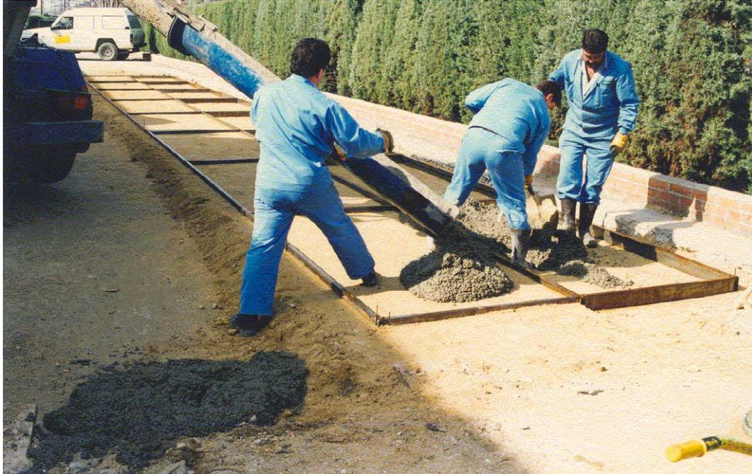
**Figura 4.18 Vertido del hormigón.**
