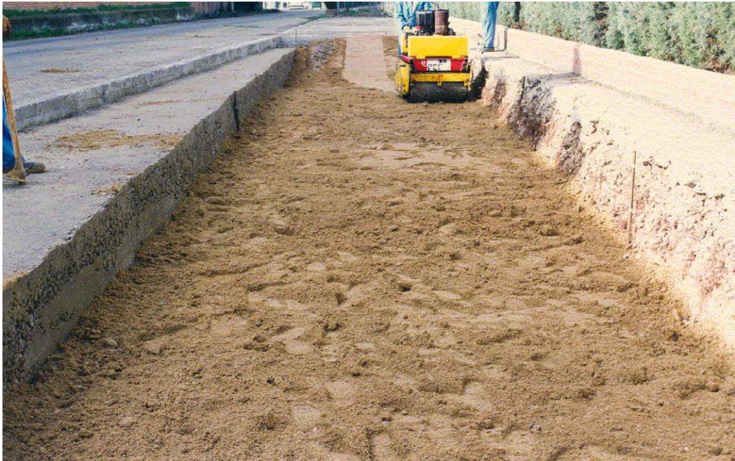
**Figura 4.6** Inicio de la compactación de la primera capa mediante rodillo cilíndrico liso.
