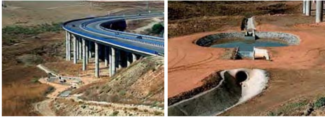
Figura 16. Izquierda: ejemplo de una balsa de decantación de sedimentos y de contención de vertidos accidentales, conectada al sistema de drenaje de la autopista Radial 4 (Madrid). En la imagen pueden observarse, además de la infraestructura lineal, la bajante desde el terraplén, la cuneta que conduce la escorrentía y los sedimentos a la balsa; el canal de entrada; la balsa; y el vertedero de la balsa a la red fluvial del entorno (arroyo Salinas). Derecha: detalle de la misma balsa, en el que se aprecian mejor algunos de los elementos que la componen: el canal de entrada, la reja de desbaste, la balsa, el canal de vertido y el arroyo Salinas (al fondo) (Fotos: Javier Martínez de Castilla Colomer, Ferroviario-Agromán SA).
