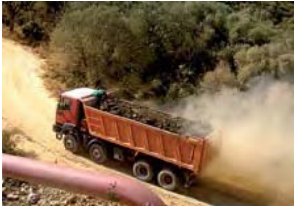
Figura 6. Emisión de polvo sobre la vegetación. La fase de construcción genera numerosos impactos sobre la flora y la fauna incluyendo el polvo, la contaminación atmosférica y el ruido (Foto: Nerea Aizpurua y Adoración Gómez).
