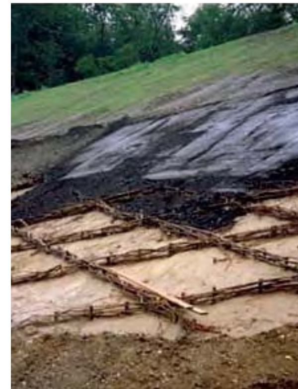
Figura 9. Empalizada trenzada en diagonal en la consolidación de taludes.
