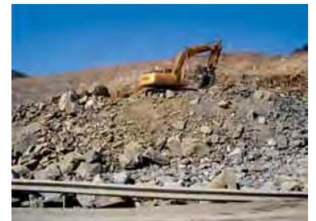
Figura 5. Movimiento de tierras y generación de taludes durante la construcción de una autopista (Foto: Nerea Aizpurua y Adoración Gómez).
