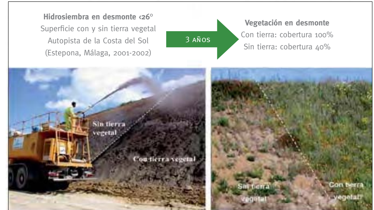
Figura 18. El efecto de la adición de tierra vegetal en la cubierta vegetal en un desmonte hidrosiembrado de la Autopista de la Costa del Sol (Málaga) fue muy patente desde un principio, así como tres años después del tratamiento. La cobertura en las zonas con tierra vegetal fue muy superior a la de las zonas sin tierra vegetal durante todo el periodo de seguimiento (3 años). Extraído de Valladares et al. , 2004.
