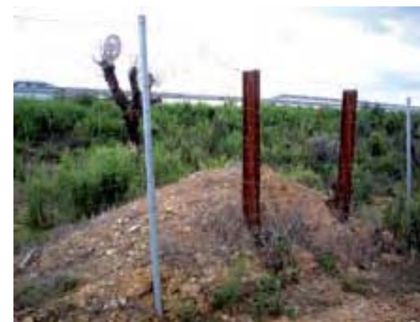
Figura 8. Dispositivos de escape para fauna mal ejecutados como consecuencia de una vigilancia ambiental deficiente o a la que no se le reconoce autoridad. El primer dispositivo estaría constituido por un muro, inexistente, y una rampa de tierra inacabada (Foto: TEG-UAM). El segundo por un portillo abatible que, al estar su base enterrada, no se puede abrir (Foto: Carlos Iglesias).
