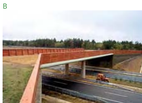
Figura 11. Pasos superiores específicos: paso en forma de diábolo construido en un tramo en la provincia de Palencia en la autovía A-231 (A) y otro paso ubicado en el tramo leonés de la autovía A-66, en el que se pueden observar como los accesos son tendidos para favorecer su uso por la fauna (B).
