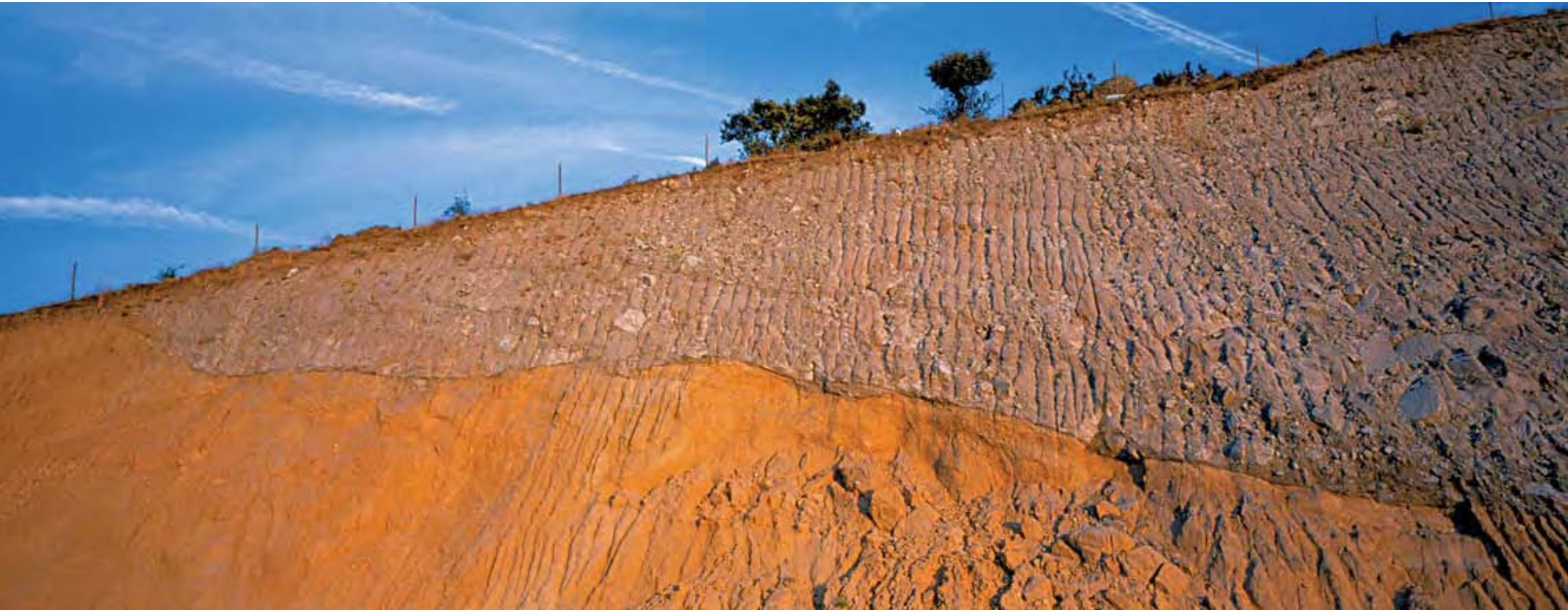
Lugar de interés geológico excepcional (cabalgamiento o falla inversa), expuesto como consecuencia de unas obras de ampliación de la carretera N-110, en el borde norte del Sistema Central (proximidades de la localidad de Villacastín). El material grisáceo situado sobre la línea oblicua (falla) son granitoides del Paleozoico que 'cabalgan' sobre los materiales anaranjados y ocreos correspondientes a arenas arcóscicas del Cenozoico (Foto: Alberto Carrera). En Díez y Martín Duque (2005).
