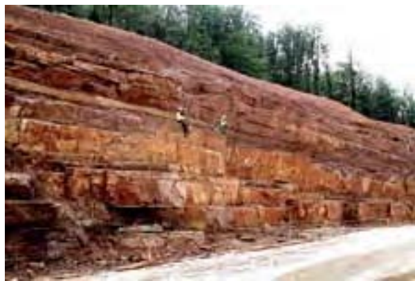
Figura 19. Aspecto de un talud Royal en construcción, en el que se están eliminando los últimos bloques inestables de forma manual. Carretera RN57, en Luxeuil, Francia (Foto: Paul Royal).
