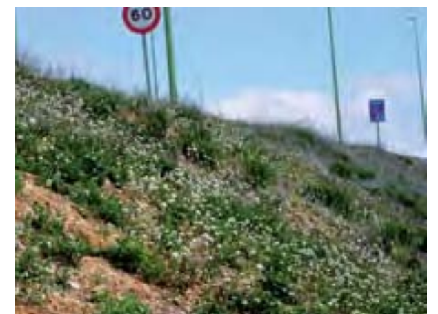
Figura 12. Primeras etapas de la sucesión en un terraplén de la Autovía A-3 (Requena, Valencia). Una de las especies pioneras de mayor éxito en la colonización de este tipo de talud es la especie anual Diplotaxis erucooides (flor blanca) (Foto: Esther Bochet).
