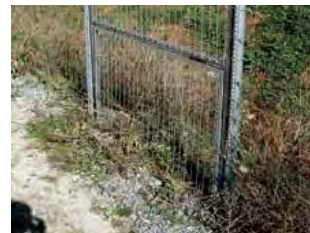
Figura 8. Dispositivos de escape para fauna mal ejecutados como consecuencia de una vigilancia ambiental deficiente o a la que no se le reconoce autoridad. El primer dispositivo estaría constituido por un muro, inexistente, y una rampa de tierra inacabada (Foto: TEG-UAM). El segundo por un portillo abatible que, al estar su base enterrada, no se puede abrir (Foto: Carlos Iglesias).
