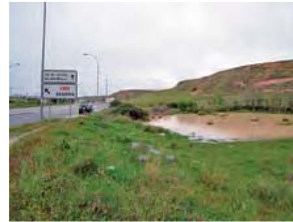
Figura 7. Ejemplo de encharcamiento ocasionado por el efecto ‘barrera o presa’ que ejerce la carretera sobre el flujo hidrológico superficial y subterráneo procedente de la ladera de la derecha de la imagen (Foto: J.F. Martín Duque).
