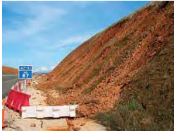
Figura 9. Deslizamientos superficiales del terreno en desmontes de una autopista, que desbaratan las actuaciones de revegetación realizadas sobre ellos (Foto: J.F. Martín Duque).
