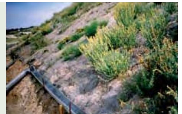
Figura 15. Vista del talud del ejemplo.
