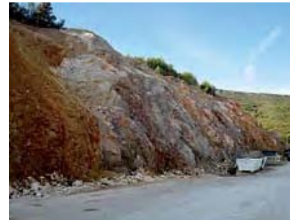
Figura 22. Aspecto de un talud Royal en construcción, en una autopista que atraviesa el macizo del Garraf (Cataluña). La Declaración de Impacto Ambiental de esta autopista puso como condición la construcción de este tipo de talud en esta zona. Nótese cómo las rocas de la izquierda de la imagen rocas de falla, más erosionables) son remodeladas formando ya una pequeña depresión en el desmonte, alcanzando desde el principio la que será su más que previsible evolución, tal y como ocurre en las laderas 'naturales' del entorno (Foto: J.F. Martín Duque).
