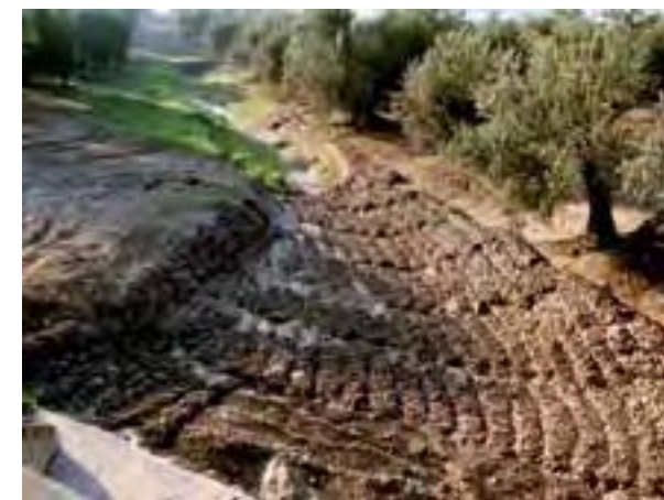
Figura 5. Gavionado flexible como refuerzo de la salida de un paso inferior. Jabalquinto, Jaén.
