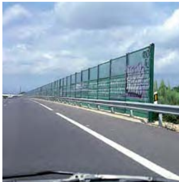
Figura 2. En la imagen superior, típico cartel que anuncia unas obras y pide disculpas a los usuarios por las molestias ocasionadas, durante las mismas que permanece por tiempo indefinido durante la fase de explotación. En la imagen inferior, unas pantallas acústicas, típica medida correctora de impacto ambiental cuya eficacia no podrá ser verificada hasta la puesta en servicio de la infraestructura (Foto: Carlos Iglesias).
