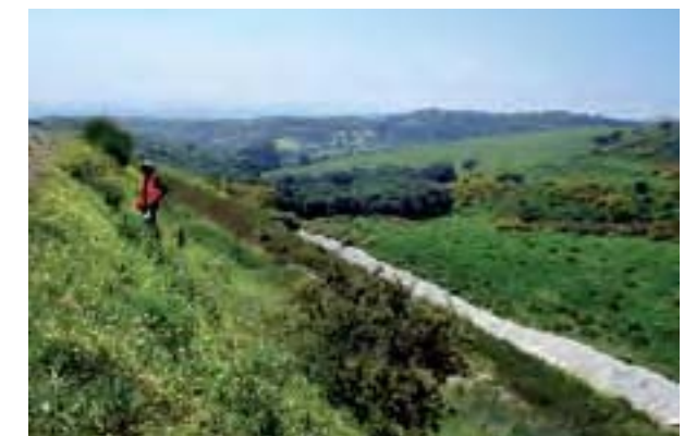
Figura 3. Terraplén con orientación sur de la autopista A-7 en la Costa del Sol, entre las localidades de Estepona y Torreguadiaro. En la foto se observa la cercanía del talud a una mancha de vegetación natural consistente en matorrales de Chamaerops humilis y Pistacia lentiscus (Foto: Santiago Soliveres Codina).
