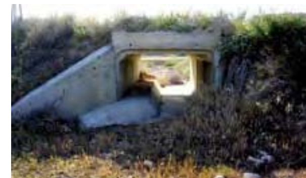
Figura 5. Drenaje adecuado con banquetas laterales (TAV Madrid Barcelona, tramo en la provincia de Guadalajara).
