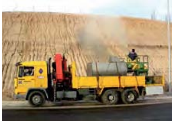
Figura 10. La hidrosiembra es una técnica habitual para sembrar semillas en amplias superficies, como los taludes que se generan al crear vías de transporte. La hidrosebradora consiste en un vehículo equipado con un tanque o cisterna en cuyo interior se mantiene en el cóctel en permanente agitación para asegurar una mezcla homogénea. Los modelos de mayores dimensiones, como el que aparece en la imagen, cuentan con una torreta en la parte superior desde la cual proyectar con una manguera la siembra (Foto: María Altamirano; OHL).
