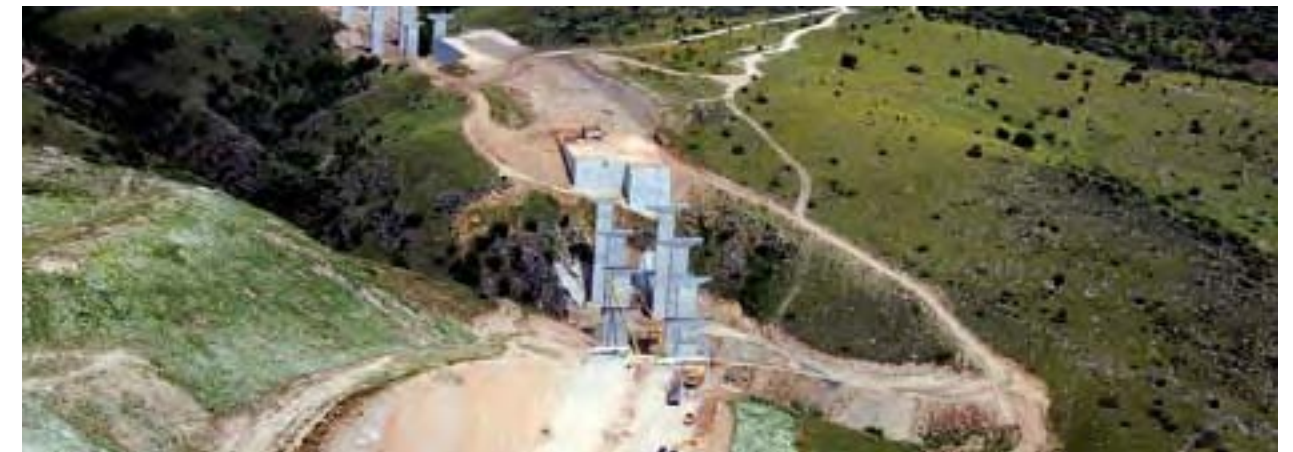
Figura 3. Vista aérea de las obras de la variante de El Molar en la A-1. Se puede apreciar la magnitud del impacto producido por el movimiento de tierras y la construcción de un viaducto (Foto: OHL).
