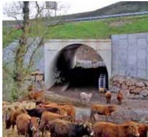
Figura 10. Usos inadecuados que comprometen la efectividad de los pasos inferiores específicos: tránsito de vehículos (A) y aprovechamiento del paso como establo (B).
