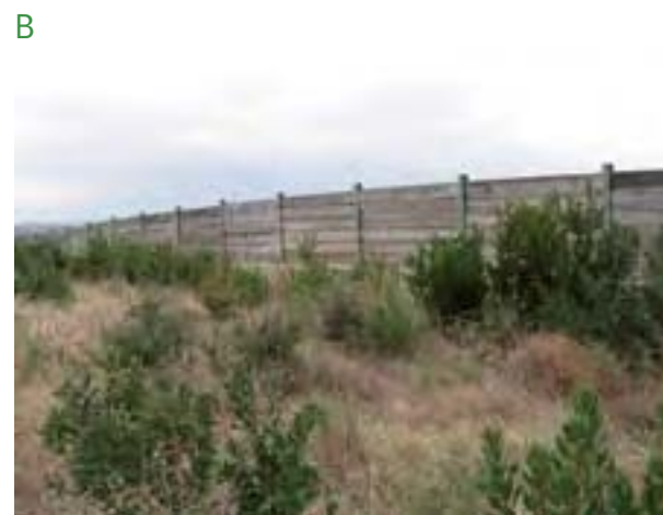
Figura 12. Ecoducto de tipo falso túnel construido en un tramo de la provincia de Cáceres de la autovía A-66 (A). Y detalle de la revegetación realizada en el interior del paso (B).
