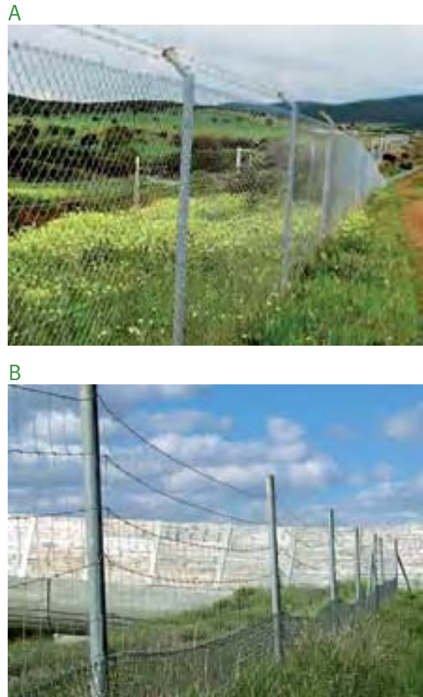
Figura 2 Tipos de cerramientos recomendados: vallado de 2 m de altura con visera hacia el interior (A), dispuesto en un tramo de la línea de alta velocidad Madrid-Sevilla (Toledo), y vallado reforzado en la base (B) en un tramo de la autovía A-66 (León).
