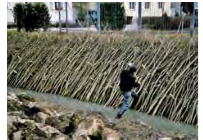
Figura 10. Fijación con alambres tensos (taller práctico, Viena, Austria).
