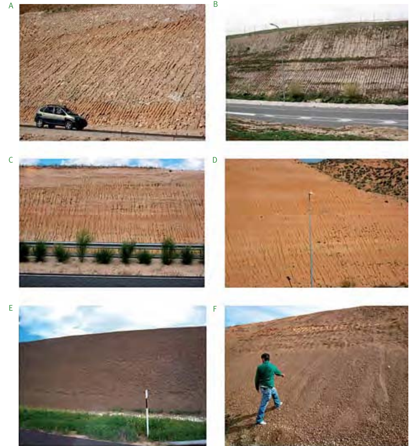
Figura 3. Morfologías que se desarrollan de manera más 'típica' sobre cada una de las litologías detríticas que caracterizan los desmontes de las infraestructuras lineales de la cuenca de Madrid, bajo condiciones climáticas mediterráneas (en Barbero et al. , 2009a) (Fotos: J.F. Martín Duque).
