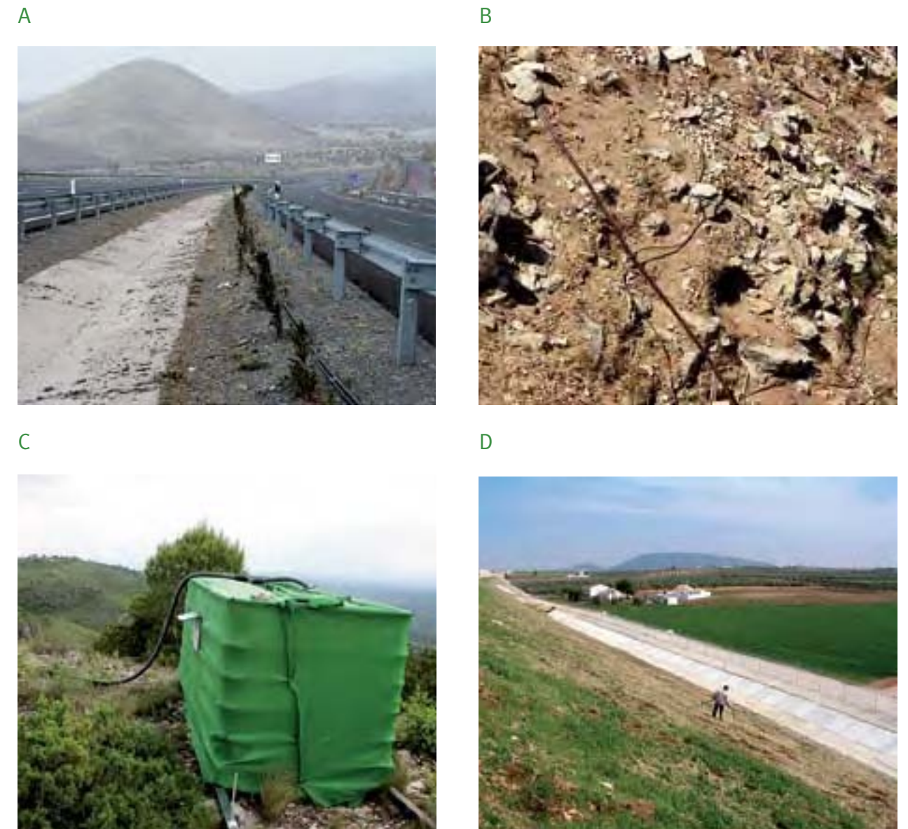
Figura 5. Detalles de tubos de riego por goteo en la mediana de la Autovía A-9 (Almería) (A) y en una ladera plantada de encina en Cazorra (Jaén) (B), una cisterna de agua para alimentar un sistema de riego por goteo en una repoblación en Ayora (Valencia) (C) y regando a mano con manguera conectada a una cuba situada en la parte superior de la infraestructura en un talud del tren de alta velocidad a Málaga (Humiladero) (D) (Fotos: Pedro Villar y Marisa Martínez).
