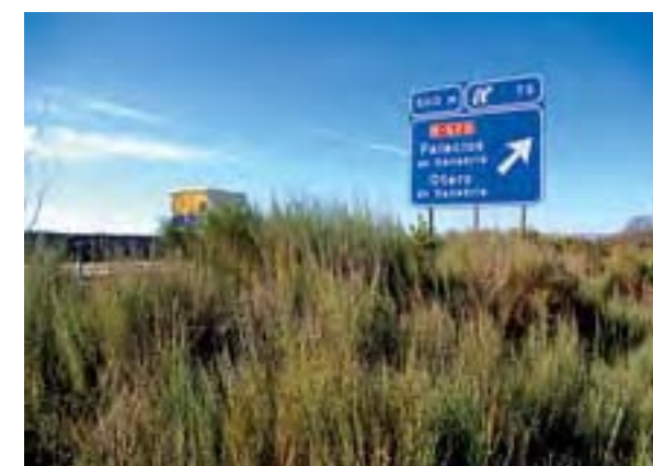
Figura 2. El mantenimiento de vegetación arbustiva en el dominio público permite conectar distintos rodales y pasos de fauna, en la imagen un tramo de la autovía A-52 (Foto: Carlos Iglesias).
