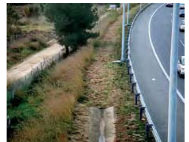
Figura 12. Siega parcial del talud de una autovía conservando parte del estrato herbáceo y un ejemplar arbóreo sin podar (Foto: Javier Martínez de Castilla; FERROVIAL-AGROMÁN).
