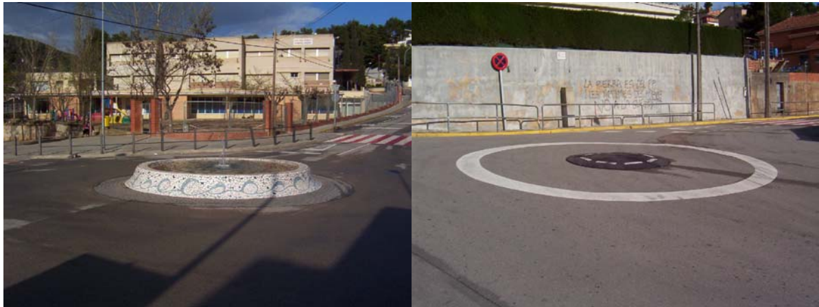
Fig. 4.5: Rotondas en Vallirana (Barcelona), en zona urbana con la clara función de calmar el tráfico obligando a reducir las velocidades para así aumentar la seguridad.
