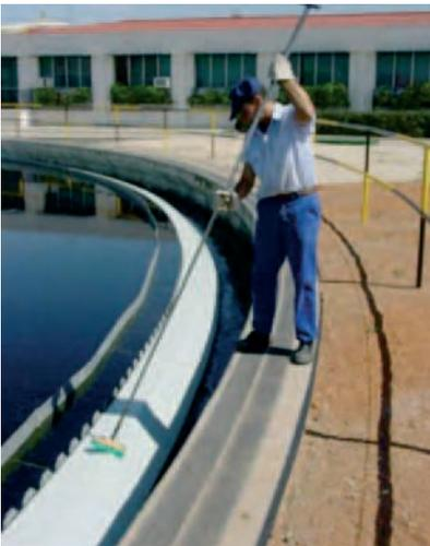
*Figura 100. Limpieza de decantador.*
