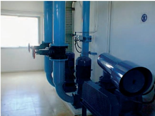
*Figura 052. Otro ejemplo de bomba soplante.*
