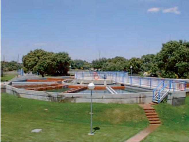
*Figura 013. Decantador circular:*
