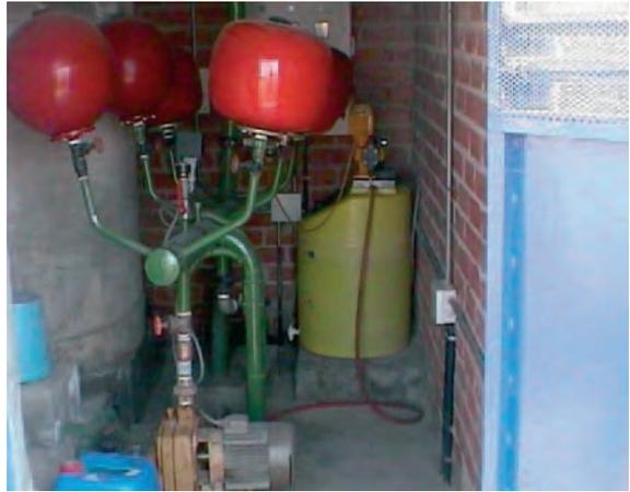
*Figura 033. Dosificación de hipoclorito en zona despejada y bien señalizada.*
