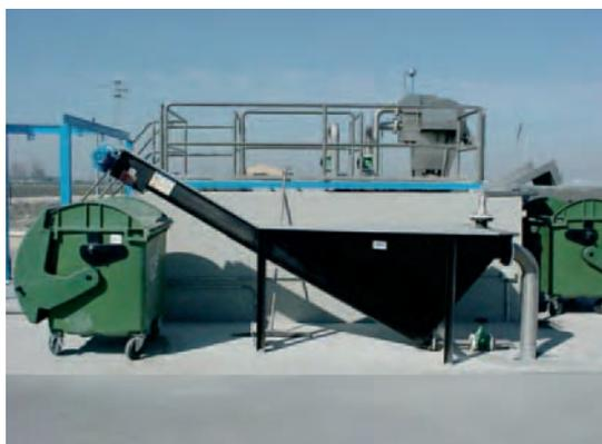
*Figura 061. Desbaste con recogida automática.*
