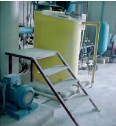
*Figura 078. Otro ejemplo de plataforma para facilitar acceso a zona de dosificación.*
