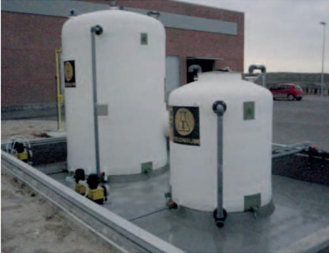
*Figura 139. Cubeto de retención en exteriores.*
