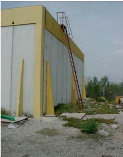
*Figura 093. Acceso a zona superior de depósito con una escalera fija inadecuada.*
