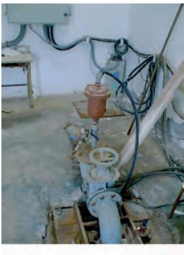
*Figura 042. Cables y canalizaciones en zona de paso.*
