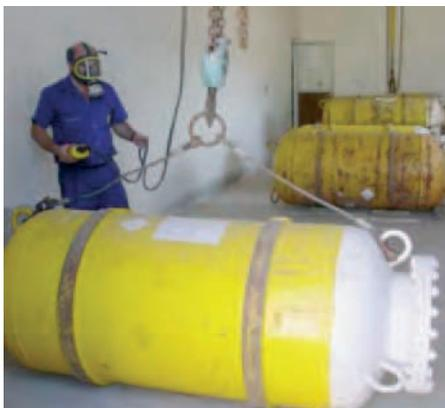
*Figura 162. Cambio de contenedores de cloro mediante polipasto. Obsérvese la máscara del trabajador*
