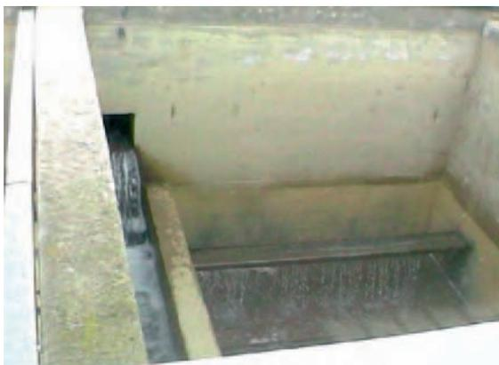
*Figura 095. Decantador vacío. Riesgo de caída a distinto nivel.*
