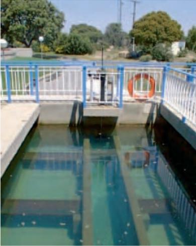
*Figura 113. Balsa de aireador con barandillas y salvavidas.*
