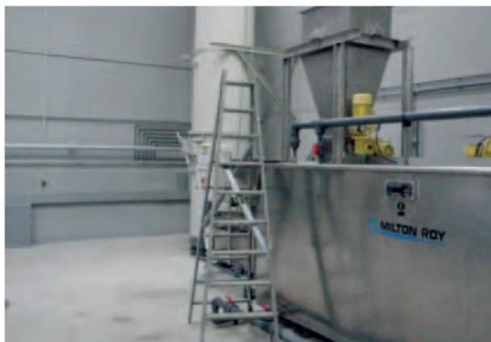
En la figura 076 imagen podemos ver una escalera demasiado elevada para tareas de dosificación, por lo que deberíamos utilizar otro elemento que tuviera más superficie de apoyo y elementos de seguridad para el trabajador en caso de caída (escaleras con barandilla en la parte superior y con una base mucho más ancha).
