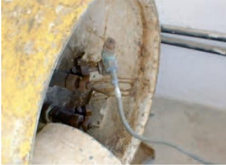
*Figura 117. Detalle de latiguillo de contenedor de cloro.*
