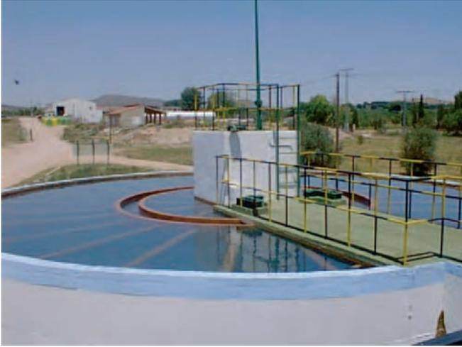
*Figura 110. Decantador protegido con barandillas aunque sin flotadores.*
