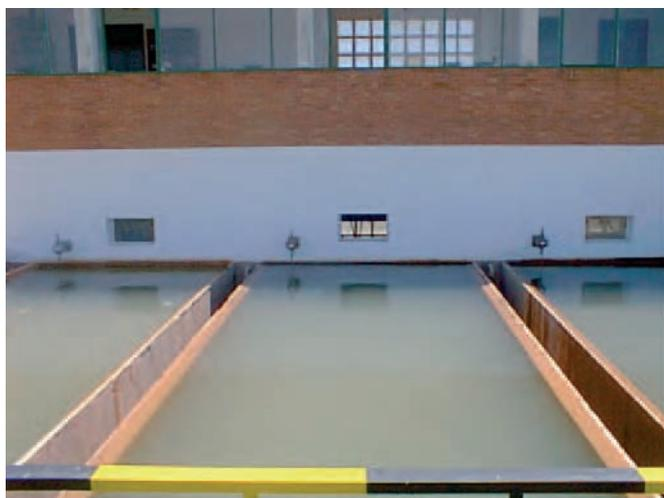
*Figura 011. Línea de desarenado.*
