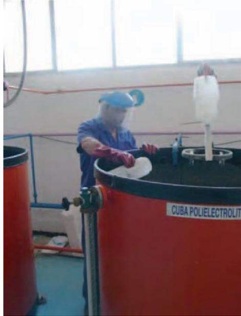
*Figura 010. Sistema para dosificación mecánica de productos de tratamiento.*
