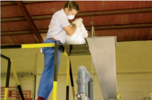
*Figura 077. Dosificación de polielectrolito con plataforma de apoyo para facilitar la misma.*
