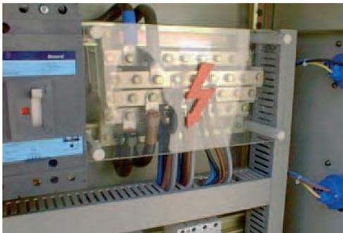
*Figura 048. Partes activas inaccesibles.*
