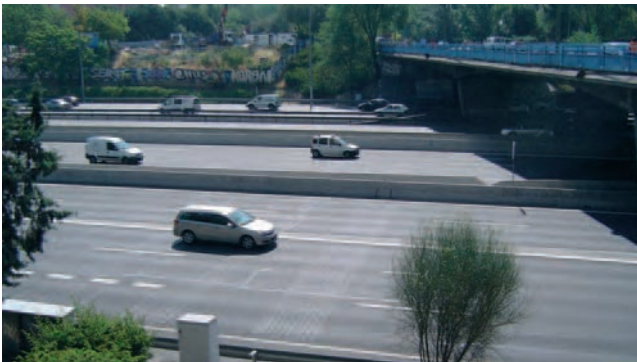
Figura 55. Grupo de espiras, colocadas en los carriles de un tramo de la M - 30.
