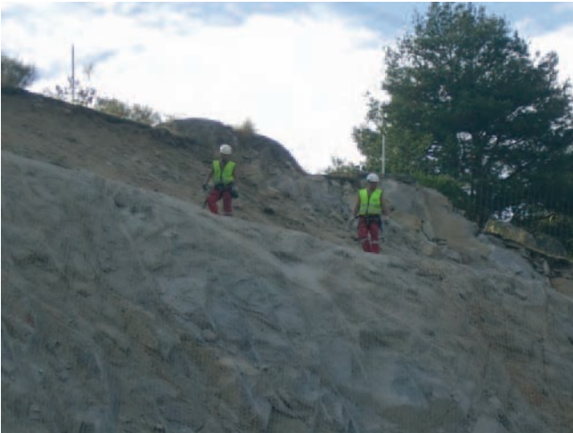
Figura 37. Sujeción de mallazo de protección del talud en la berma superior.
