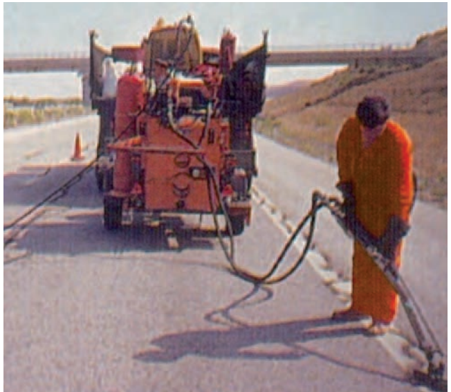
Figura 65. Sellado de grietas. Detalle del manejo de la lanza.
