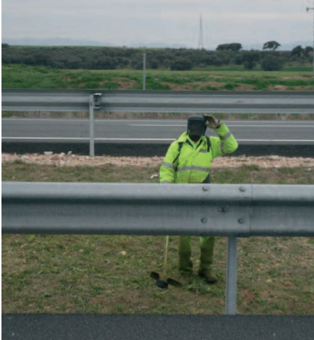
Figura 39. Desbroce en la mediana, donde el trabajador queda protegido por las biondas de los carriles de circulación.
