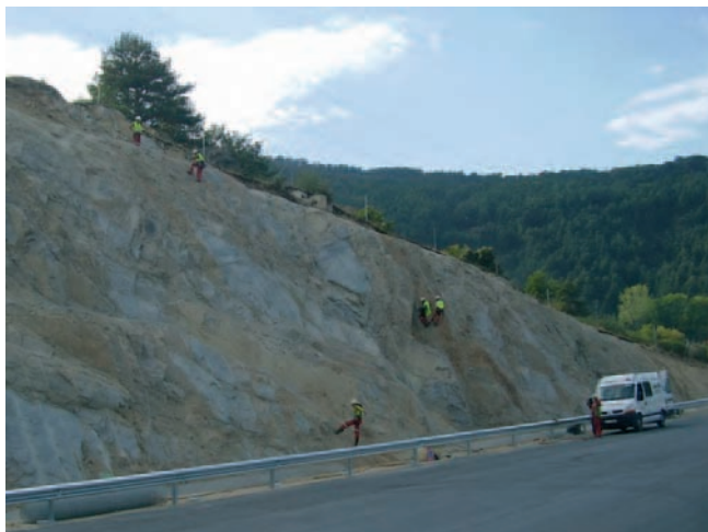
Figura 36. Trabajando a media ladera con arneses de retención.
