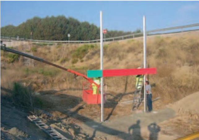
Figura 40. Montaje de señalización. Se está realizando por dos trabajadores.
