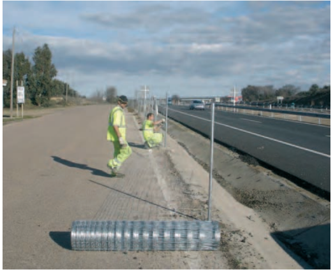
Figura 54. Colocación de vallado en autovía.
