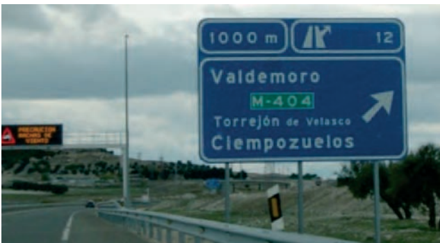
Figura 49. Panel Informativo Fijo. PIF; Panel de Información Fija, montado sin afcción al vial, se puede observar que la estructura está situada fuera de los márgenes de la carretera, inclusive sin afectar al arcén, y al ser posible, como en este caso, detrás de un tramo de bionda. Al fondo podemos observar un PIV, y un soporte para las cámaras de observación de la carretera, desde el Centro de Control.
