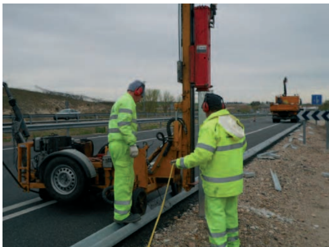
Figura 18. Máquina hincapostes trabajando en un vial en servicio.
