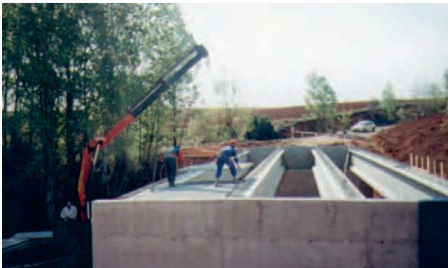
Figura 57. Encofrando losa de estructura sin elementos de protección.
