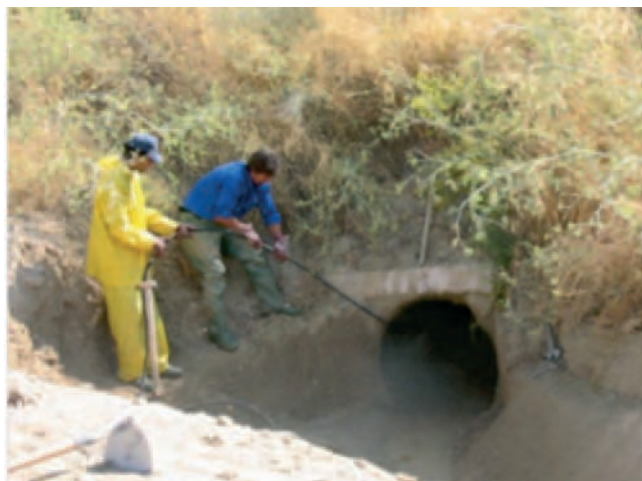
Figura 11. Tareas de limpieza en un drenaje transversal.
