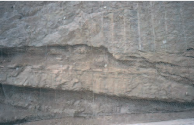
Figura 38. Protección de talud mediante malla y bulonado.
