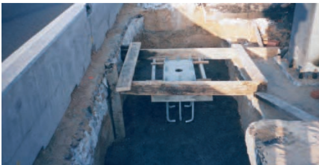
Figura 60. Cimentación de un báculo preparada para ser hormigonada.
