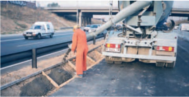
Figura 34. Hormigonado con canaleta de una cuneta.
