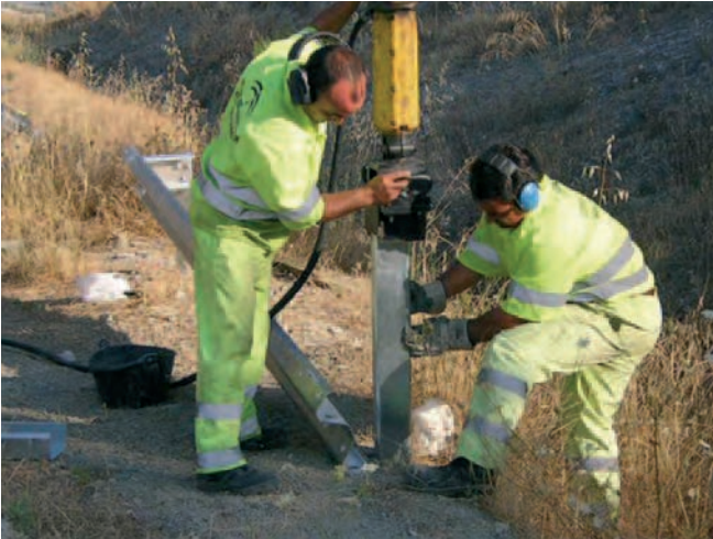
Figura 20. Utilización de EPI en la binca de postes.
