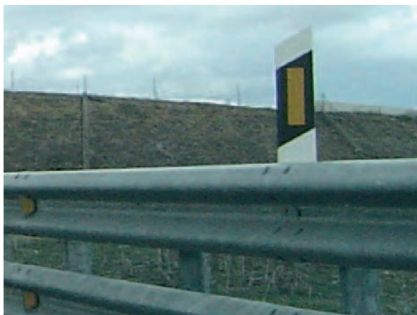
Figura 12. Barrera de seguridad de doble onda.
