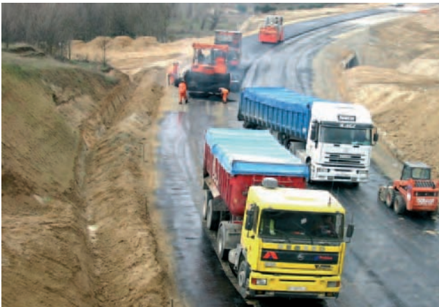
Figura 63. Extendido de aglomerado. El conjunto de máquinas intervinientes que se observan en la foto nos dan idea del riesgo de atropello que puede existir de no seguir unas normas muy estrictas en el trabajo.
