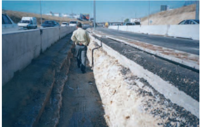
Figura 56. Zanja en zona de trabajo totalmente segura al estar protegida mediante barreras rígidas.
