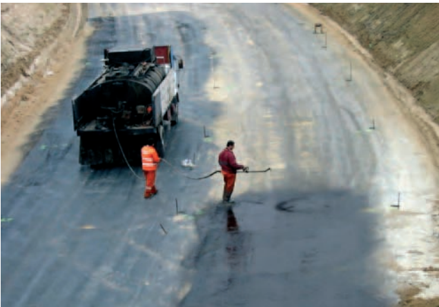
Figura 62. Riego de emulsión previo al extendido de aglomerado.
