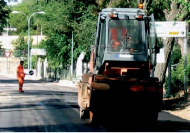
Figura 64. Señalista en zona de paso estrecha con circulación alternativa.
