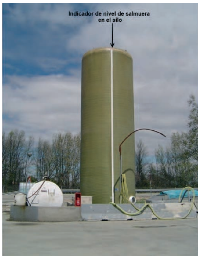
Figura 80. Depósito de fundente. Detalle del indicador de salmuera.
