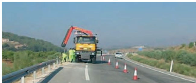
Figura 16. Cambio de bionda dañada utilizando camión grúa.
