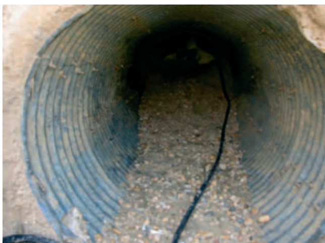
Figura 10. Drenaje transversal.
