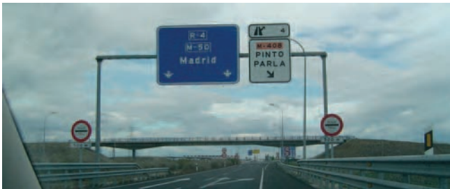
Figura 47. Panel de Información Fija (PIF), con estructura normal, grandes luces, es decir de lado a lado de la calzada.
