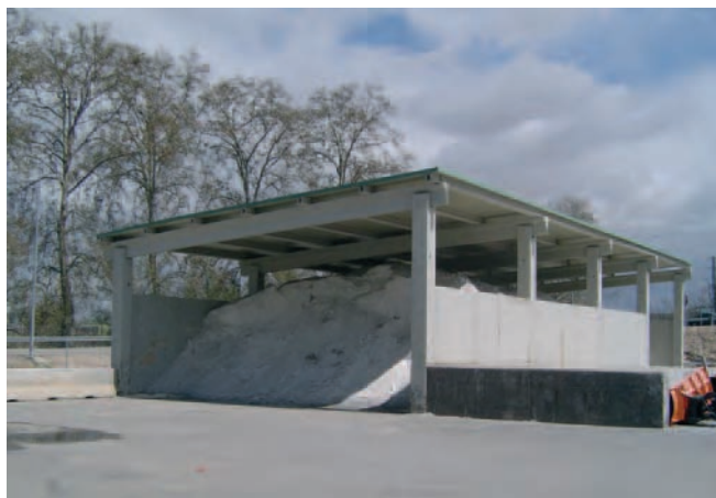
Figura 81. Vista del Almacén de Sal en la base de un Centro de Conservación.
