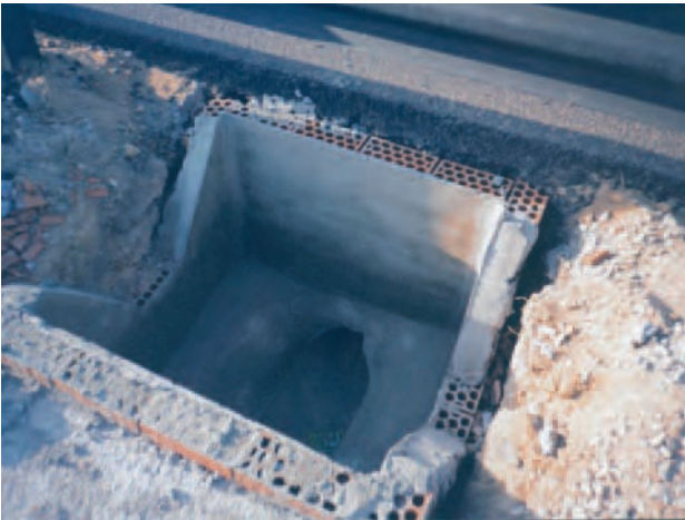
Figura 32. Detalle de arqueta fabricada “in situ”.
