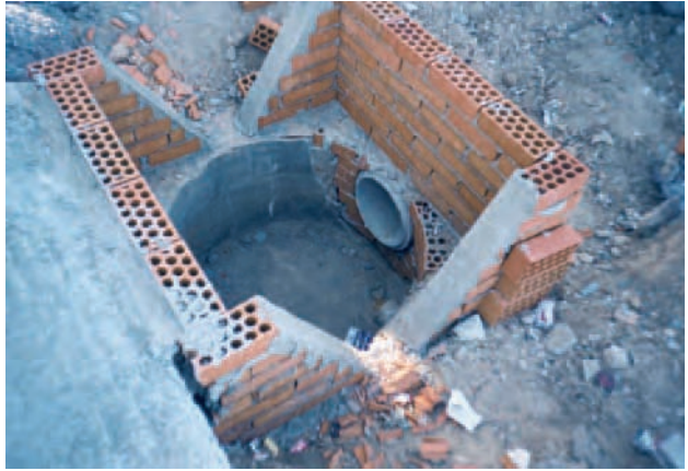
Figura 33. Detalle de ejecución de pozo en cuneta.
