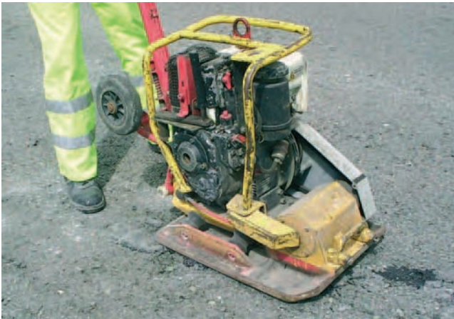
Figura 61. Compactando aglomerado en frío con compactador manual.
