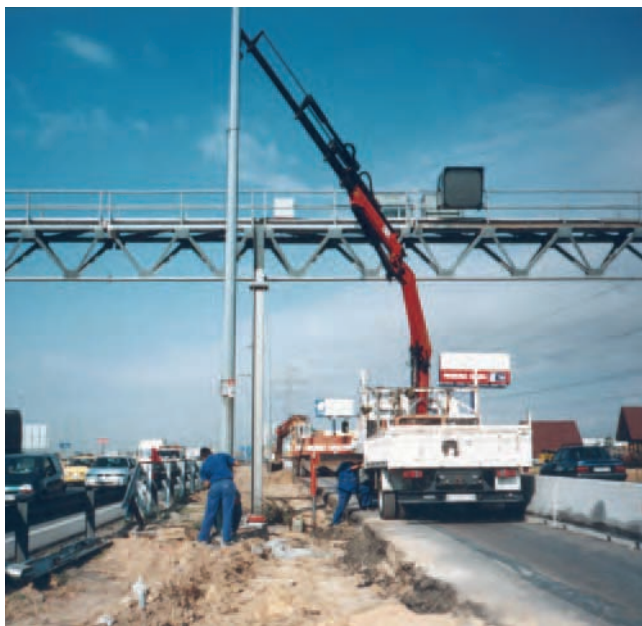
Figura 52. Colocación de báculo sobre una base ya preparada.
