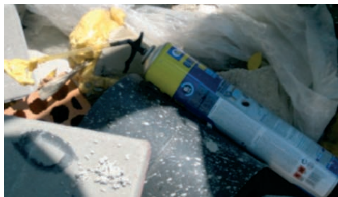
Figura 123. Material de sellado de los tubos de protección.
