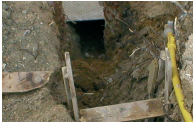
Figura 100. Solución incorrecta e improvisada que no otorga ninguna garantía. El personal que lo realice debe disponer de formación y experiencia contrastada.
