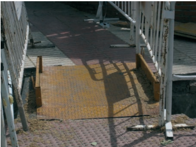
Figura 016. Pasarela peatonal y barandilla.
