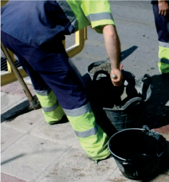
Figura 181. Preparación de mortero a mano.
