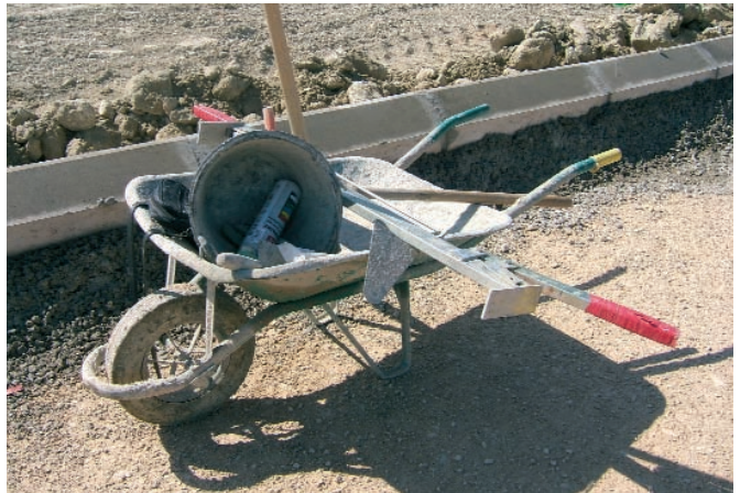
Figura 167. Útiles para desplazar y colocar bordillos entre dos trabajadores.
