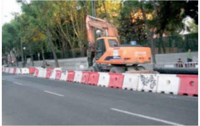
Figura 038. Demolición de acera.
