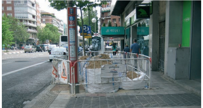
Figura 007. Acopio de material en acera adecuadamente acotado.
