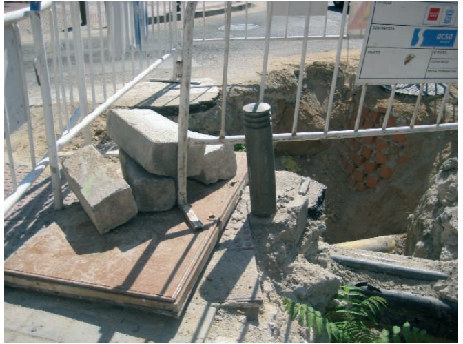
Figura 110. Detalle de materiales al borde de la zanja.
