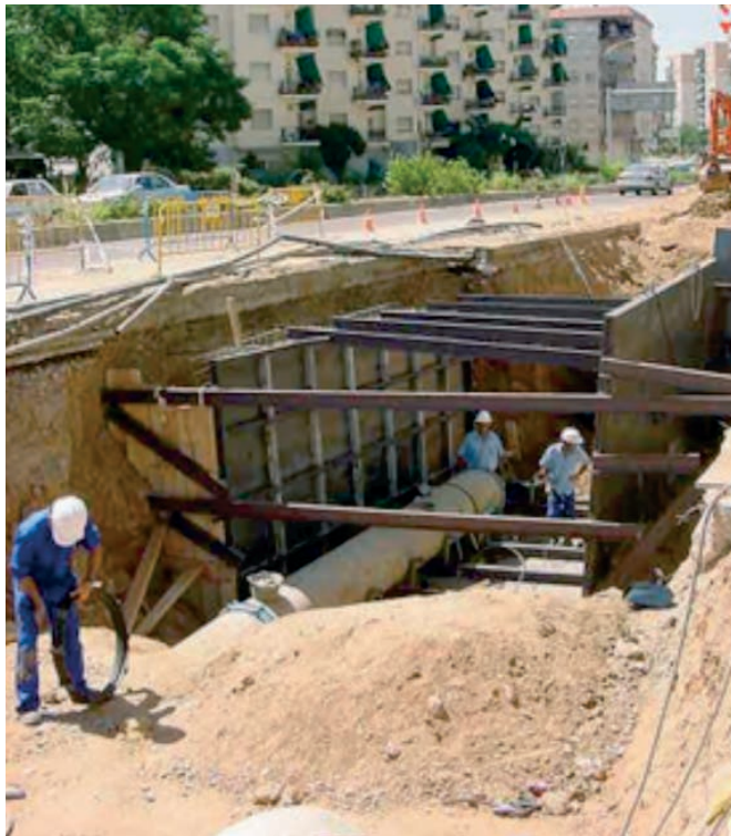
Figura 115. Una correcta disposición de los apoyos consigue desplazar el conducto de forma segura al mantenerlo en posición horizontal.
