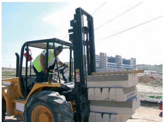
Figura 164. La carretilla elevadora permite regular la altura de recogida de bordillos a una altura óptima.
