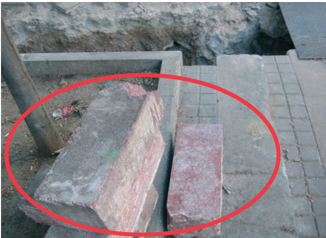
Figura 30. Piezas retiradas y protegidas para su posterior reposición.
