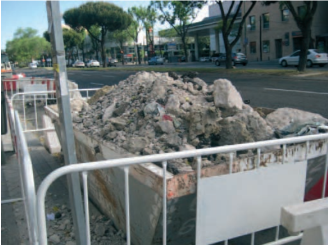
Figura 088. Contenedor sobrecargado.
