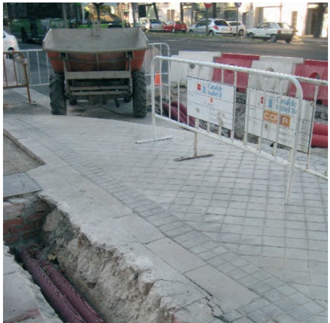
Figuras 025. Ejemplo de excavación en acera.
