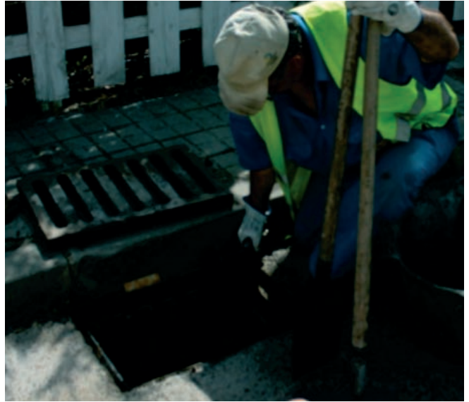
Figura 190. Limpieza de imbornal.
