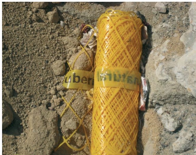
Figura 133. Cinta de señalización de gas.
