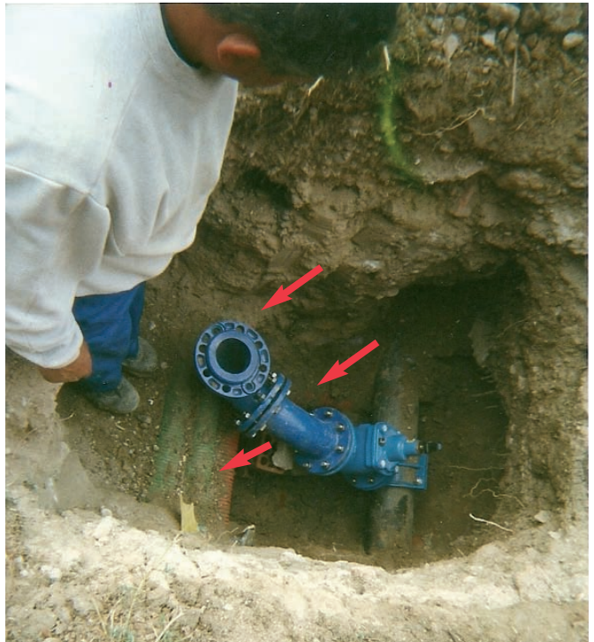
Figura 131. Instalación de hidrante con uniones mecánicas sobre tubos protectores de electricidad.
