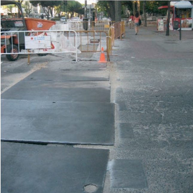
Figuras 026. Ejemplo de excavación en calzada.
