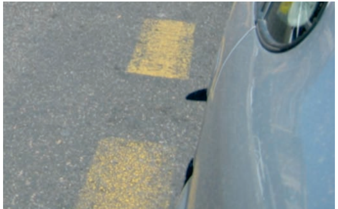
Figura 004. Marca ocultada con pintura negra en pésimo estado de conservación, que da lugar a la aparición del color amarillo.
