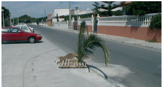
Figura 008. Hueco con protección inadecuada y sin señalizar.
