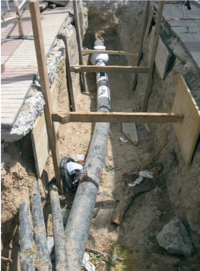
Figura 078. Conducción de gas antigua.
