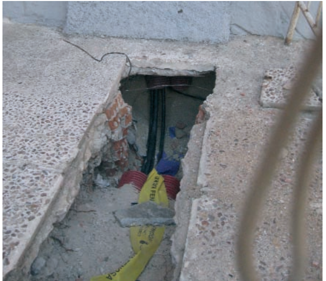
Figura 034. Acometida de electricidad. Protegida por una capa de arena lavada y señalización con banda de polietileno amarilla.
