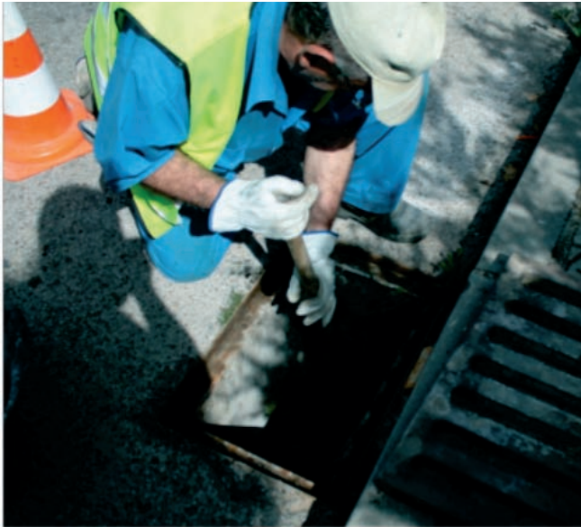
Figura 189. Limpieza de imbornal.
