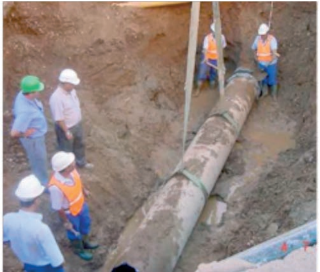
Figura 114. Manipulación de tubos aborcándolos con eslinga.
