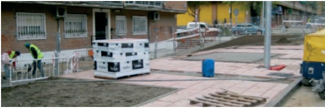
Figura 040. Ruido generado por martillo y funcionamiento del compresor.
