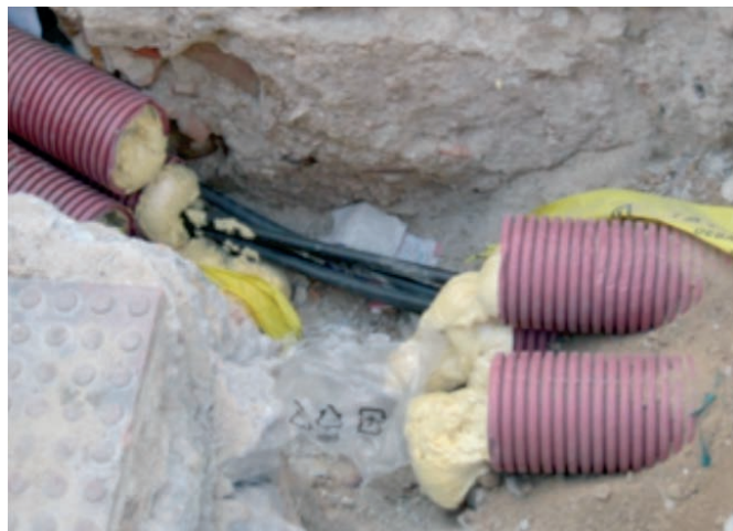
Figura 122. Sellado de tubos de protección.
