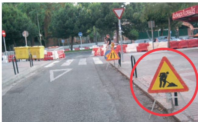
Figura 005. Señal de “peligro obras” en la calzada.
