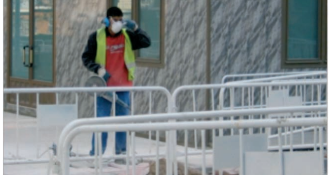
Figura 169. Uso correcto de EPI´s durante el corte con radial.
