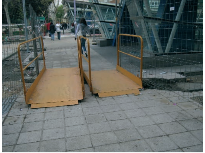
Figura 136. Doble pasarela peatonal.
