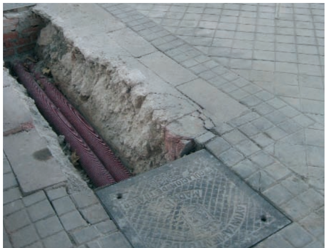
Figura 129. Canalización de regulación de tráfico.
