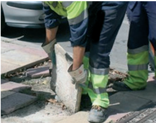
Figura 174. Levantamiento de baldosas a mano.
