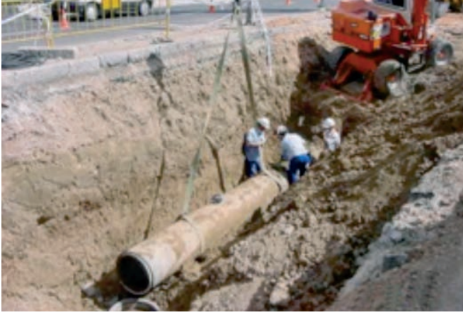
Figura 092. Taluzado de las paredes de la zanja.
