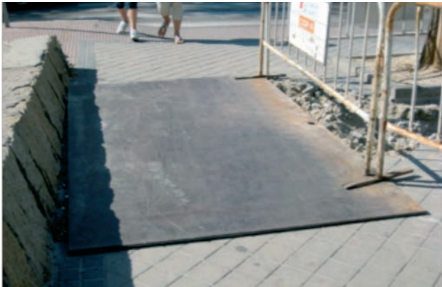
Figura 023. Chapón para el paso de peatones o vehículos.
