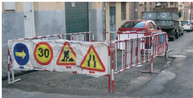
Figura 002. Vallado y señalización de zona de trabajo.
