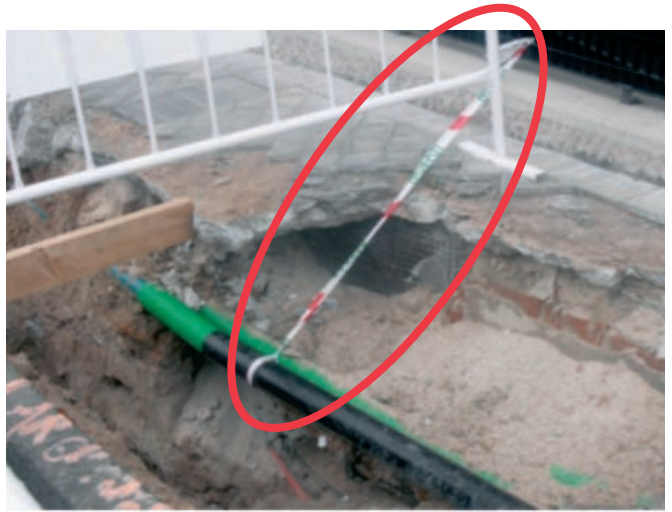
Figura 074. Evitar improvisaciones en el apeo de conductos cuando queden descolgados.
