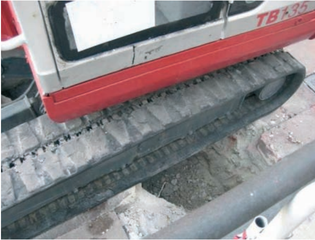
Figura 062. Apoyo de máquina sobre zanja.
