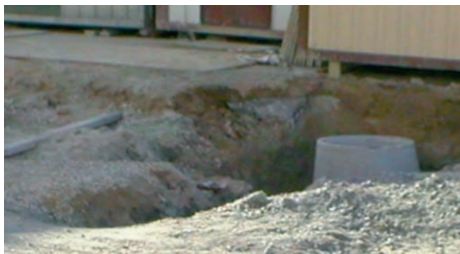
Figura 108. Acceso a zanja mediante rampa.
