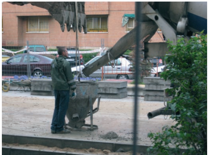
Figura 155. Utilización de cubos para vertido; precaución durante su elevación y recepción.
