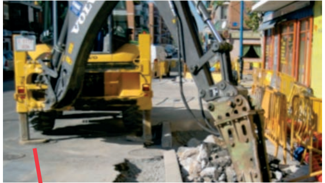
Figuras 055 y 056. Apoyo del estabilizador de la retro-pala en una arqueta de registro.
