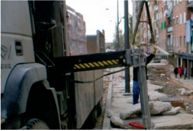
Figura 162. Extremar precaución durante recepción y guiado de utillaje y cargas.
