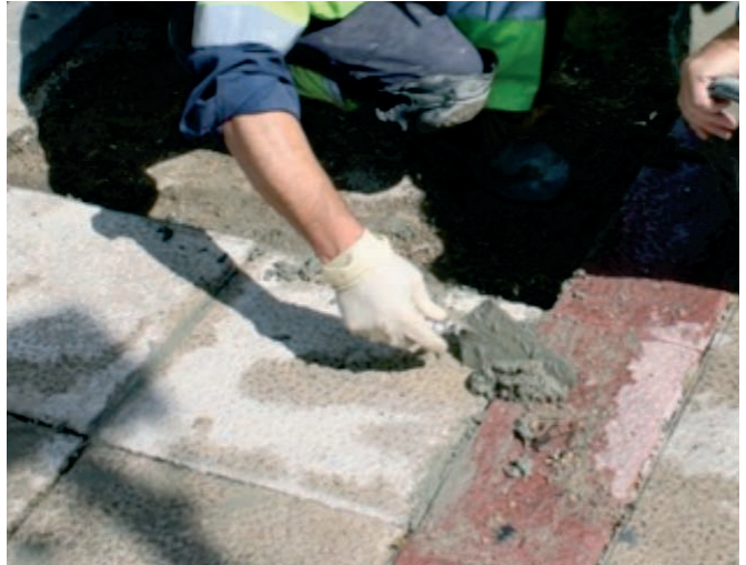
Figura 184. Colocación de baldosas.
