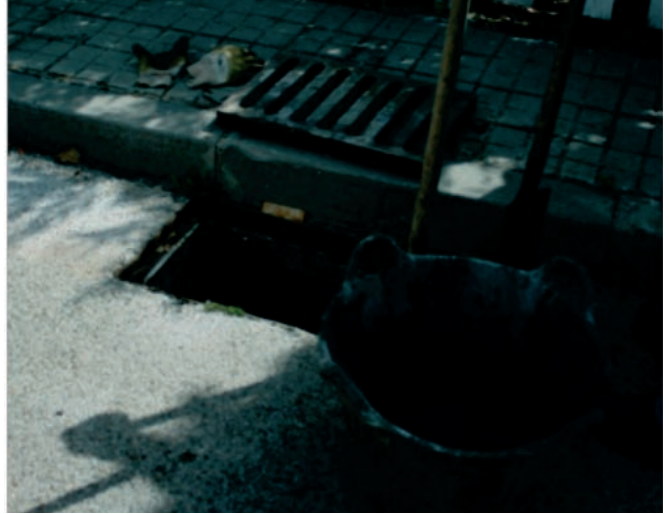
Figura 187. Retirada de rejilla.
