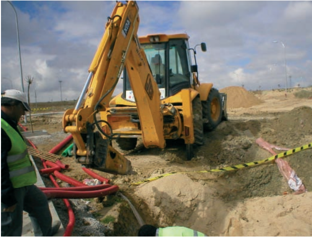
Figura 042. Retro pala. Equipo de trabajo muy utilizado en la apertura de zanjas.
