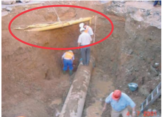
Figura 075. Sujeción de conductos.
