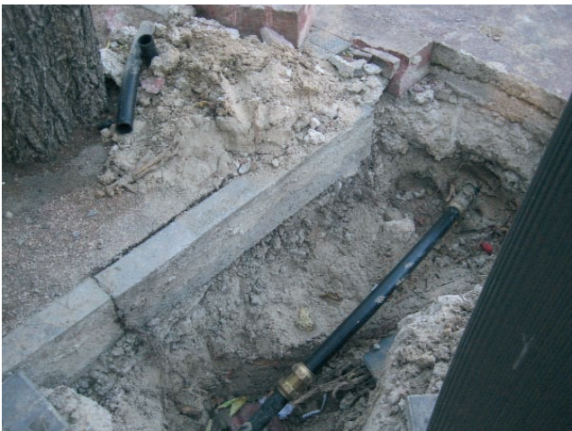
Figura 032. Acometida de agua.
