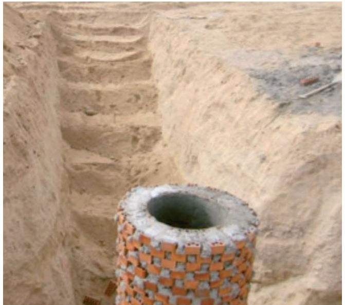
Figura 107. Acceso a zanjas mediante escalera realizada en el propio terreno.
