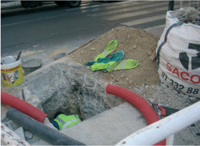
Figura 031. Cala para reparación de un servicio.
