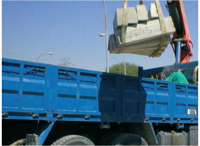
Figura 161. Maniobra de descarga incorrecta; materiales sueltos, elevación bordillos con pluma sin paletizar.
