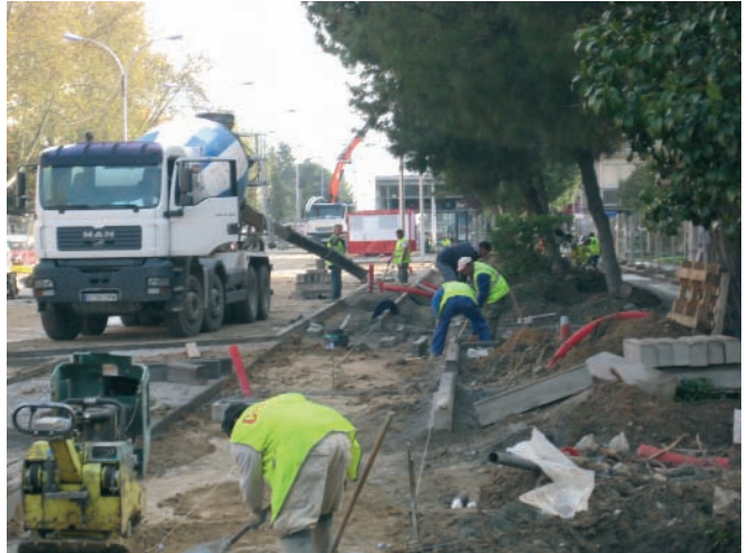
Figura 154. Vertido de hormigón con canaleta.
