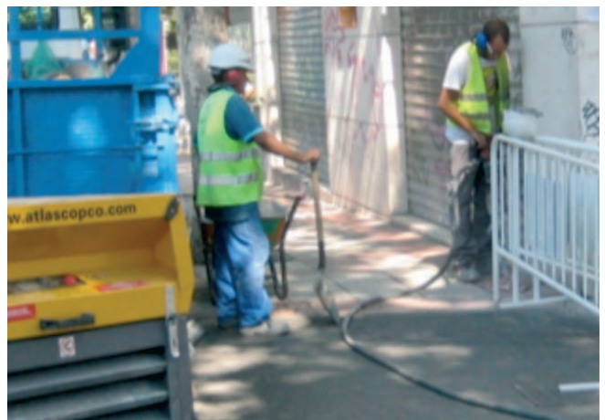
Figura 045. Posición correcta del trabajador que patea, puesto que mantiene una cierta distancia.
