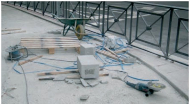
Figura 170. El corte de bordillo de granito requiere el uso de mascarilla autofiltrante como mínimo de tipo FFP2, como consecuencia de su contenido en sílice.
