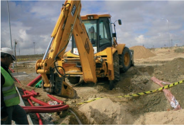
Figura 058. Apoyo sobre tierra. Extremar la precaución cuando el terreno esté húmedo.
