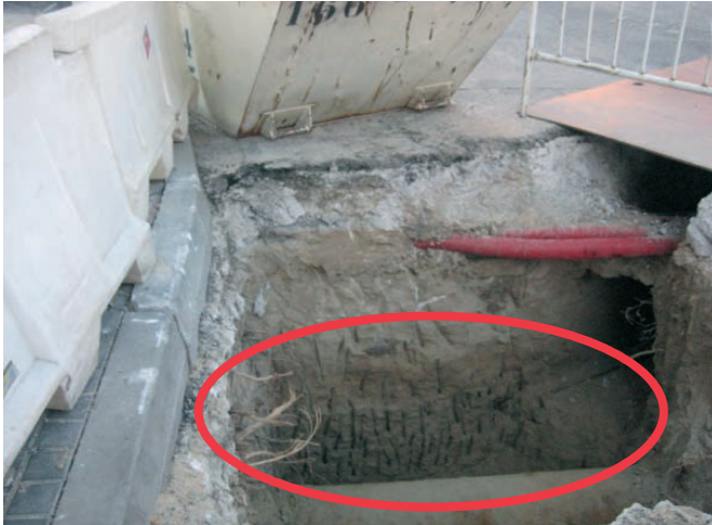
Figura 073. Detalle de las marcas del martillo rompedor en la proximidad de la canalización. De esta manera se mantiene un mejor control, reduciendo la posibilidad de dañarla.
