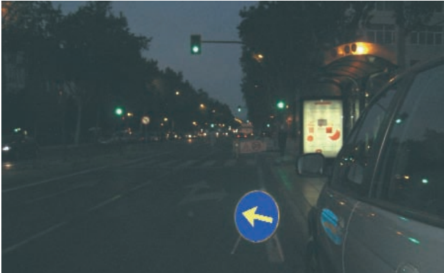
Figura 012. Señalización de obra, señal reflectante.
