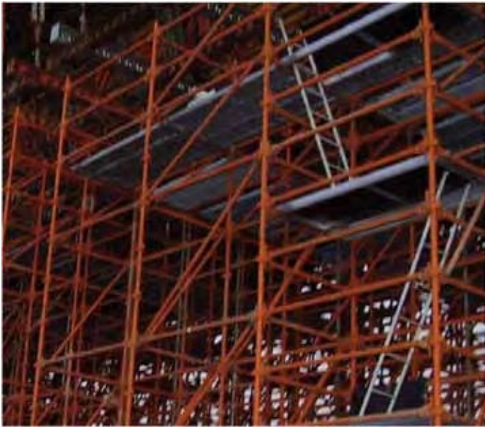
Fig. 59 Montaje de cimbras con escalera y plataformas de acceso.
