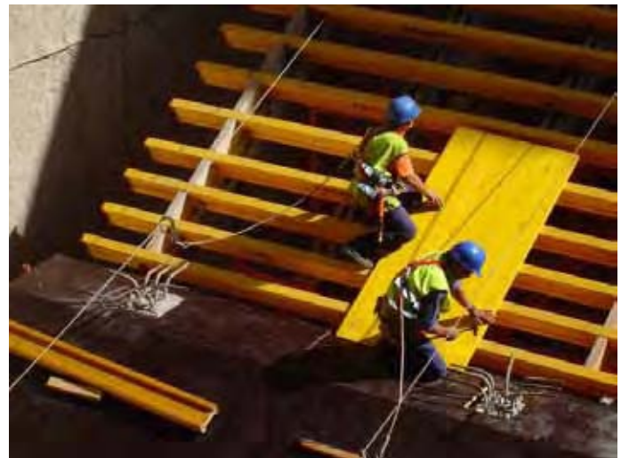
Fig. 61 - Utilización de arnés de seguridad en el montaje de encofrado sobre cimbra.
