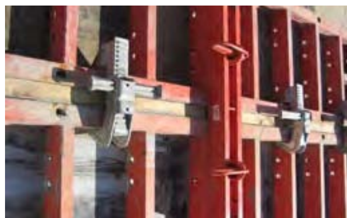
Fig. 9 - Ganchos para arnés de seguridad. Taladros en las costillas de paneles de encofrado.
