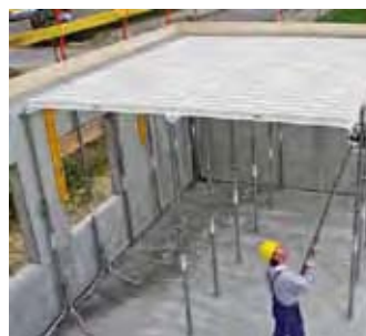
Fig. 70 – Secuencia del montaje del forjado desde el nivel anterior.
