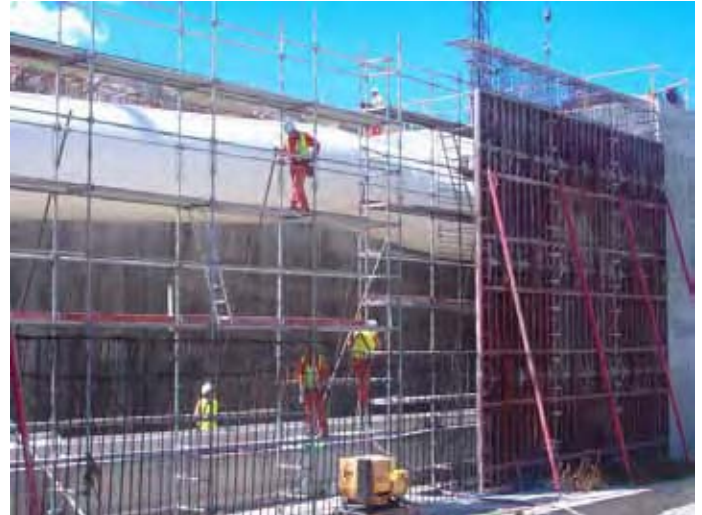
Fig. 74 – Andamio en intrados para montaje de armadura.
