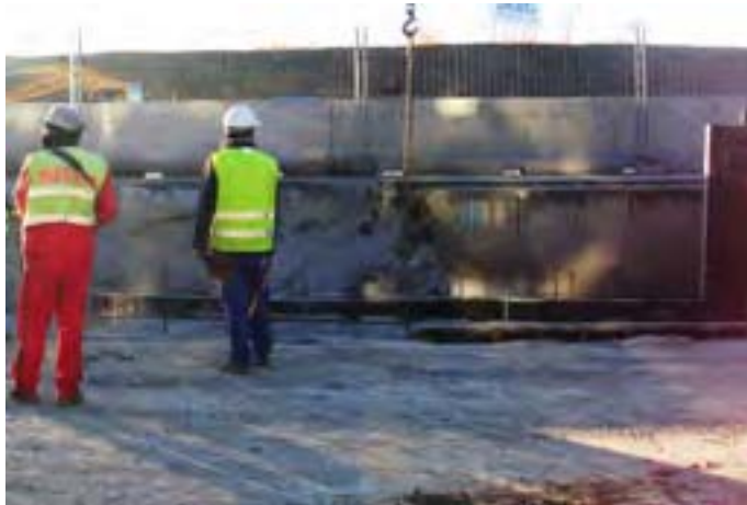
Fig. 3 - Desmontaje de paneles de encofrado.
