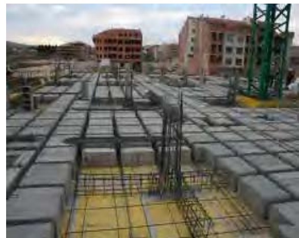
Fig. 28 – Forjado bidireccional: de casetón recuperable y de casetón perdido.
