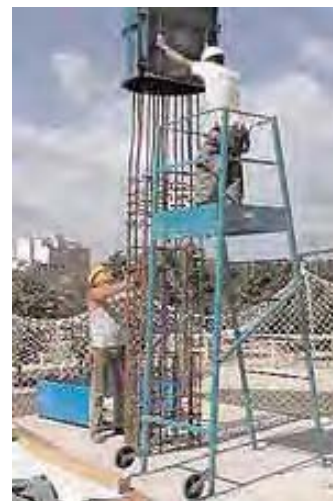
Fig. 84 – Castillete de hormigonado empleado para el montaje de encofrado de pilas
