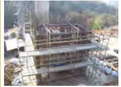
Fig. 47 – Montaje de tramo de armadura de una pila.
