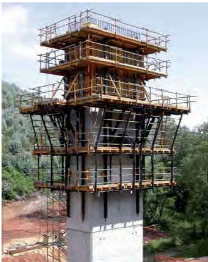
Fig. 39 – Encofrado autotrepante: esquema y construcción de pila de viaducto (ULMA)
