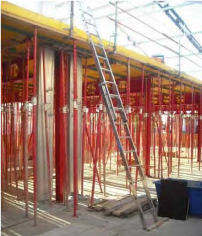
Fig. 67 Encofrado simultáneo de escaleras de acceso entre forjados
