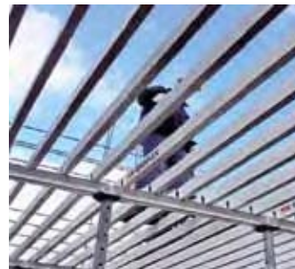
Fig. 70 – Secuencia del montaje del forjado desde el nivel anterior.
