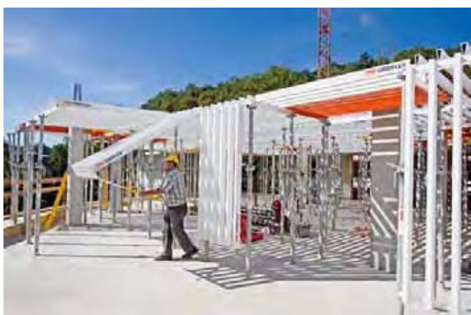
Fig. 69 – Sistema de montaje manual desde el nivel anterior.
