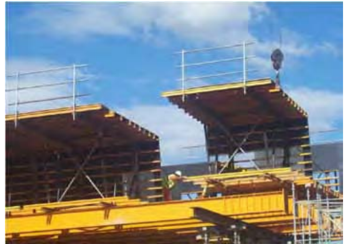
Fig. 60 - Posicionamiento de barcos sobre cimbra con protecciones de borde integradas
