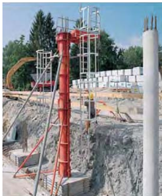
Fig. 82 – Accesos y plataformas de hormigonado integradas en encofrados de pilares
