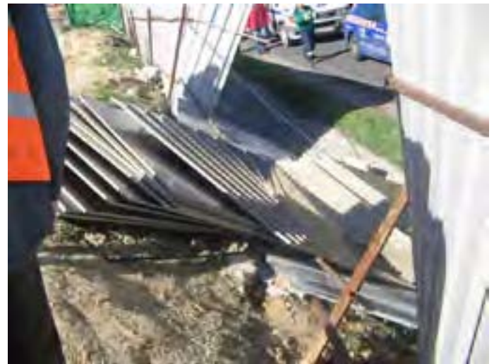
Fig. 5 - Situación tras el desplome del paquete de encofrados fenólicos. Afección al cerramiento de obra.
