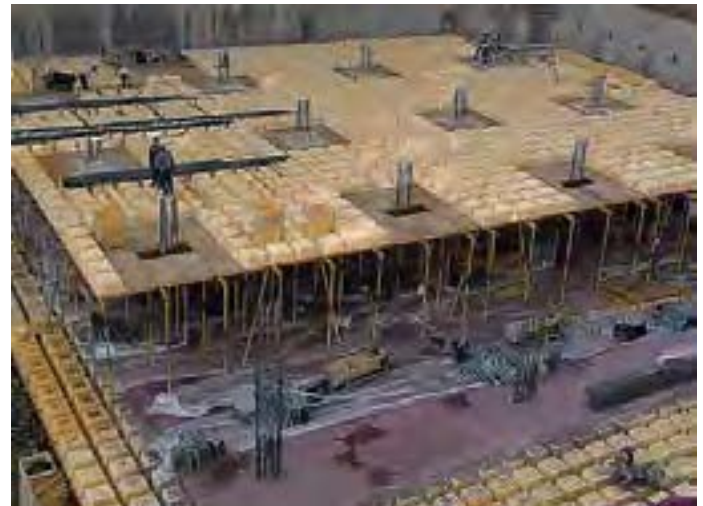
Fig. 27 – Casetones recuperables y casetones perdidos.
