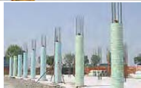
Fig. 31 – Ejecución de pilares: encofrado de sección rectangular y encofrado desechable para pilares.
