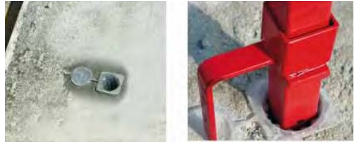
Fig. 65 Soportes y protección de borde en losas y forjados ejecutados
