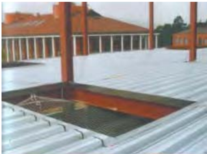
Fig. 29 – Encofrado con chapa colaborante en estructura metálica.
