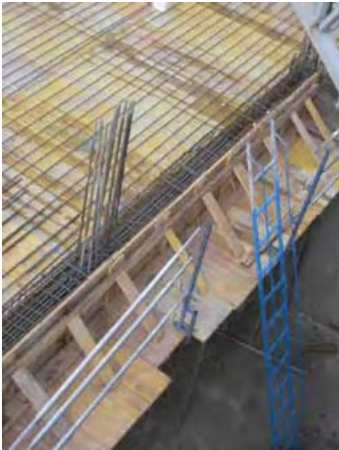
Fig. 52 - Pasillos de encofrado en el borde de estructuras de edificación y de obra civil.
