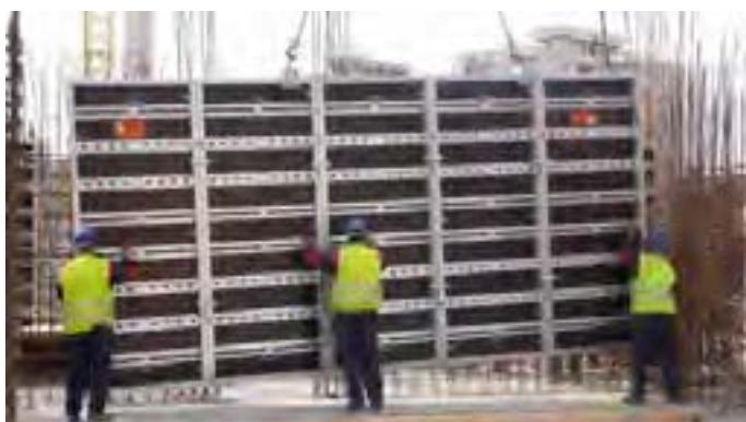
Fig.2 - Eslingaje, movimiento y posicionamiento de encofrados
