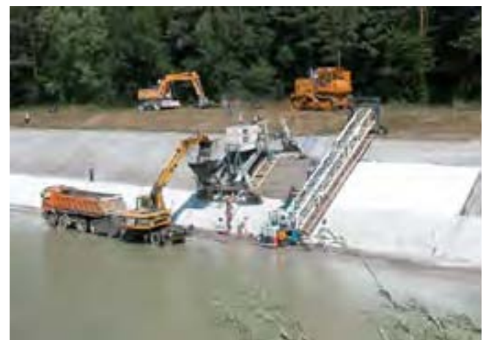
Fig. 42 – Ejecución de diferentes estructuras mediante encofrado deslizante: pila y canalización de río.
