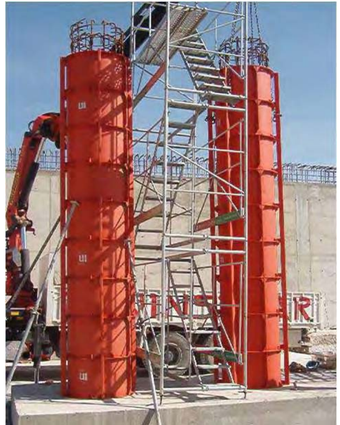
Fig. 77 - Encofrados estándar metálicos de pilas
