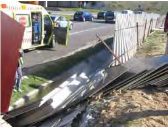
Fig. 5 - Situación tras el desplome del paquete de encofrados fenólicos. Afección al cerramiento de obra.
