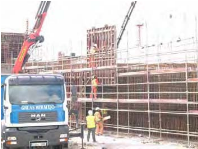
Fig. 72 – Montaje de encofrado entre la armadura y el andamio de montaje de ferralla.
