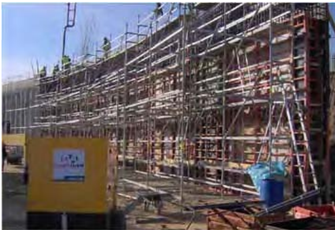
Fig. 73 - Andamios autoestables en el intradós del muro, independientes del encofrado.
