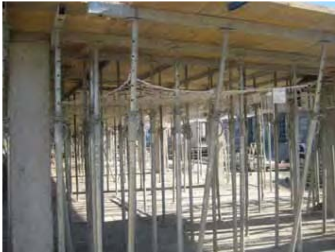
Fig. 54 - Marcado y montaje de redes bajo forjado.
