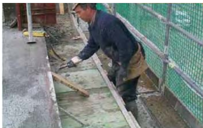
Fig. 51 – Andamio perimetral a la estructura de la edificación
