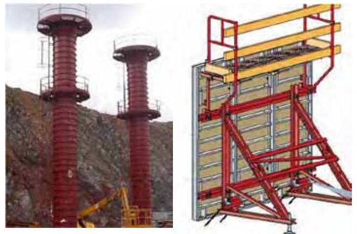
Fig. 75 – Sistemas de encofrado con plataformas de trabajo integradas
