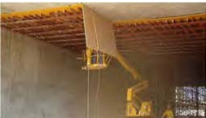
Fig. 12 - Paneles de encofrado adheridos al hormigón y en excavación bajo losa. Desmontaje de encofrado de fondo en paso inferior.
