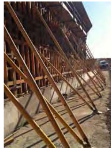
Fig. 71 – Apeo provisional de paneles con puntales tradicionales y arriostamiento de sistema de encofrado
