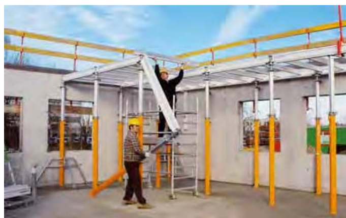
Fig. 63 - Andamios empleados en montaje de elementos de soporte de forjados unidireccionales.
