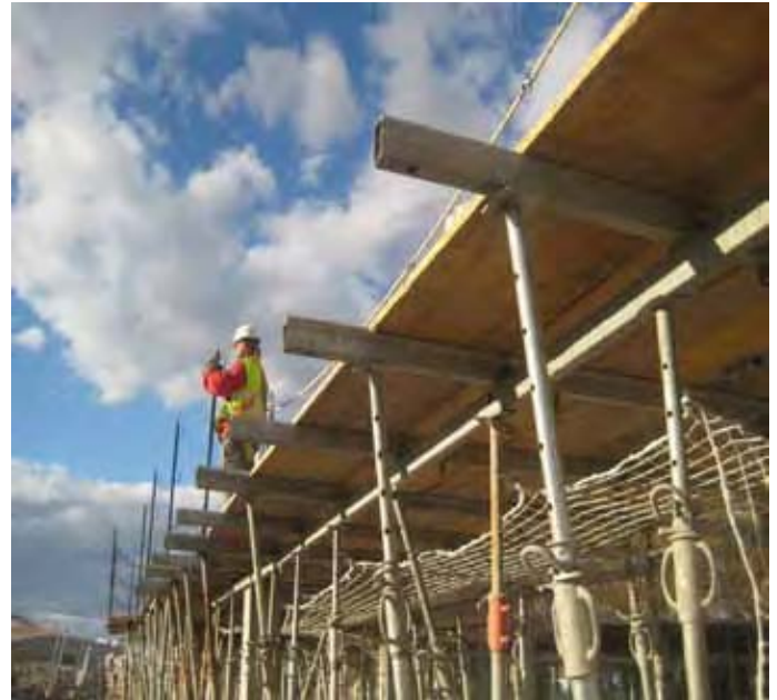
Fig. 56 - Utilización de protección individual (arnés de seguridad) para el montaje de protecciones de borde.
