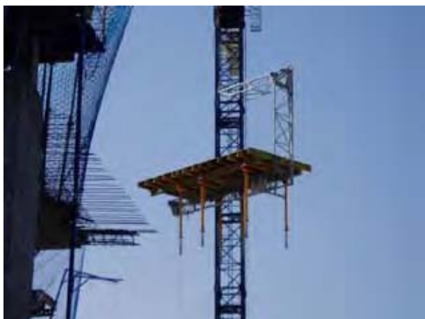
Fig. 50 – Manipulación de mesa de encofrado mediante grúa torre
