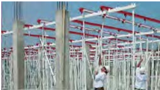
Fig. 24 – Sistema de encofrado para realizar forjados reticulares
