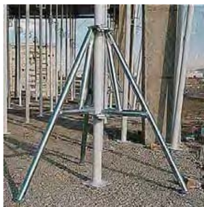
Fig. 64 - Trípodes de estabilización de puntales
