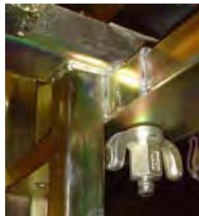
Detalle de montaje de la consola de trabajo sobre el panel. Utilización de pasador y tuerca.
