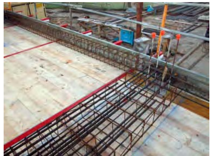
Fig. 21 - Encofrado de viga de cuelgue. Detalle de armado
