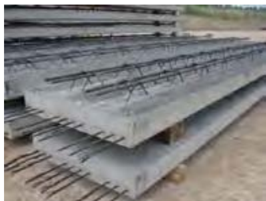
Fig. 18 - Sistema de encofrado de mediante semilosa prefabricada. Detalle de semilosa prefabricada.
