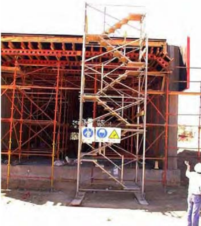
Fig. 66 Sistemas de acceso a encofrados: escalera de mano y andamio
