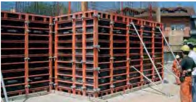
Fig. 34 – Encofrado de muro a dos caras.
