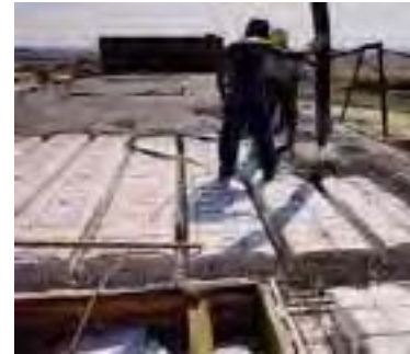
Fig. 27 – Casetones recuperables y casetones perdidos.
