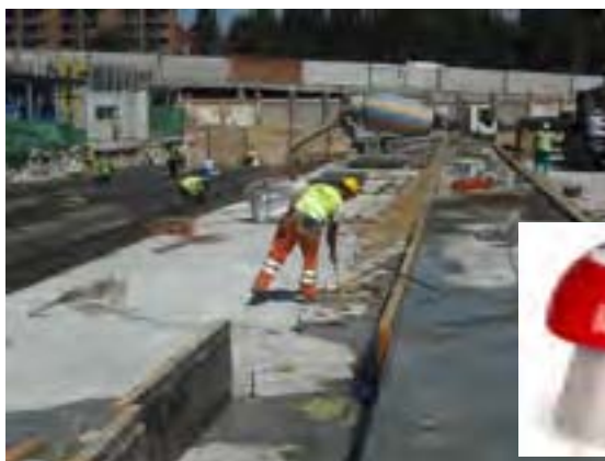
Fig. 11 - Barras de tetracero introducidas en el hormigón de limpieza para apuntalamiento y atirantamiento de encofrados. Seta de protección para esperas de armadura.
