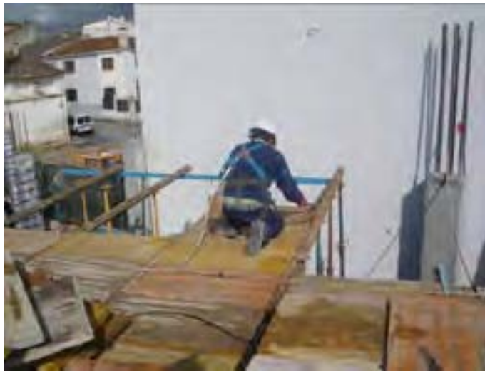
Fig. 10 - Montaje de entablado de losa de forjado con utilización de arnés de seguridad.
