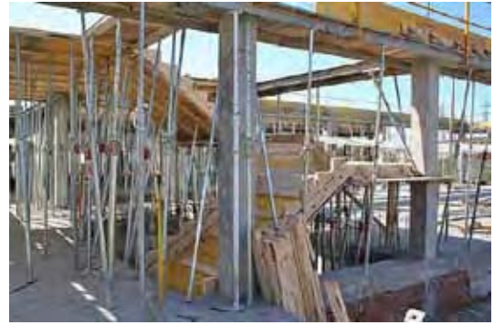
Fig. 67 Encofrado simultáneo de escaleras de acceso entre forjados
