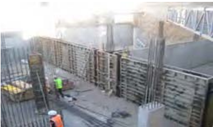
Fig. 4 - Paneles de encofrados verticales en muros de edificación.
