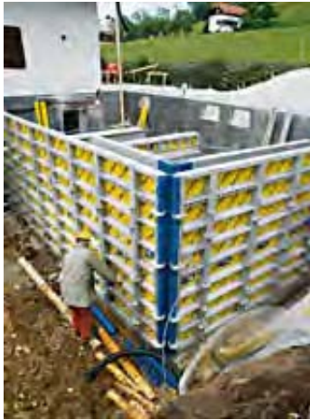
Fig. 32 – Encofrados verticales: de muro y de muro circular.
