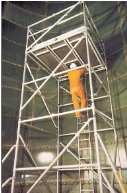
Plataformas para montaje de instalaciones en altura
