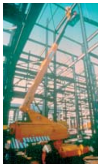
Montaje de pabellón utilizando grua y plataformas elevadoras
