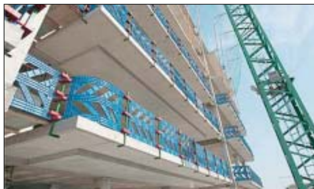
Barandilla fabricada con materiales sintéticos
