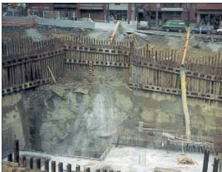
Contención con carriles
