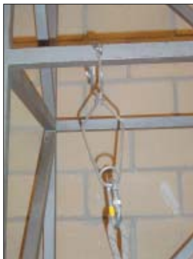
Sistemas de sujeción de líneas de vida (o puntos fuertes)
