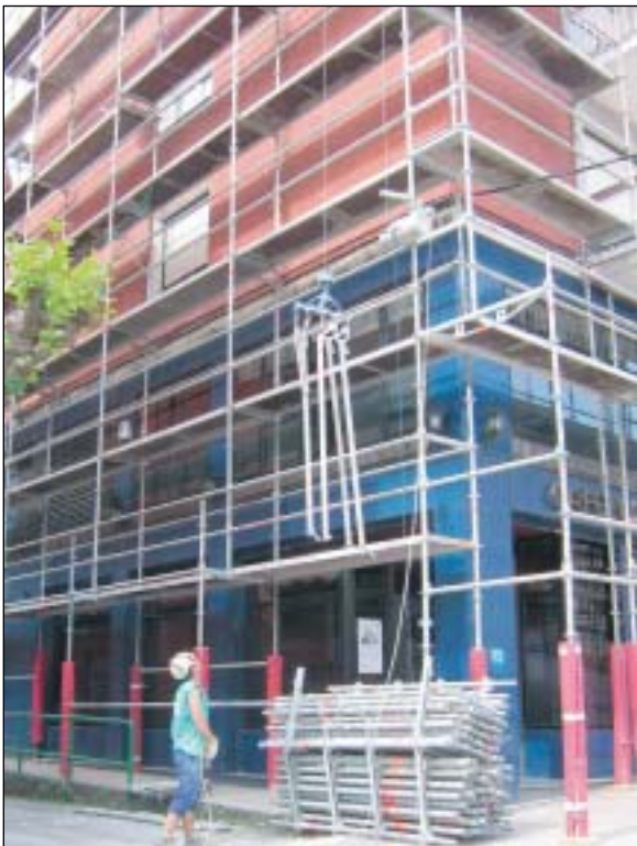
Montaje con maquinillo eléctrico
