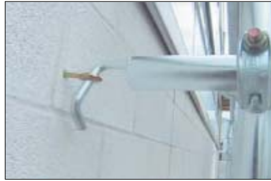
Anclaje a fachada
