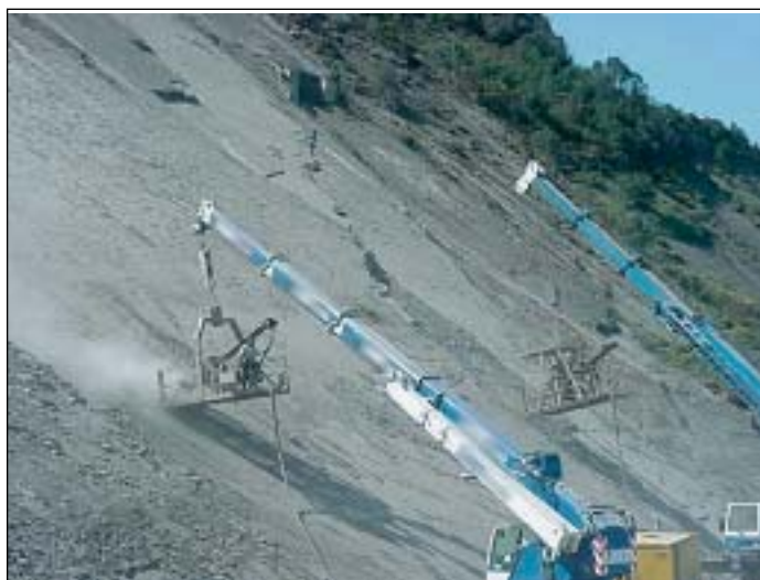
Plataforma con maquinaria, sustentada por grúa
