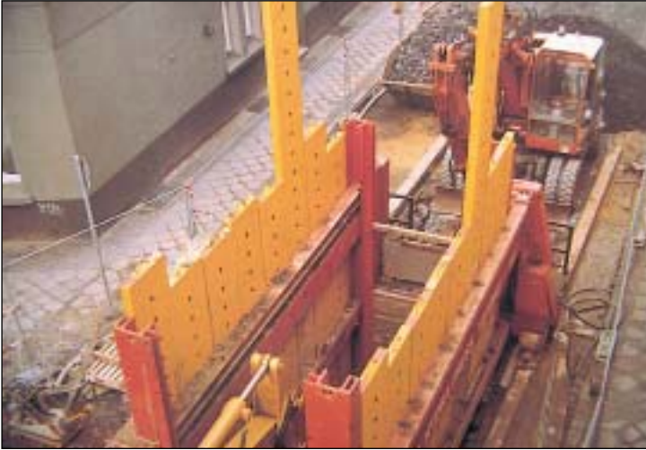
Entibación por presión hidráulica
