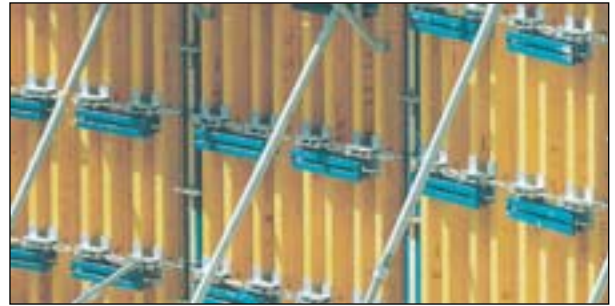
Encofrados con I
