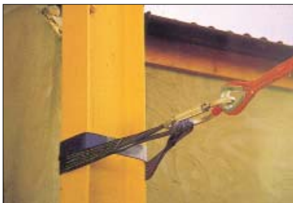
Anclaje con eslinga
