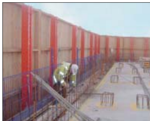
Paneles protectores trepantes (exterior e interior). Barandillas en plantas inferiores
