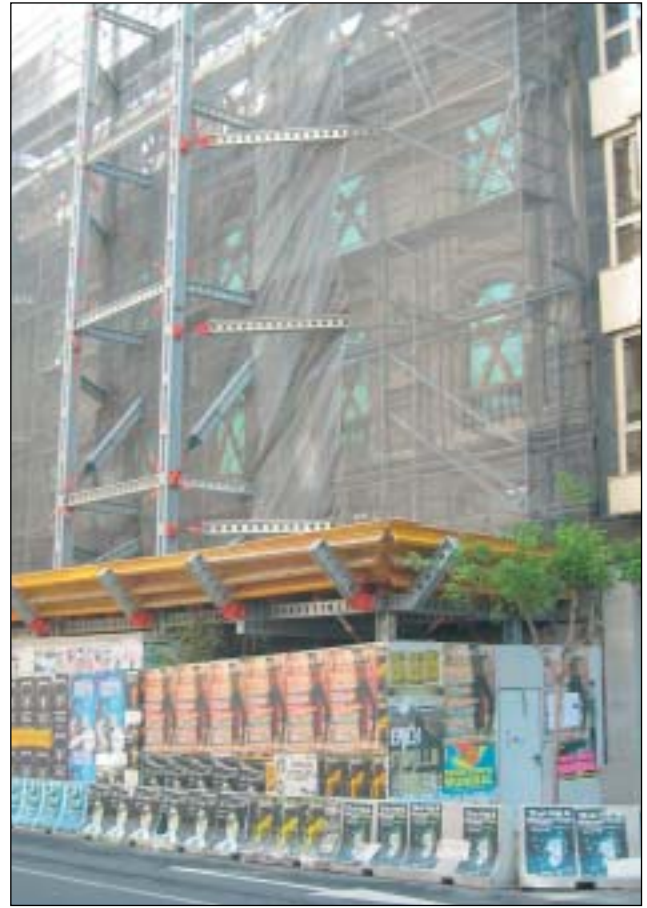
Apeo de fachada
