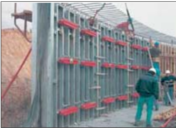
Encofrados circulares
