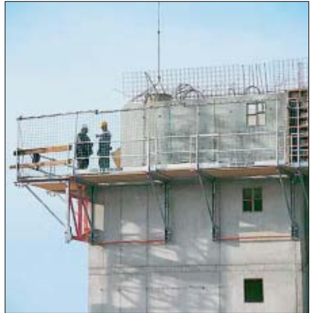
Encofrados trepantes
