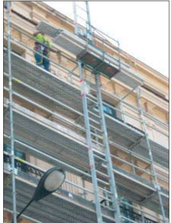
Montaje de andamio con montacargas
