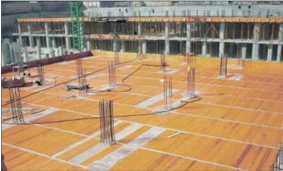
Encofrado continuo
