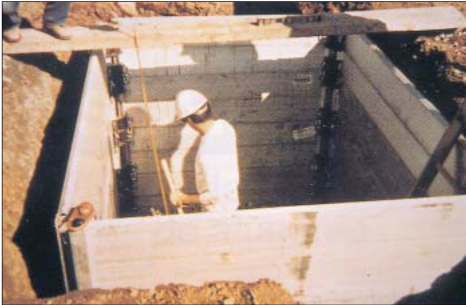
Utilización en pozos
