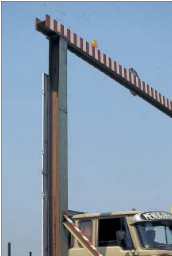
Pórtico de balizamiento
