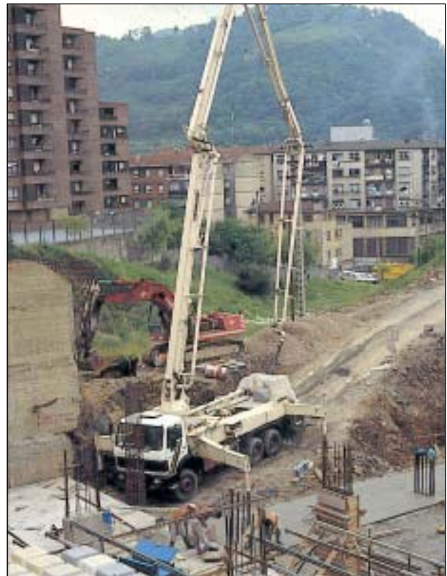
Bomba de hormigonado
