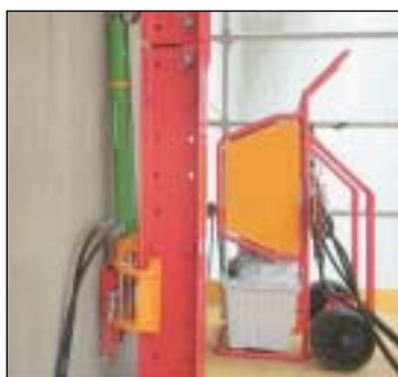
Sistema autotrepante
