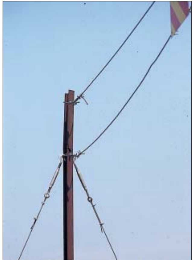
Pórtico de balizamiento
