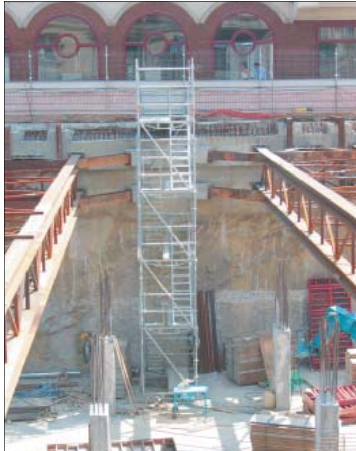
Apuntalamiento provisional y acceso
