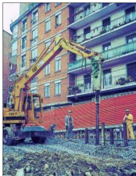
Hincado de carriles
