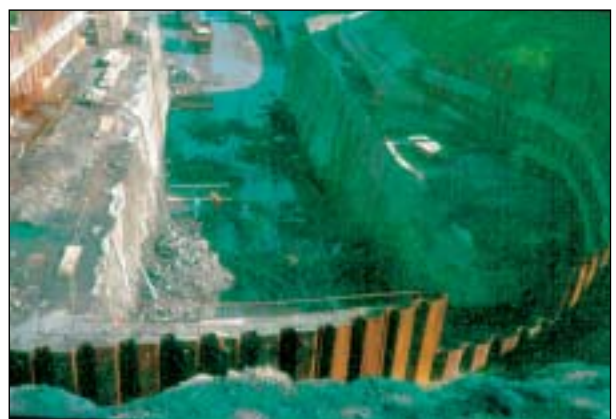
Contencion con tablestacas
