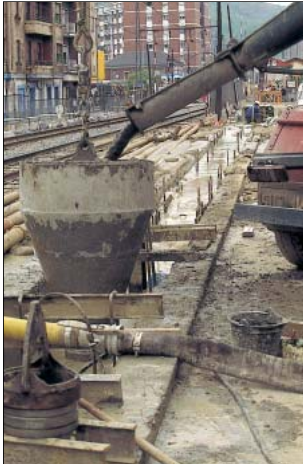
Muros-guía con canal de recogida para el lodo y tubo tremie
