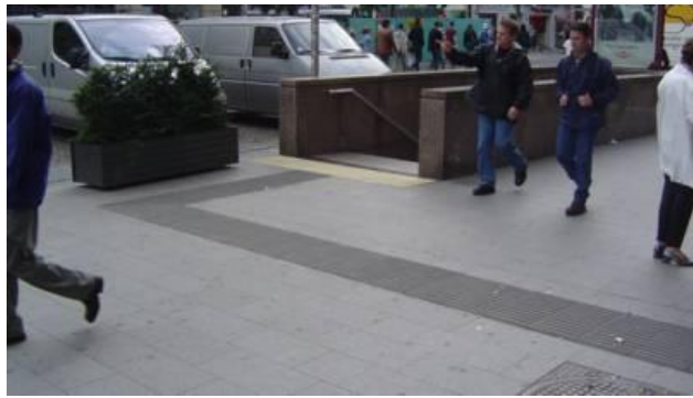
Italie, Système ITER Tactus, entrée métro
