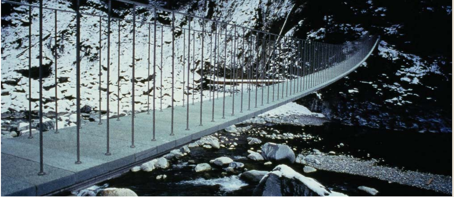
Passerelle Pünt da Suransuns
