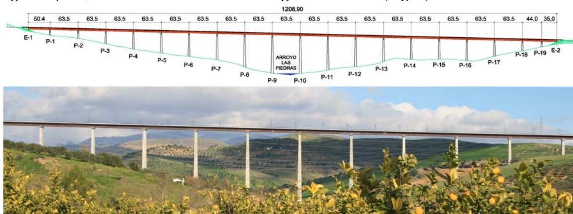
**Fig. 1:** Elevation view of “Arroyo las Piedras” viaduct.
