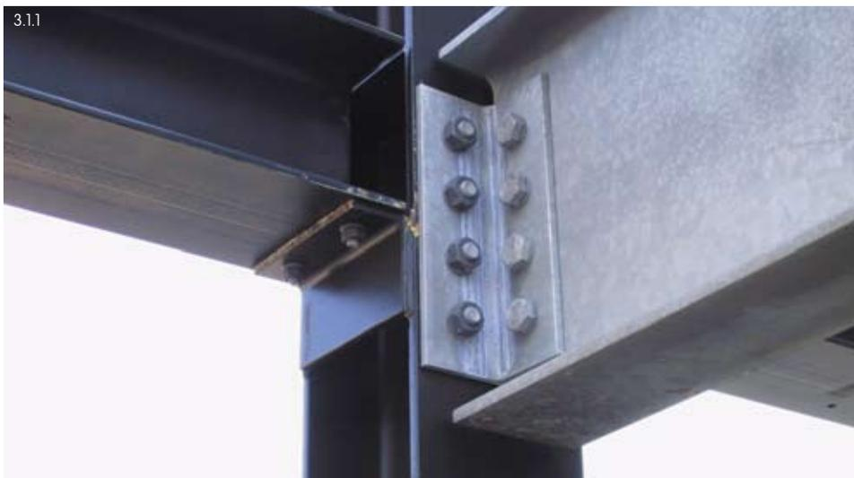
La estructura principal se compone de pilares verticales y de vigas horizontales, unidos en general mediante tornillos (foto 3.1.1). Las fuerzas horizontales provocadas por el viento y por las fuerzas de frenado se transmiten horizontalmente por el forjado a los arriostramientos verticales o a los muros a esfuerzo cortante (por ej. las cajas de escalera).
