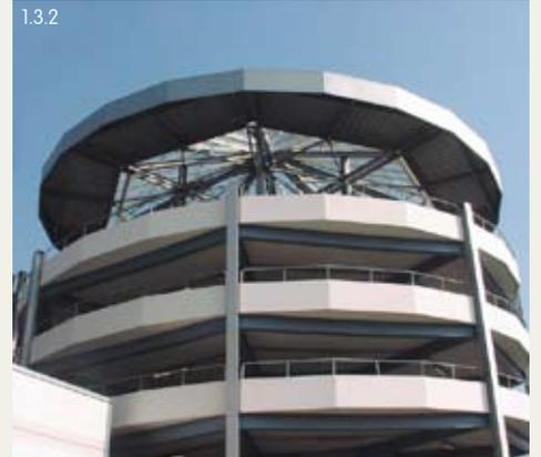
En el momento de diseñar la fachada de un aparcamiento multiplanta abierto hay que tener en cuenta que una parte importante de la superficie de las paredes exteriores debe permanecer abierta (foto 1.3.2).
