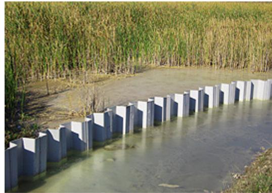
*Figura 39: Aplicaciones de tablestacas en control de contaminantes*
