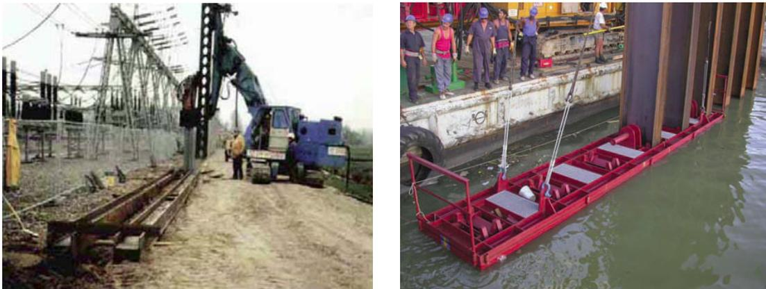
*Figura 28:* Guía inferior y poste de hincada (izquierda) y plantilla de pilotes guía (derecha)
