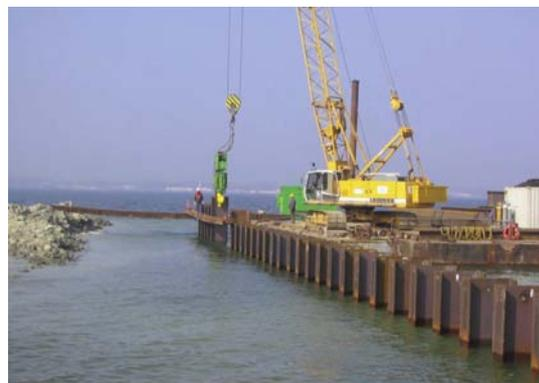
*Figura 36:* Aplicaciones de tablestacas en puertos
