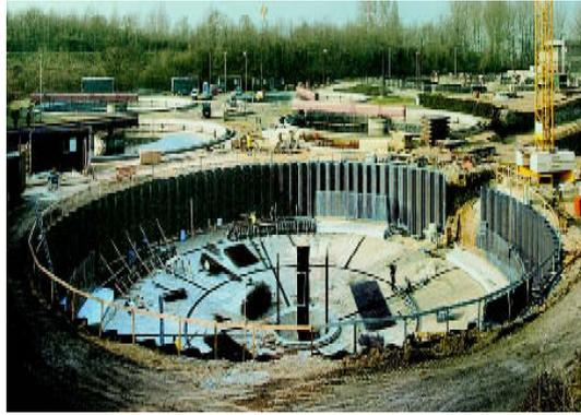
*Figura 40:* Aplicaciones de tablestacas en tratamiento de aguas
