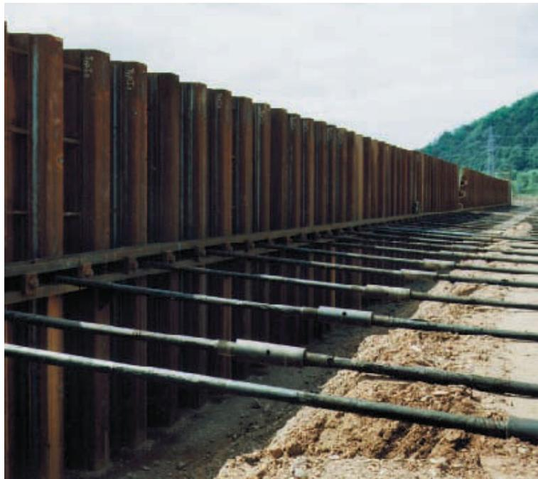
*Figura 13. Detalle de uniones de barras de anclaje*
