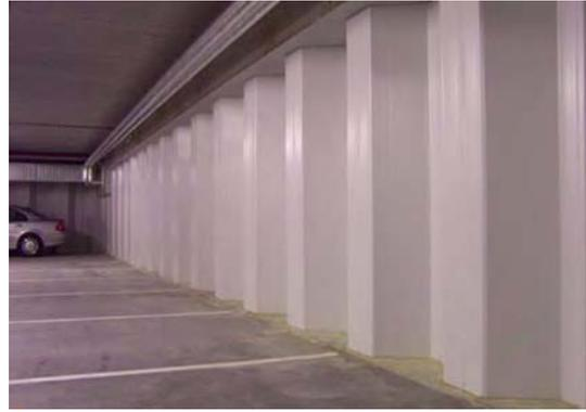
*Figura 41:* Aplicaciones de tablestacas en excavaciones
