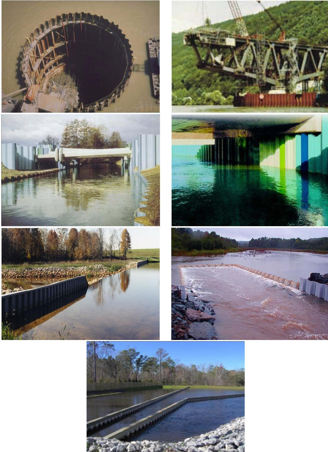
*Figura 38: Aplicaciones de tablestacas en estructuras fluviales*
