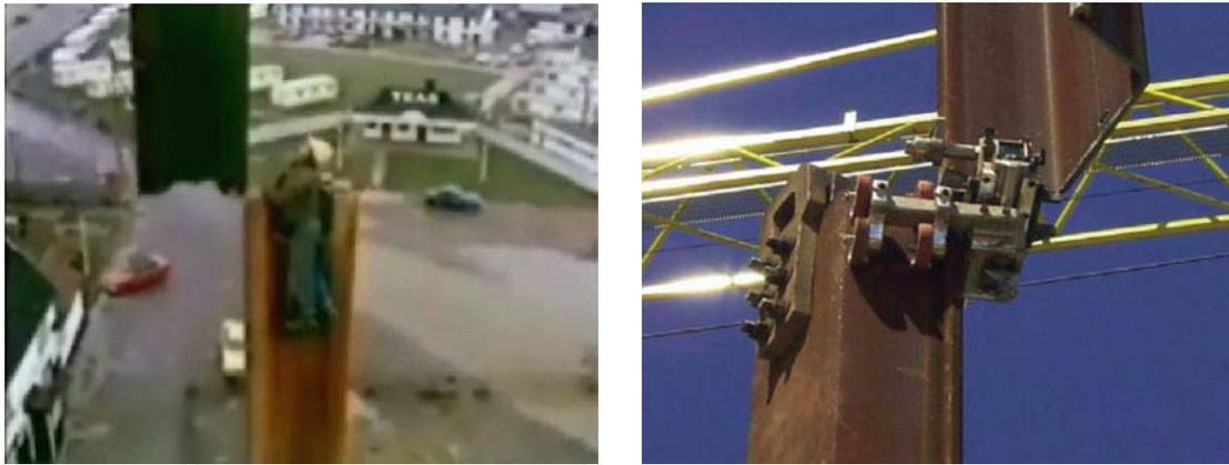
*Figura 32: Operación de engarce manual y engarce automático*
