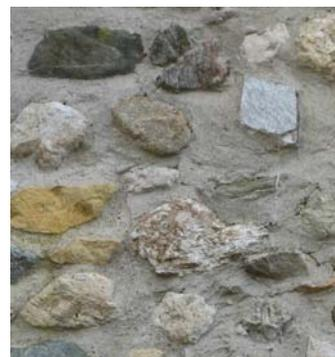
Figure 4.11: Exemple de maçonnerie cyclopéenne
