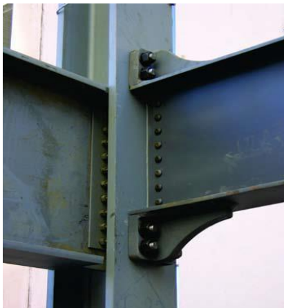
Fig. 3-21. Conexión “Kaiser” con soportes de alta resistencia apertados (a) esquema (AISC, 2010c) e imagen de una conexión real (Cordova y Hamburger, 2011).
