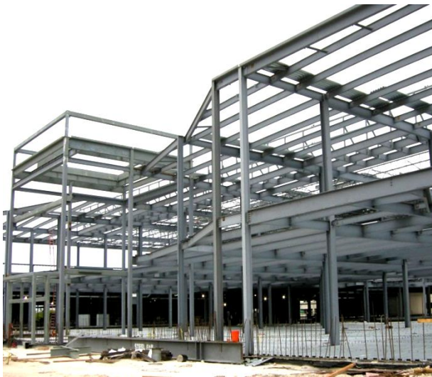
Fig. 2-17. Vista general de una estructura de pórticos no arriostrados para un edificio comercial.
