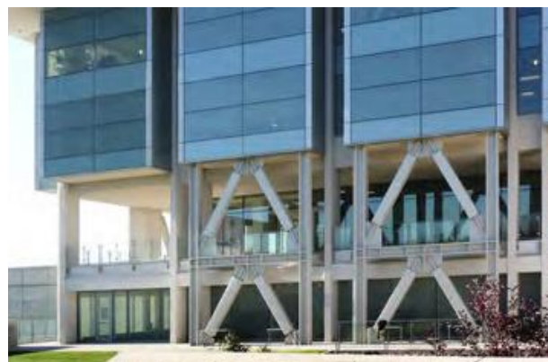
Fig. 6-13. Aplicación de riostras de pandeo restringido para la rehabilitación del edificio de la Biblioteca Marriott de la Universidad de Utah.
