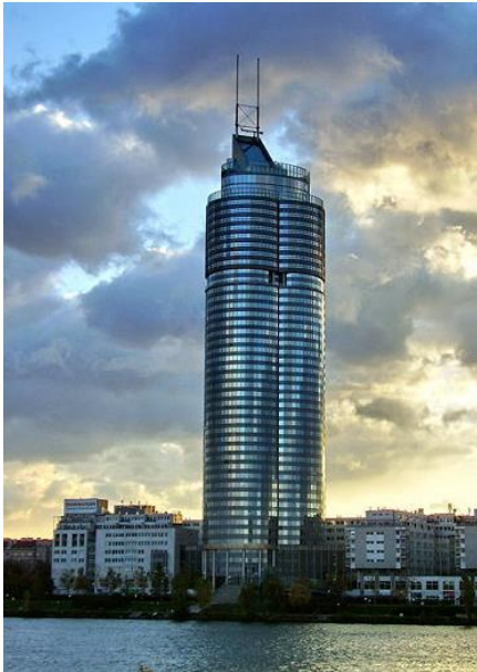
Fig. 2-37. Imagen del edificio Millennium Tower, en Viena, Austria.
