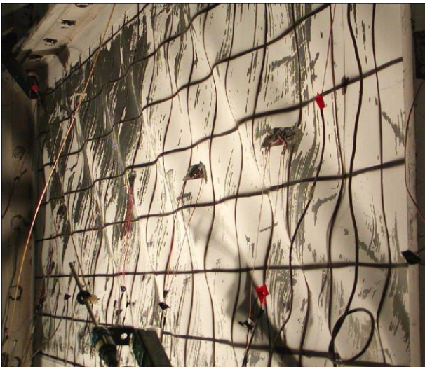
Fig. 7-11. Vista de la placa de acero, con clara evidencia de fluencia y pandeo, en ensayos realizados por Berman y Bruneau (2003).
