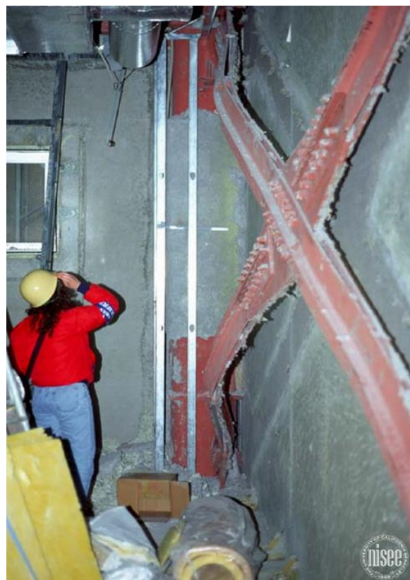
Fig. 1-5. Pandeo de una riostra, terremoto de Hyogo-ken Nanbu, Japón (Cortesía de National Information
