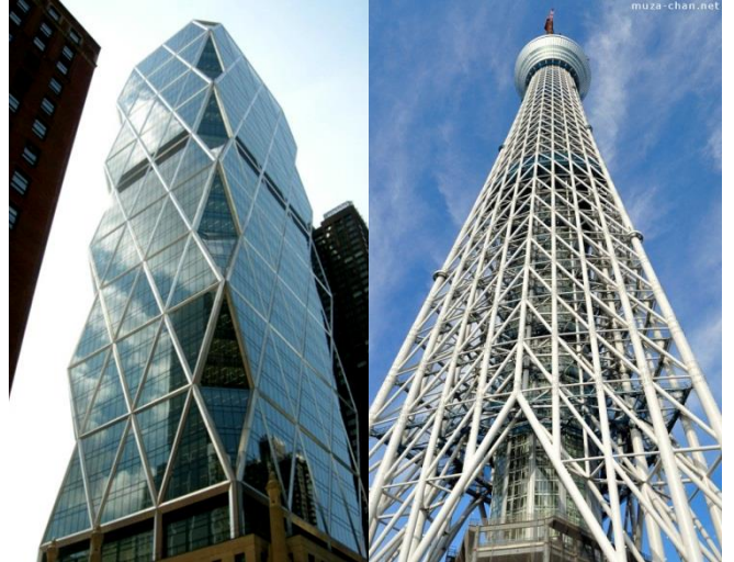
Fig. 2-22. Edificio "Hearst Tower", en New York y Tokyo Sky Tree.
