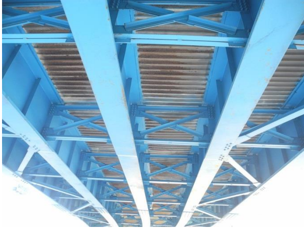
Fig. 2-50. Vista inferior de un puente carretero con arriostramientos torsionales.
