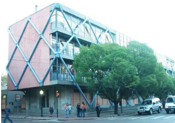
Fig. 4-33. Edificio escolar en la ciudad de Mendoza, Argentina, con estructura de hormigón armado, rehabilitado con el agregado de riostras de acero.
