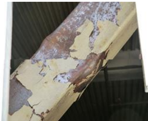
Fig. 1-19. Pandeo local en el extremo de una riostra de acero (Midorikawa et al., 2012).
