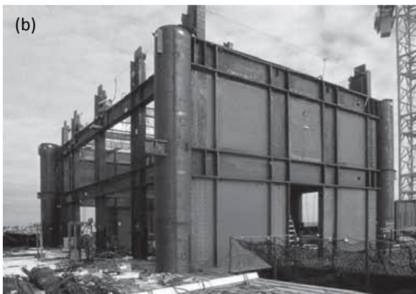
Fig. 7-1. Edificio U.S. Federal Courthouse, Seattle, que incorpora muros de corte con placas de acero, (a) vista general y (b) construcción de los muros (Sabelli y Bruneau, 2006).
