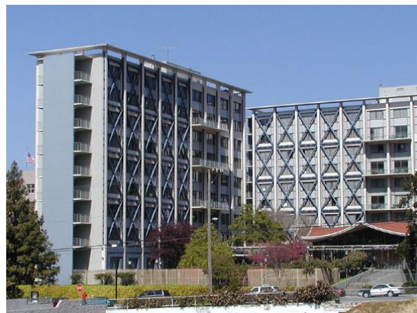
Fig. 4-34. Edificio Residence Hall, Berkely, Estados Unidos, rehabilitado con riostras de acero.
