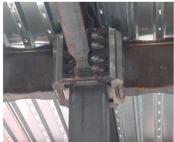
Fig. 3-22. Conexión “ConXtech ConXL” (AISC, 2010c).
