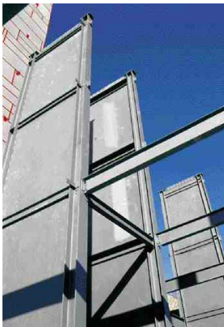
Fig. 2-35. Ejemplo de muros de corte con placas de acero en un edificio en construcción.
