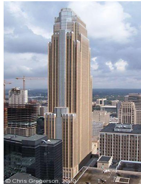
Fig. 2-38. Edificio Norwest Center (ahora Wells Fargo Center), Minneapolis, con super-columnas compuestas.
