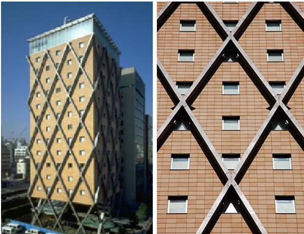
Fig. 6-5. Aplicación de riostras de pandeo restringido en un edificio en Japón, Sankyo New Tokyo Headquarter ( http://www.unbondedbrace.com/ ).
