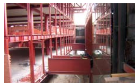
Pasarelas de conexión entre crujía perimetral y cubos
