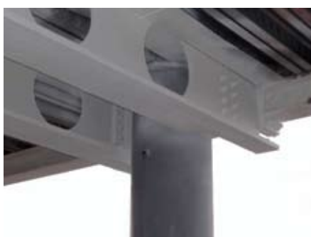
Unión en pilar tubular
