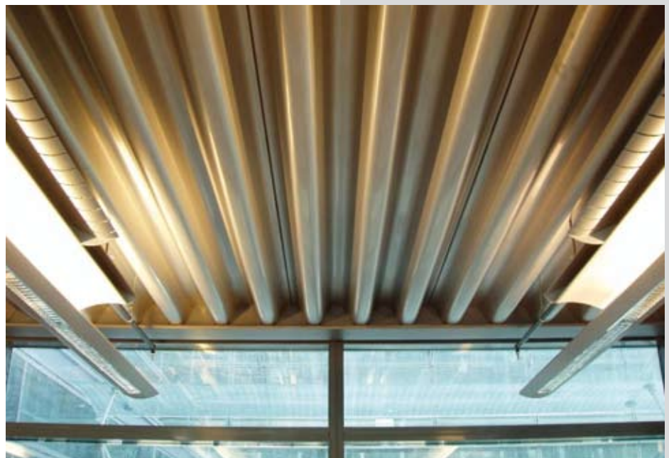
Figura 2.4 Chapa de acero inoxidable utilizada en la Cámara de Comercio de Luxemburgo Vasconi Arquitectos
