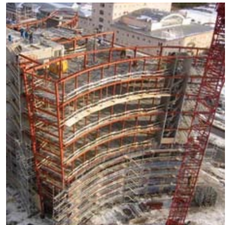
Centro Mjärdevi bajo construcción. Estructura principal y fachada de acero ligero. Foto cortesía de PPTH
