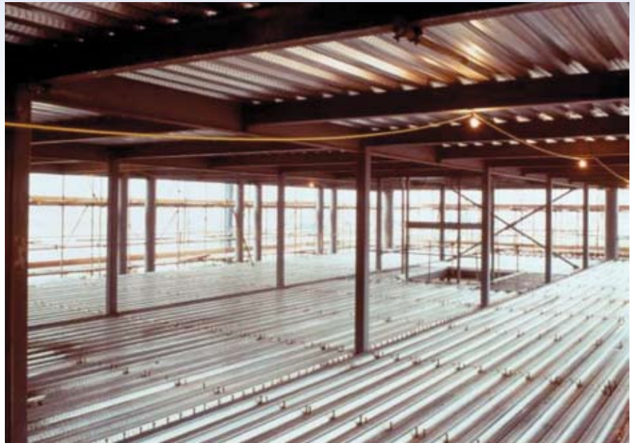
Figura 2.1 Los forjados mixtos proporcionan una plataforma de trabajo segura durante su construcción
