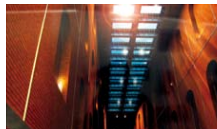
Vista inferior de la piscina a través del forjado acristalado
