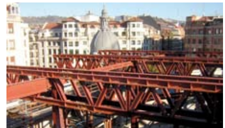
(Encima) Voladizo perimetral de las vigas en celosía del atrio
