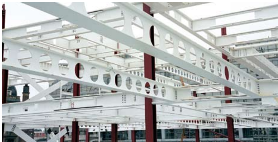
Figura 3.11 Vigas laminadas en caliente con la protección a fuego aplicada en taller
