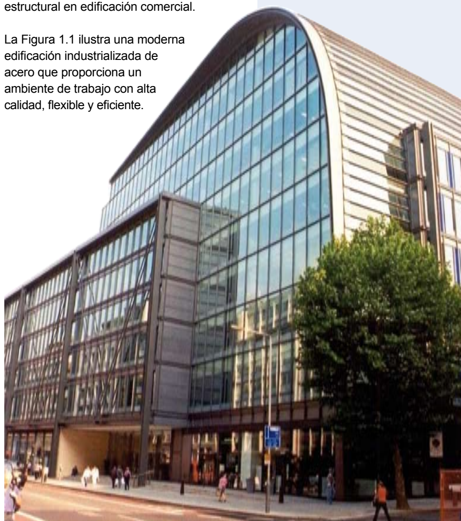
Figura 1.1 Edificación moderna de estructura de acero, Londres
