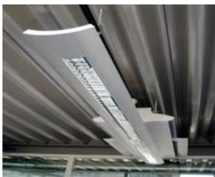
Chapa colaborante perfilada de acero inoxidable y unidades de alumbrado y ventilación
