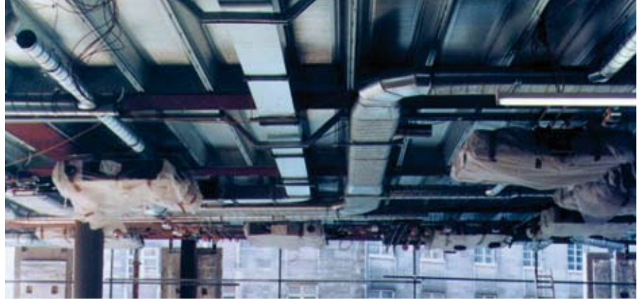
Figura 4.8 Distribución de servicios bajo el forjado Slimdek
