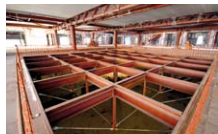
Estructura de acero para forjado acristalado
