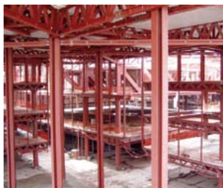
Estructura principal para el atrio y los cubos interiores
