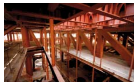
Estructura principal que soporta la piscina
