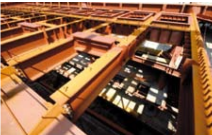
Vigas de forjado para la estructura principal de piscina
