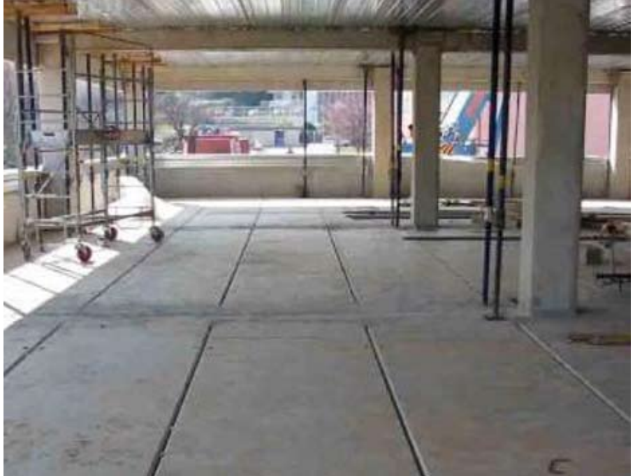
Figura 4.3 Vista de placa Cofradal antes de ser hormigonada
