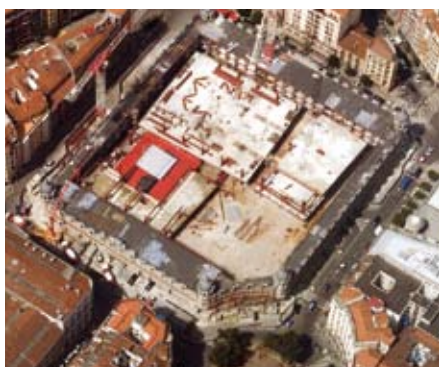
Vista aérea de la obra en construcción (Mayo 2006)
