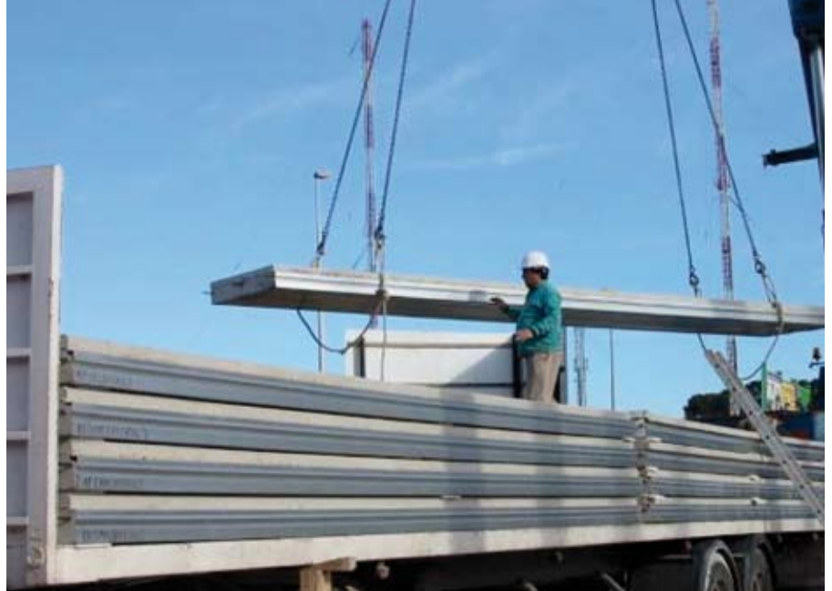
Figura 4.2 Entrega de Cofradal 200 en obra
