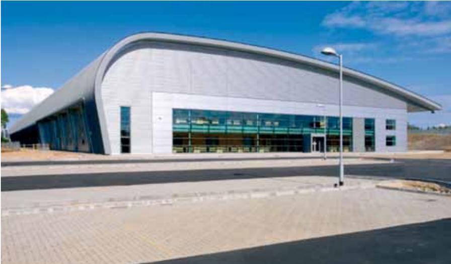
Figura 5.19 Pórticos curvos de acero para edificación moderna industrial, Reino Unido
