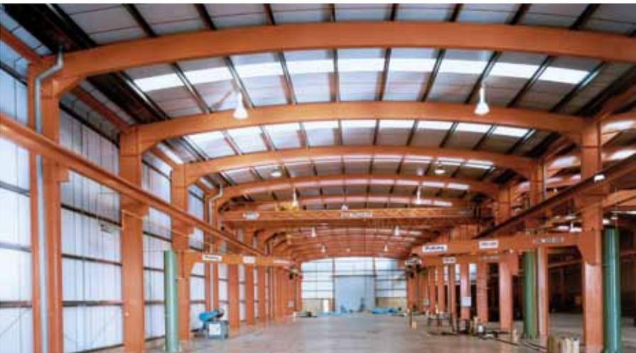
Figura 2.8 Vigas curvadas utilizadas en una estructura apuntalada
