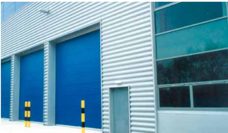
Figura 4.9 Cerramiento de chapa con nervios horizontales
