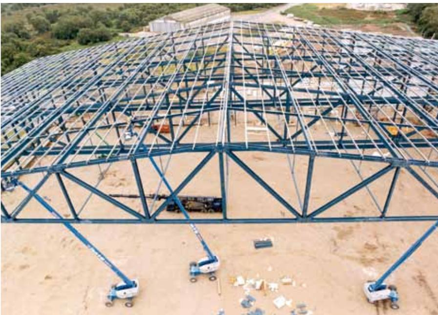
Figura 2.12 (Izquierda) Celosías usando perfiles tubulares
