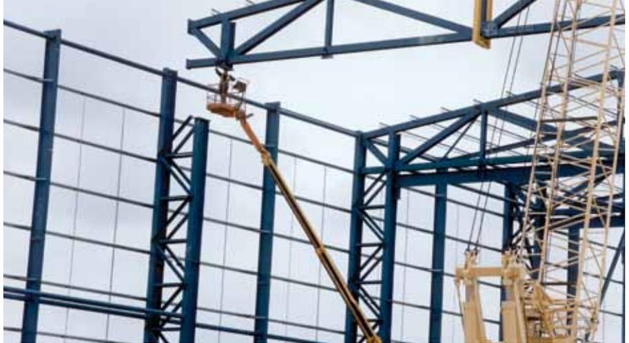
Figura 2.13 Estructura de celosía usando pilares en celosía
