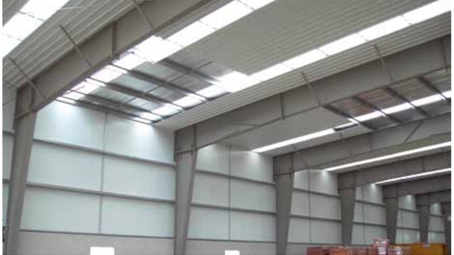
Figura 5.10 Estructura interior de una nave industrial con pilares de sección variable
