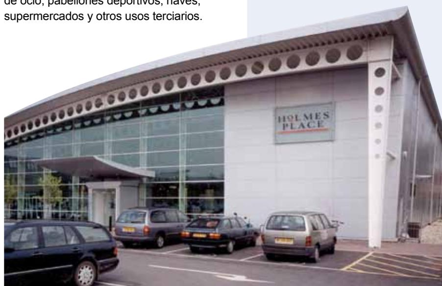
*Figura 1.1 Centro de ocio realizado con estructura aporticada de acero*
