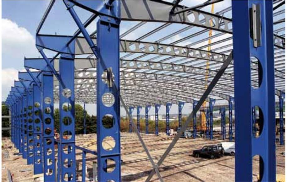
Figura 2.10 Proceso de montaje para una estructura aporticada moderna Barrett Steel Buildings Ltd
