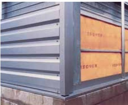
Figura 5.5 Paneles de chapa de acero unidos a bandejas
