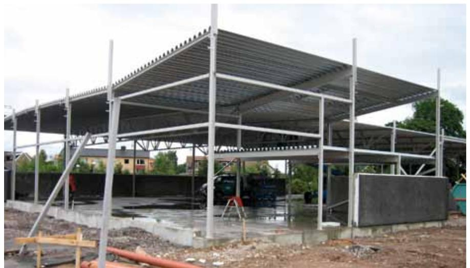
(Derecha) Cubierta y forjados intermedios en obra durante su colocación.
