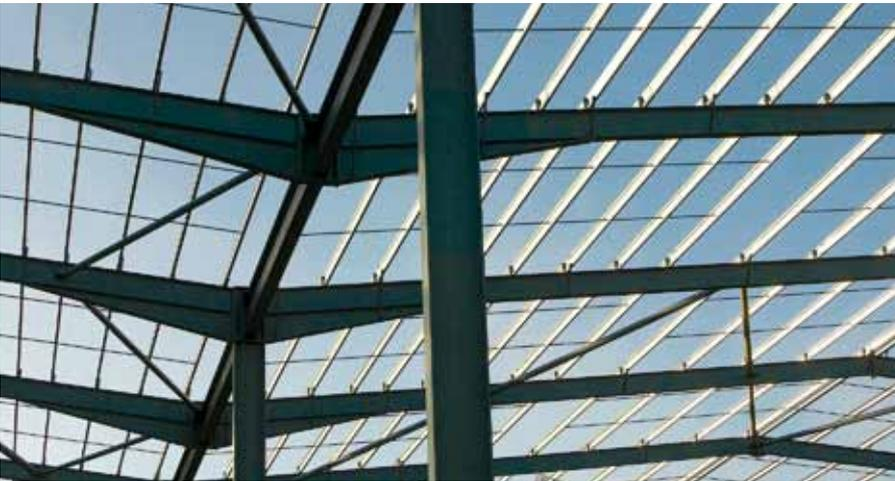
Figura 2.7 Pórtico de dos vanos con arriostramiento en cubierta Kingspan Ltd
