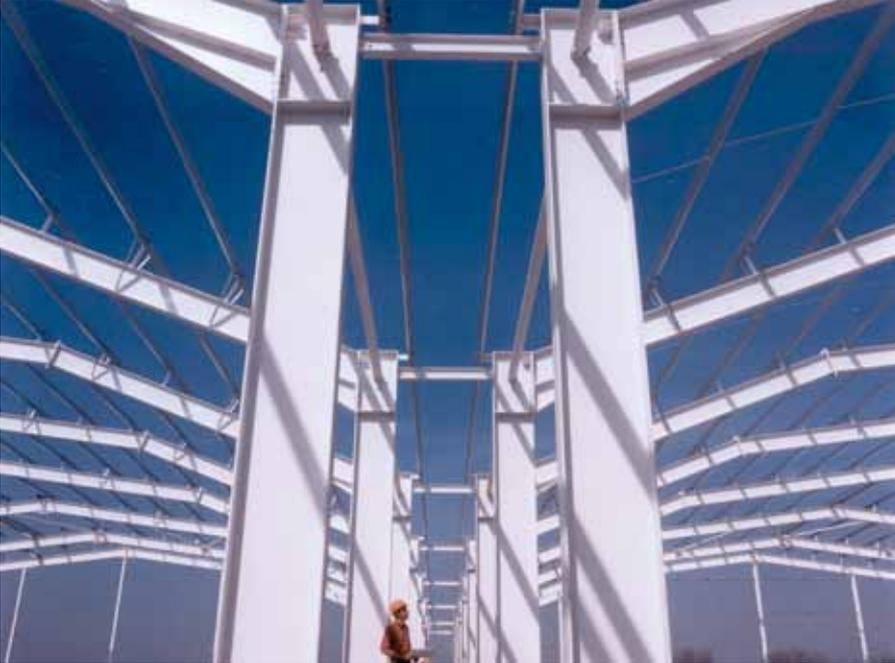
Figura 2.6 Estructura apuntalada de doble vano
