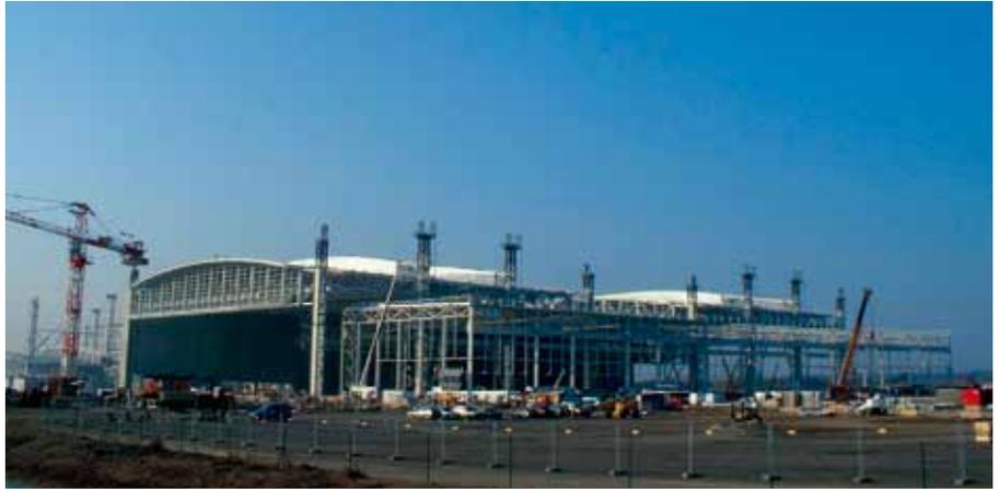
Este edificio industrial tiene una superficie en planta de 200.000 m<sup>2</sup>, 45 m. de altura y unas luces de más de 115 m. El objetivo inicial de diseño comprende la obtención de un gran espacio eficaz disponible y la flexibilidad en la utilización del espacio interno.
