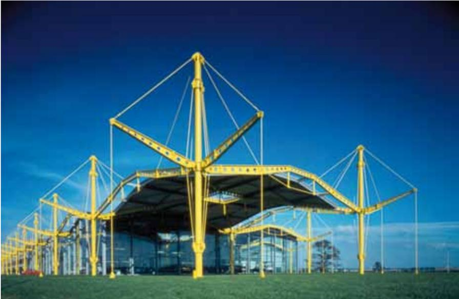
Figura 2.14 Estructura atirantada en la fábrica de Renault, Swindon, R.U., construida en los 1980's
