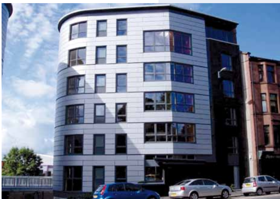
Figura 7.1 Edificación residencial en estructura de acero ligero y con cerramiento metálico en Glasgow Fuente: Peck & Reid Architects & Metsec
