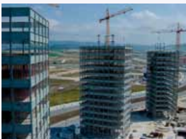
Torres bioclimáticas bajo construcción
