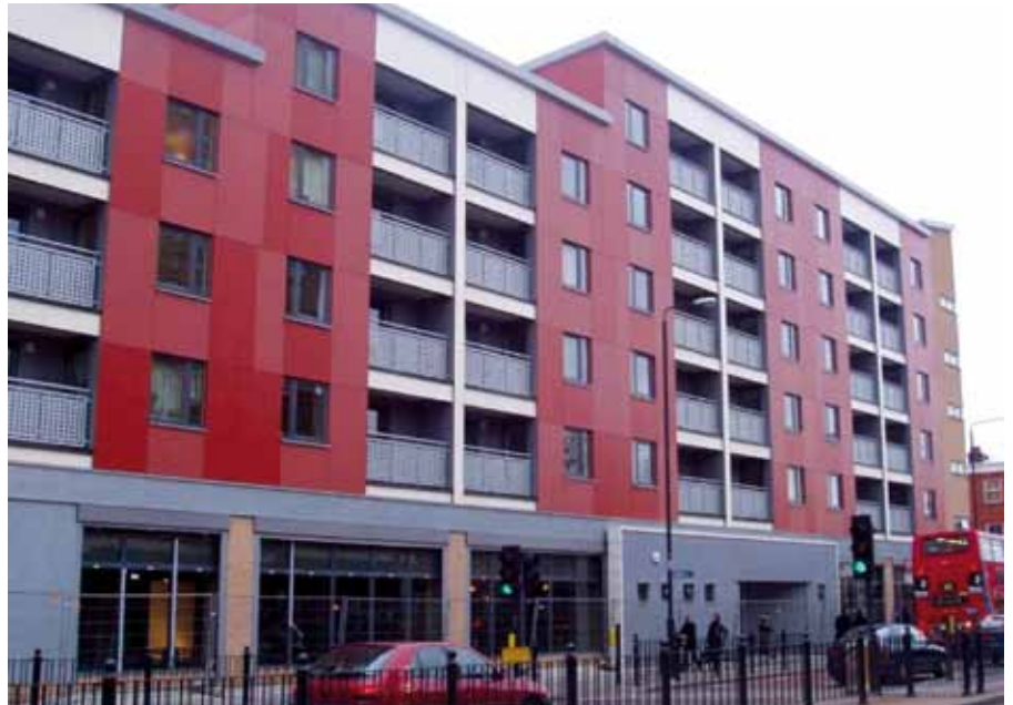
Figura 6.6 Edificación modular finalizada
