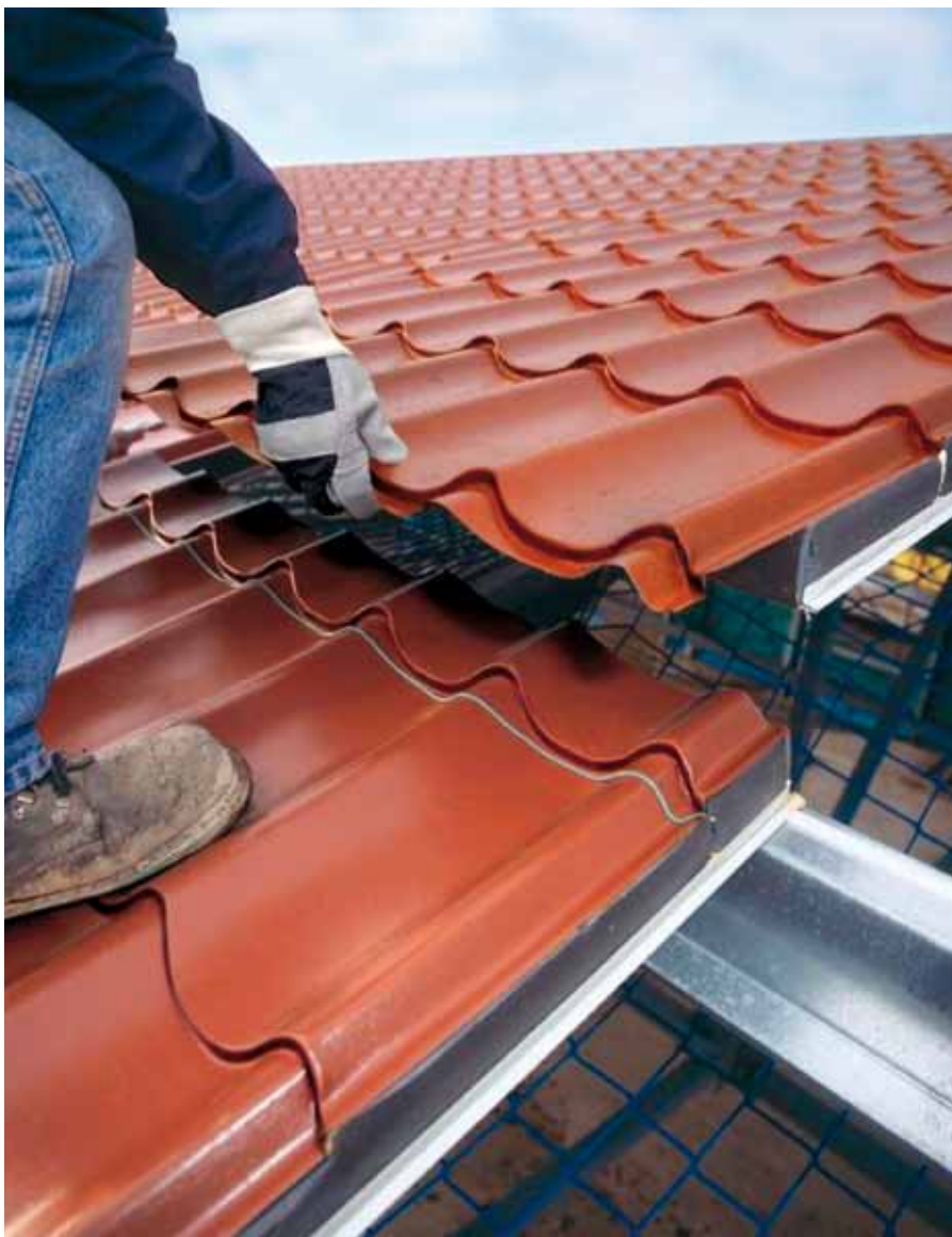
Figura 7.8 Insatación de panel mixto de cubierta con tejas Fuente: Kingspan
