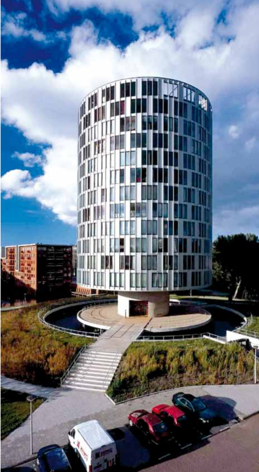
Figura 8.7 Edificio de apartamentos con estructura de acero: Schutterstoren, Amsterdam
