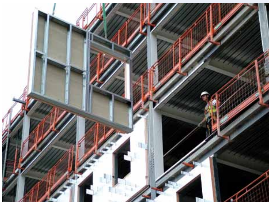
Figura 4.1 Instalación de panel de fachada no portante de acero ligero Fuente: Kingspan Architectural
