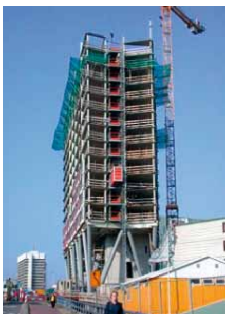
Edificio en construcción
