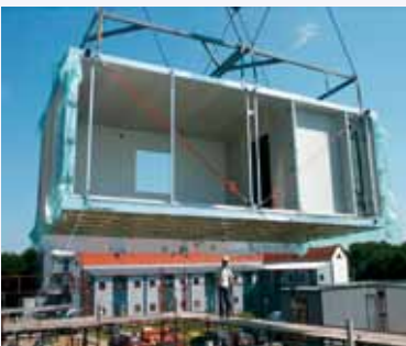
Módulo abierto OpenHouse durante su instalación con postes adicionales temporales
