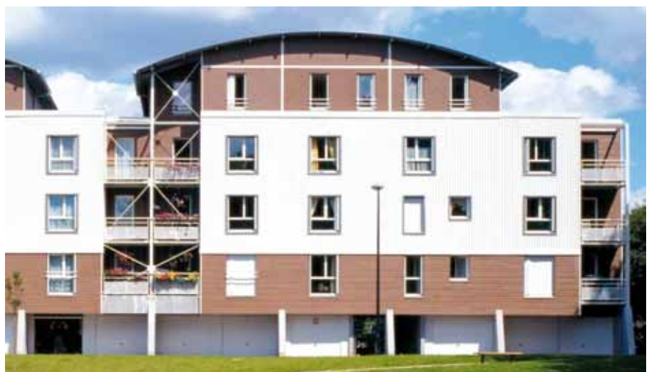
Figura 2.3 Edificio de apartamentos de acero en Evreux (Francia), con paneles de fachada de acero ligero, con cerramiento ligero y forjado de chapa. Arquitectos: Dubosc & Landowski
