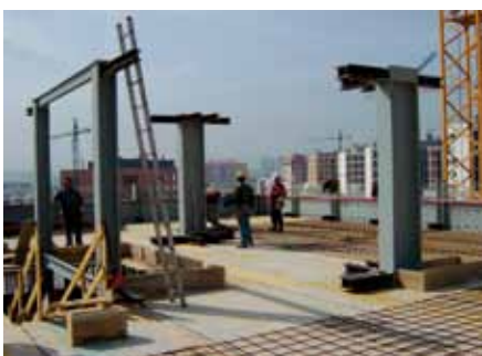
Forjado con pilares internos en las obras del edificio
