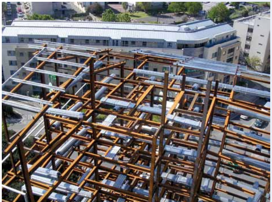
Figura 5.1 Estructura de acero con perfiles ASB y chapas de forjado de gran canto
