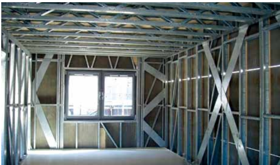
Figura 3.3 Vigas en celosía de gran luz con pantallas superiores de yeso Fuente: Metek Building Systems
