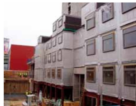
Instalación de módulos en la estructura principal inferior de acero
