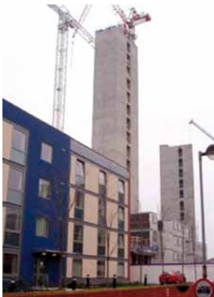
Módulos adjuntados a un núcleo de hormigón
