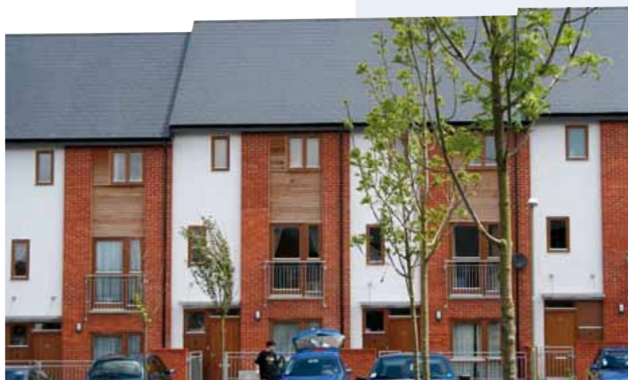
Figura 1.1 Viviendas adosadas de 3 plantas con estructura de acero ligero (Basingstoke, UK) HTA Arquitectos
