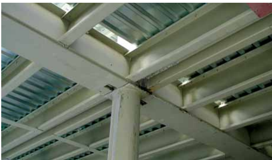
Figura 3.4 Vigas secundarias de acero ligero apoyadas en vigas principales de acero laminado en caliente Fuente: Ruukki
