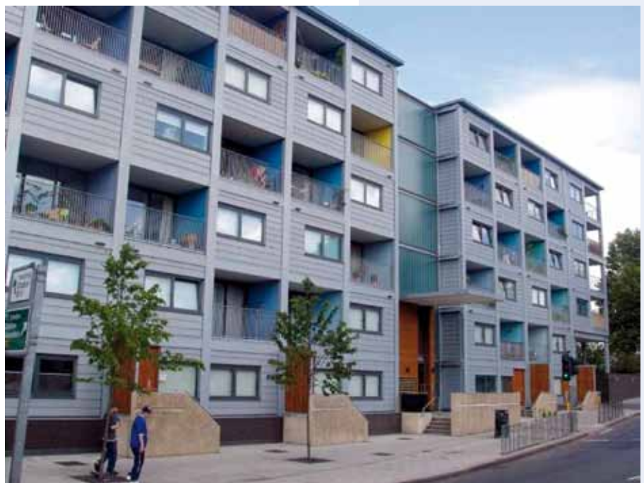
Figura 6.1 Edificación residencial modular con balcones integrados, Londres Fuente: AHMA Architects & Yorkon
