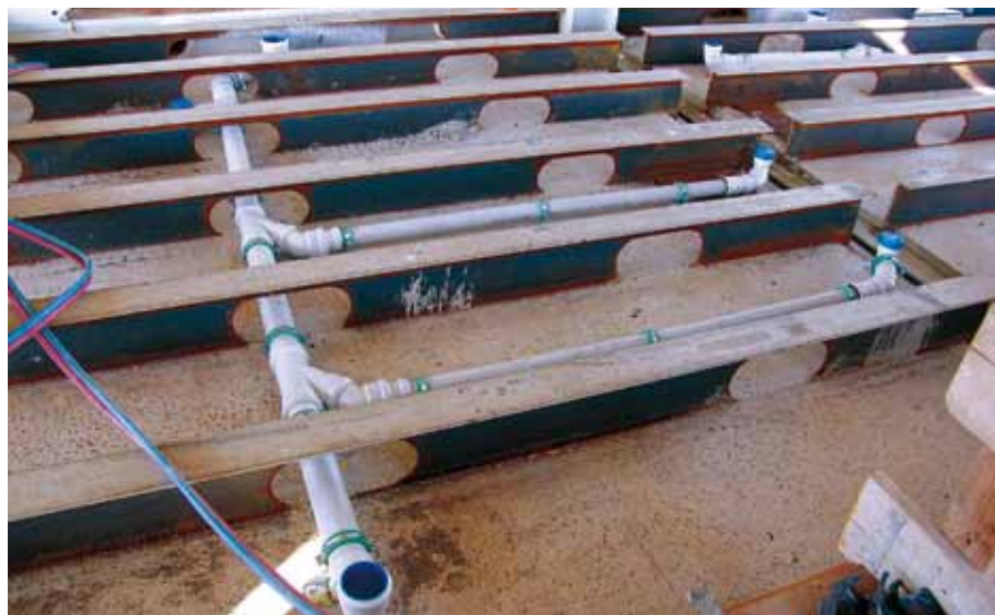
Figura 5.5 Vigas de acero invertidas (Slimline)
