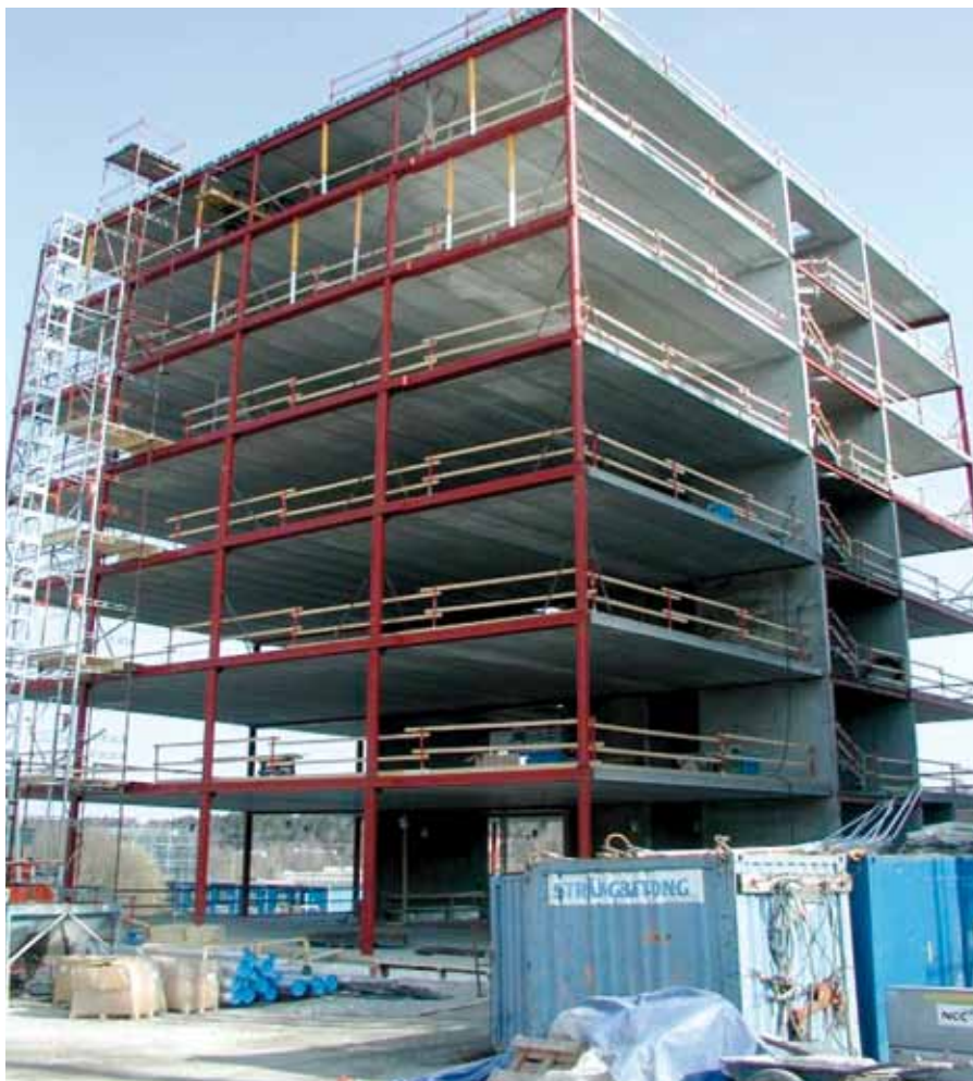
Figura 8.15 Ejemplo de una edificación residencial de 7 plantas utilizando el sistema de forjado integrado, Suecia
