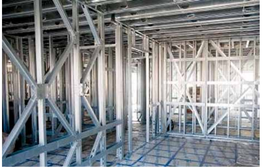
Figura 4.2 Construcción para viviendas de paneles de acero ligero arriostrados Fuente: Fusion Building Systems
