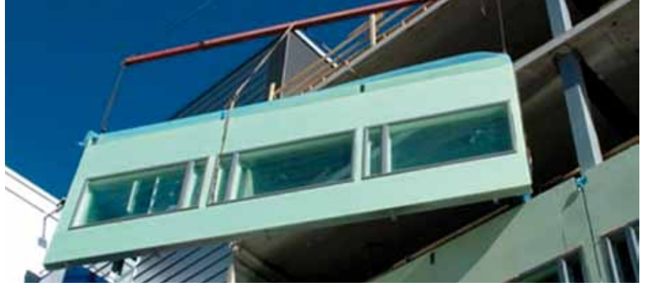
Figura 4.5 Panel prefabricado de fachada con cerramiento y ventanas Fuente: Ruukki
