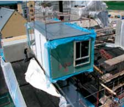
Instalación de un módulo con fachada integrada
