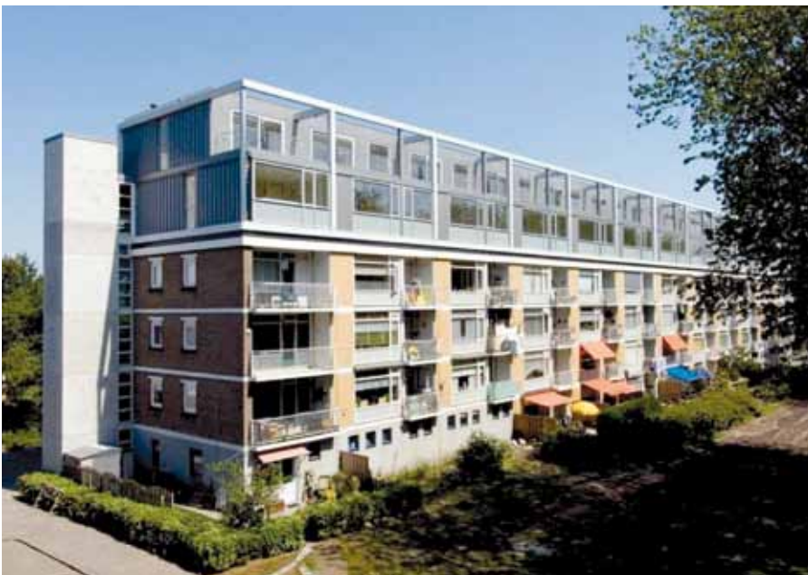
Figura 8.5 Ampliación sobre cubierta para la realización de varios duplex: Het Lage Land, Rotterdam
