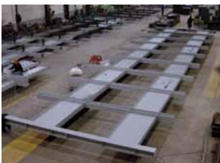
Fabricación fuera de obra de los paneles estructurales de fachada
