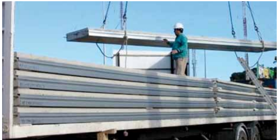
Figura 8.13 Unidades de forjado Cofradal – Sección transversal típica y paneles durante la instalación
