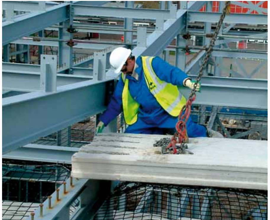
Figura 5.2 Instalación de prelosas de hormigón sobre vigas de acero
