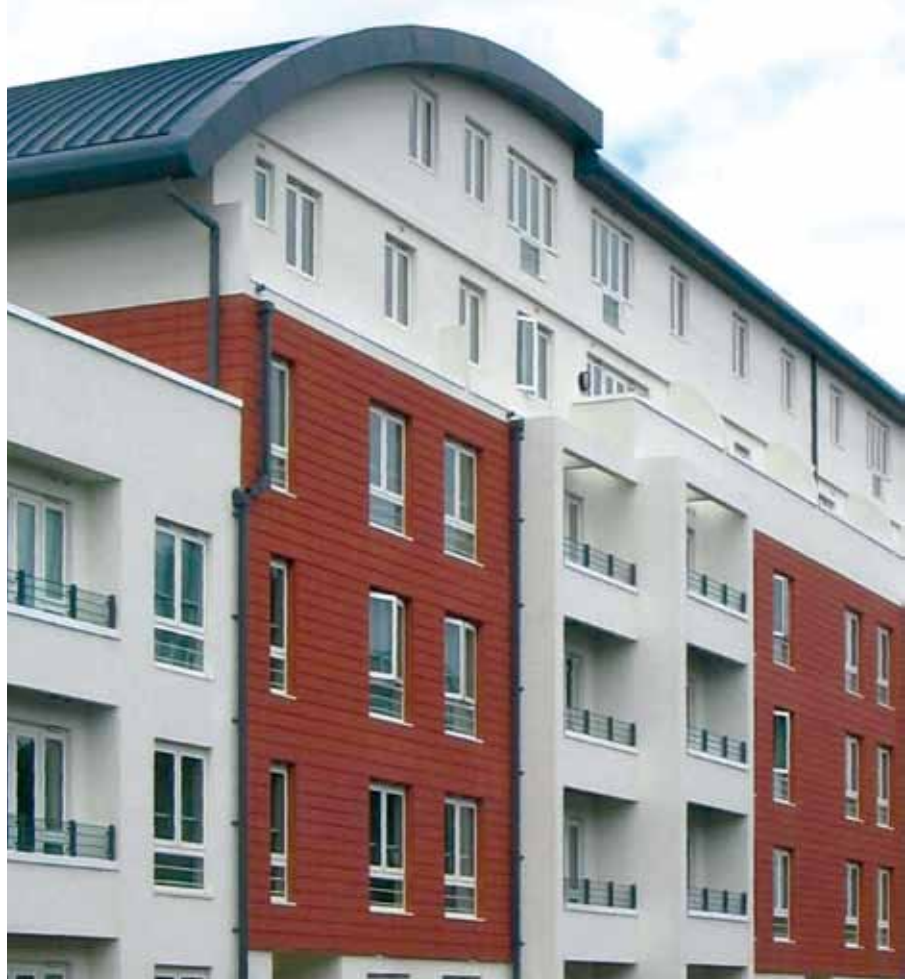
Figura 7.2 Paneles de fachada con mortero monocapa hidrófugo combinados con ladrillos cerámicos
