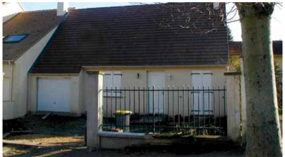
Figura 8.14 Maison Phénix durante su construcción, mostrando los detalles de la cubierta para una casa de planta única
