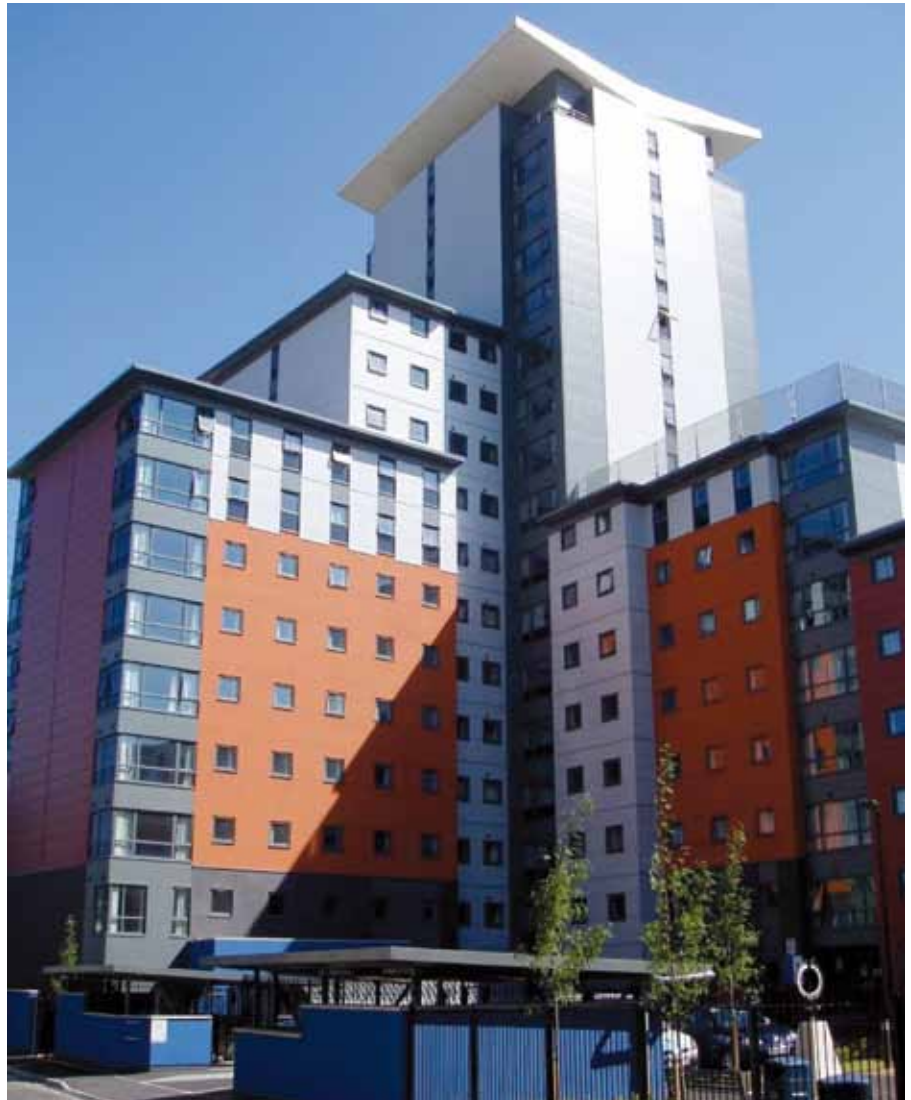
Figura 2.2 Residencia de estudiantes de 16 plantas con estructura principal de acero y paneles de fachada no portantes de acero ligero (Southampton, Reino Unido)
