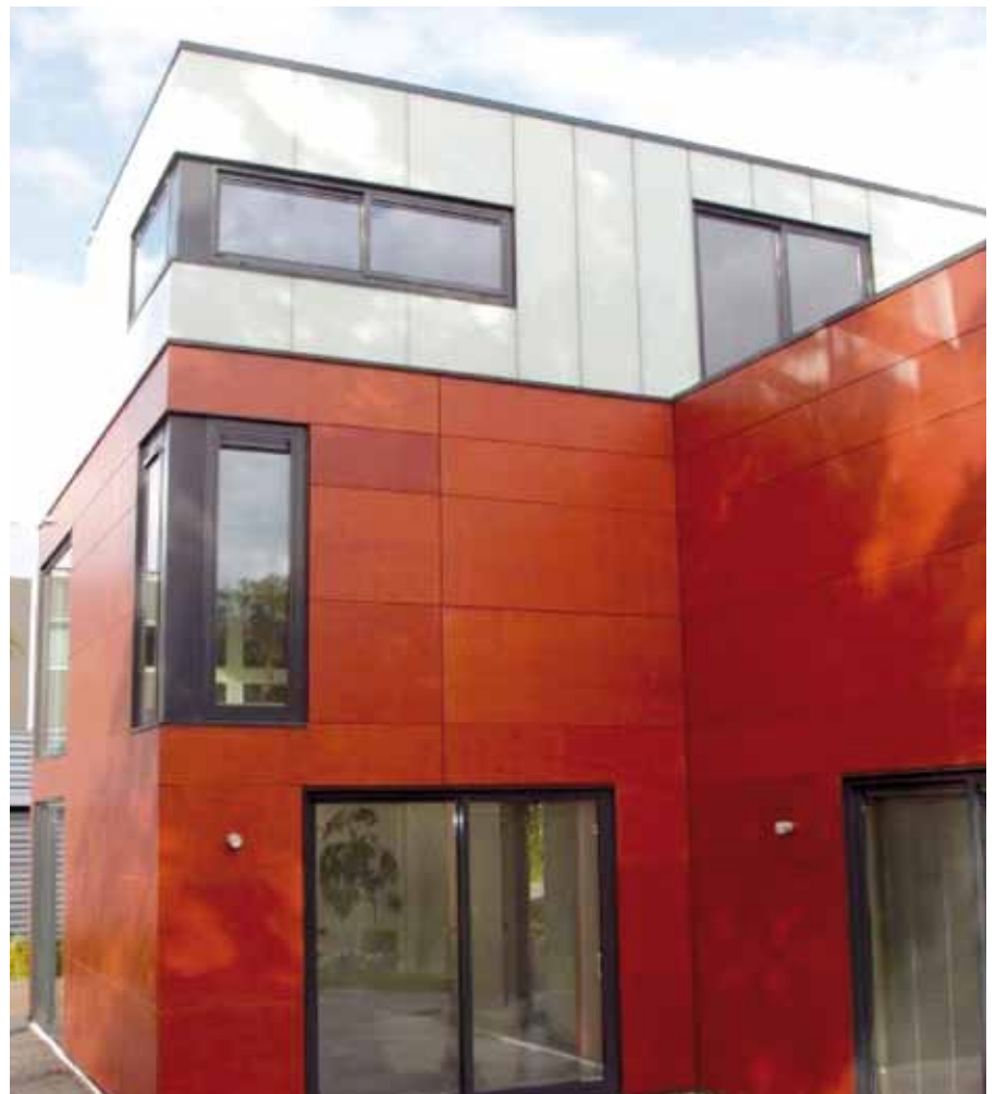
Figura 8.9 (Arriba y derecha) Smart house, Rotterdam, con perfiles tubulares de sección cuadrada y rectangular con paneles de fachada no portantes de acero ligero y vigas en forjado
