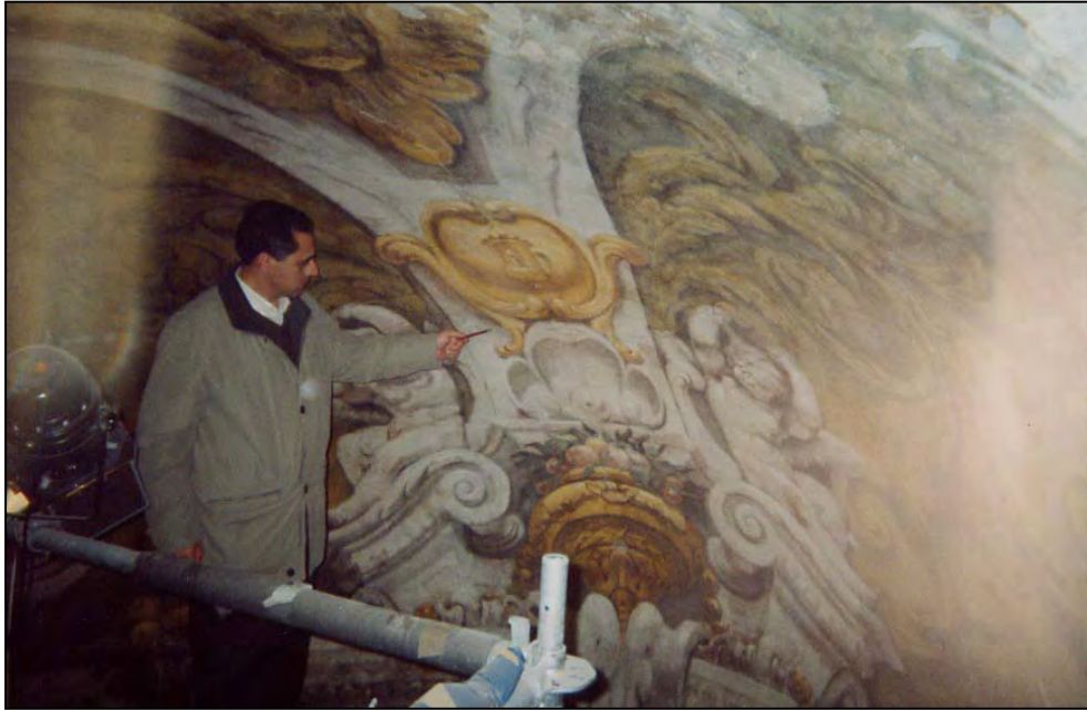
Figura 6.3.8 Grieta horizontal localizada en riñones del eje mayor en la cúpula de la Epístola
