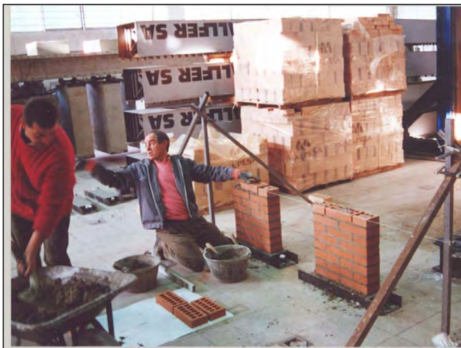
Construcción de unos muretes de la serie CE
