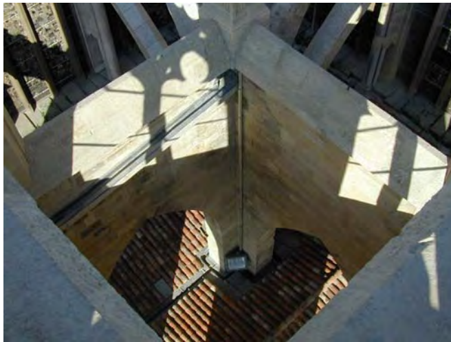
Figura 5.4 Silla de la Reina, catedral de León. Muros de tres hojas 200-400-200 mm. La albardilla superior salvaguarda la durabilidad de los muros frente a la infiltración de agua. [102].
