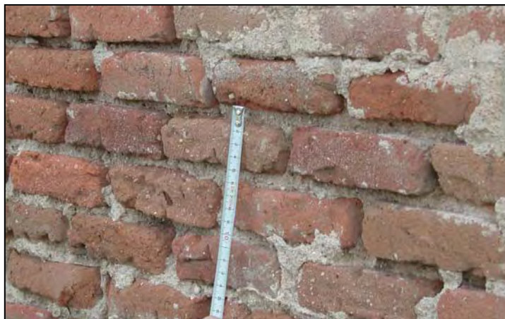
Figura 5.72 Medida del espesor de tendeles en una pila del puente ferroviario sobre el río Adaja, Línea Madrid-Hendaya [122]
