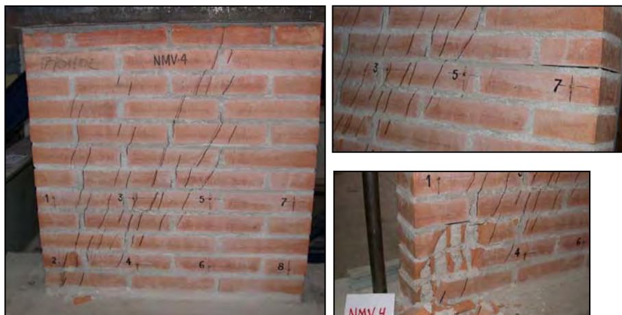
Figura 4.44 Fisuración en rotura y detalles del ensayo NMV 4. Modo de fallo III, sección crítica inferior
