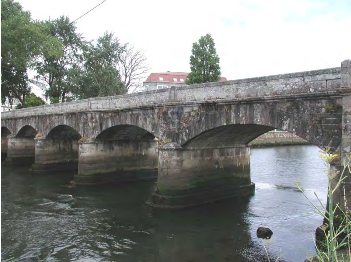
Figura 6.2.1 Alzado parcial del puente de Ponteceso desde aguas abajo
