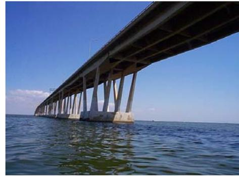
Debido a la insuficiente resistencia a tracción del hormigón en masa, el desarrollo del hormigón armado representó la aparición de las primeras aplicaciones en la construcción de puentes de luces relativamente pequeñas. Con el desarrollo del hormigón armado y, posteriormente, del hormigón pretensado, las luces fueron aumentando y se desarrollaron los nuevos sistemas constructivos (puentes por voladizos sucesivos, puentes empujados, puentes prefabricados de vigas).
