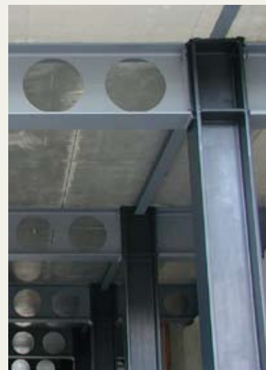
Figura 17 Unión viga con pilar
