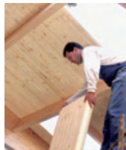
Montaje de paneles sandwich en cubierta
