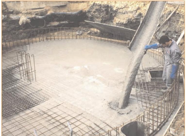
Además resultaba, en cuanto a propiedades del hormigón endurecido, semejante a los hormigones habituales compactados mediante vibrado.
