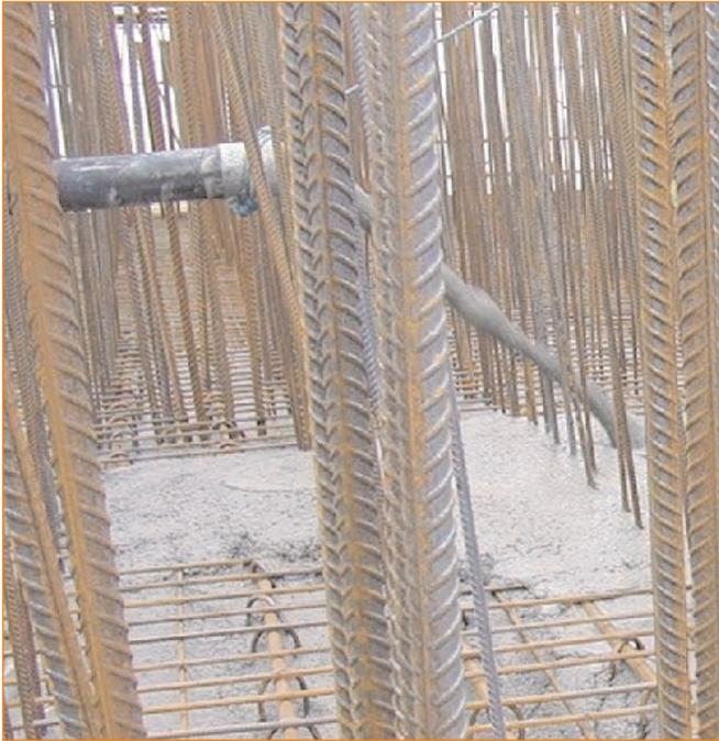
El acabado superficial que produce es muy difícil de igualar con hormigones de colocación convencional, ya que se elimina la heterogeneidad que produce el vibrado.
