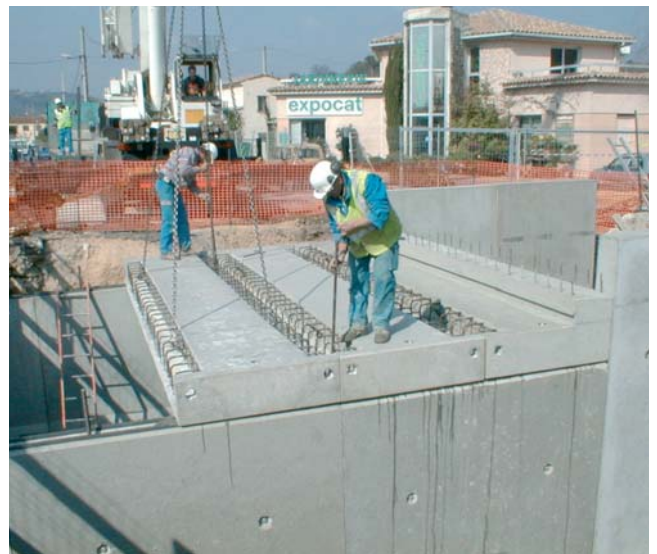
Pose et réglage de dalles
