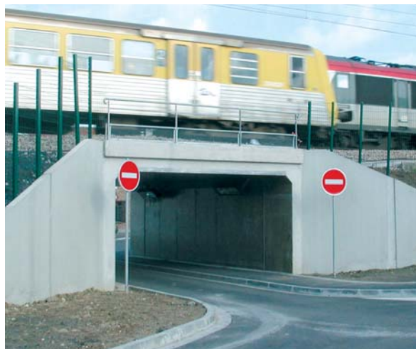
Ouvrage cadre à travée unique
