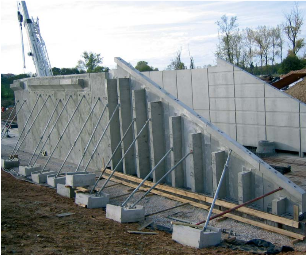
Étalement provisoire de piédroits et de murs
