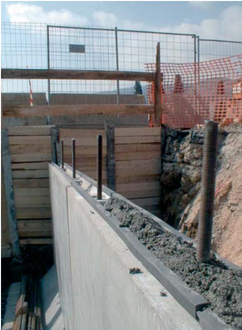
Mortier d'appui sous dalle de cadre
