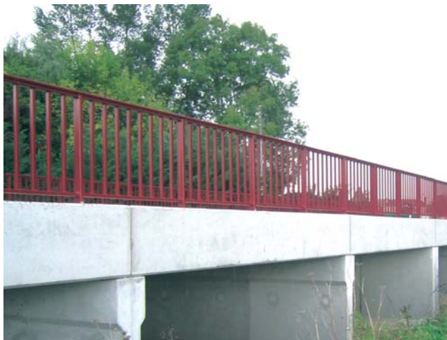
Ouvrage cadre à plusieurs travées
