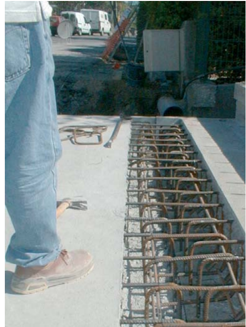
Clavage entre dalles préfabriquées
