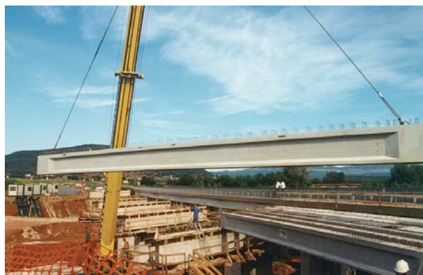
Produits préfabriqués équipés de systèmes intégrés de levage
