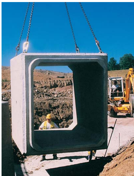
Produits préfabriqués équipés de systèmes intégrés de levage
