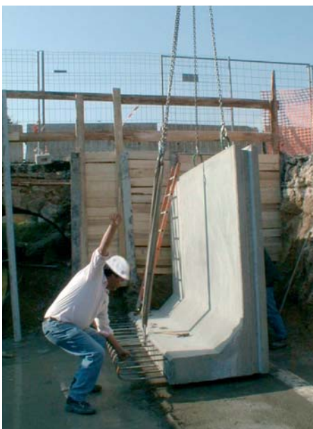
Étalement provisoire de piédroits et de murs
