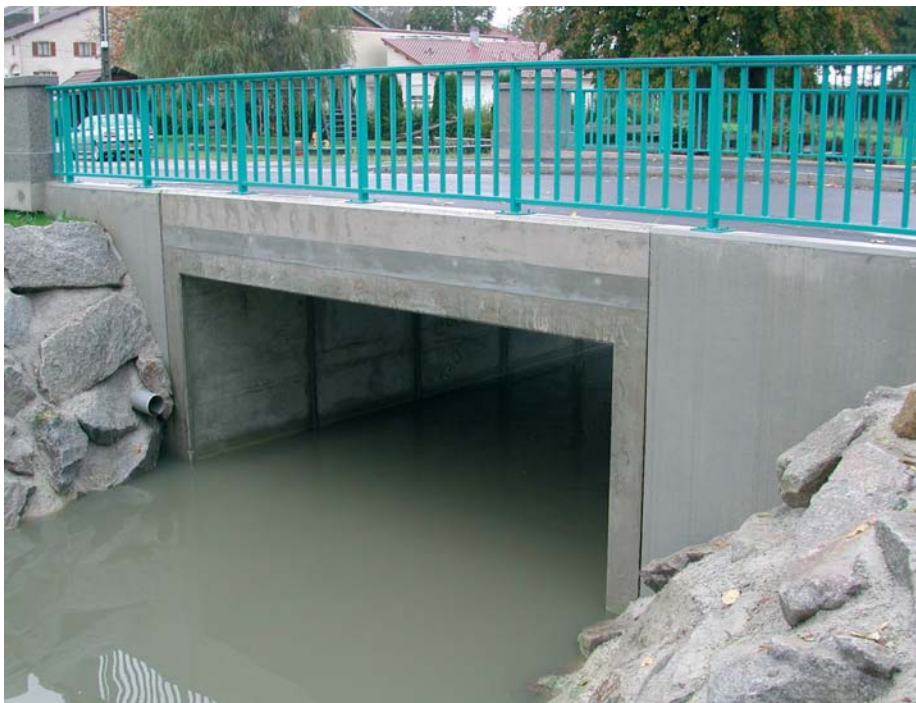
Cadre monolithique préfabriqué en béton
