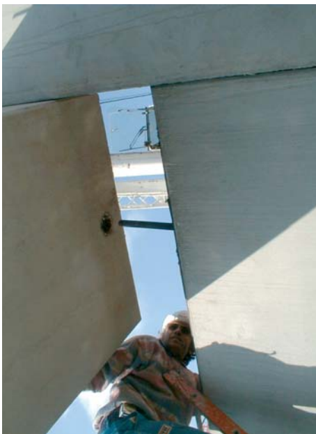
Pose et réglage de dalles
