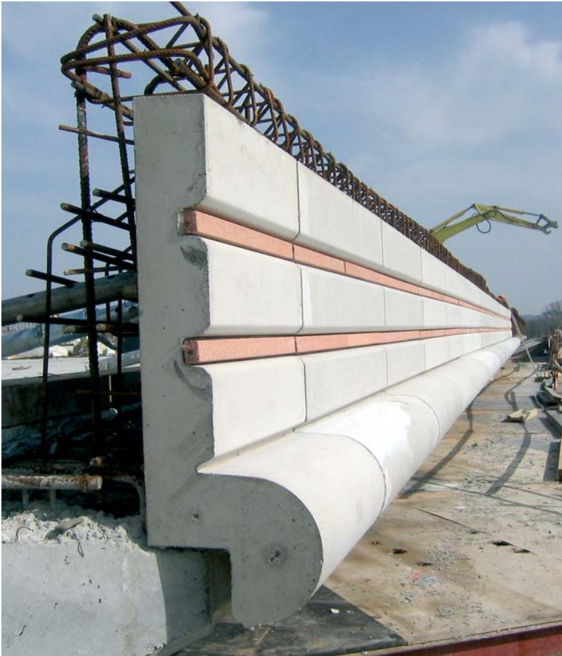
Pose de corniche de pont
