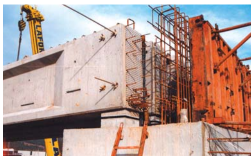
Dispositif de stabilisation de poutres PRAD
