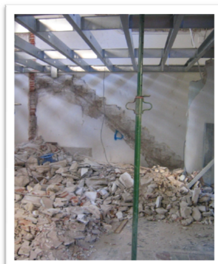
Figura 15. Obra de rehabilitación: forjado ligero
