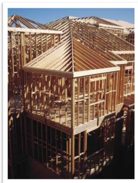
Figura 3. Edificación fabricada mediante el sistema “wood framing”
