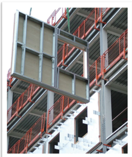
Figura 12. Fachada de paneles prefabricados
