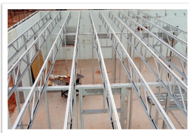
Figura 11. Forjado con vigas celosía ligeras
