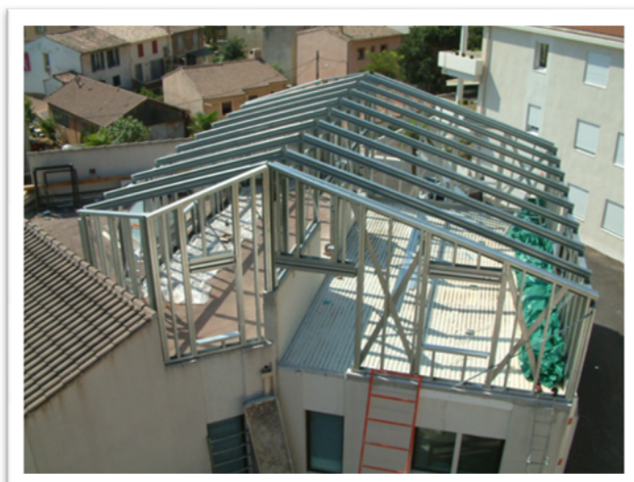
Figura 14. Obra de ampliación: construcción de una nueva planta
