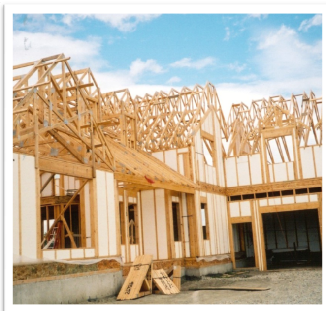
Figura 4. Edificación fabricada mediante el sistema “wood framing”
